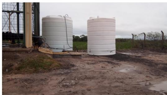
Imagen N° 34: Tanques de dosificación de Hipoclorito.
