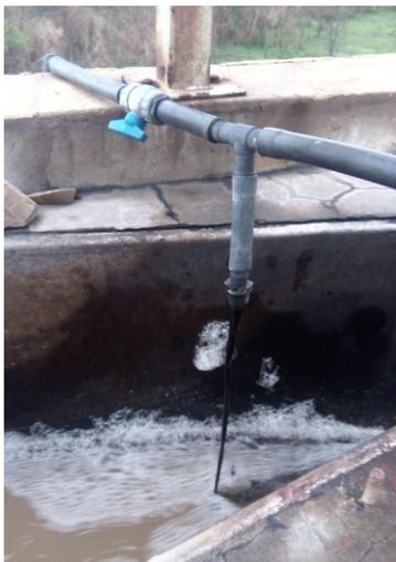
Imagen N° 37: Punto de inyección del carbono activado.
