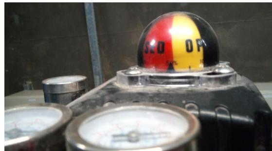
El equipo que se observa en la imagen es un posicionador de la válvula de filtración, el cual indica la apertura que tiene dicha válvula en cada instante.
