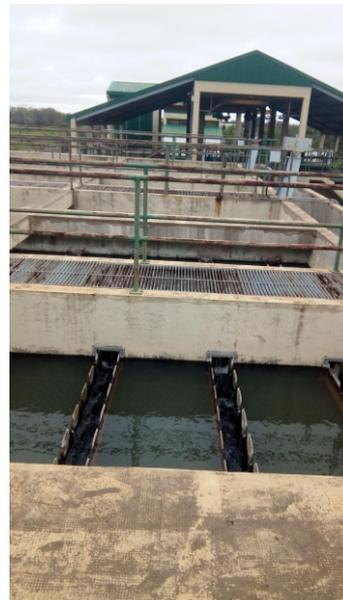
Se observa un agua decantada cristalina sin elevación de lodo floculante. Lo que indica un buen proceso de Floculación, coagulación y decantación.
