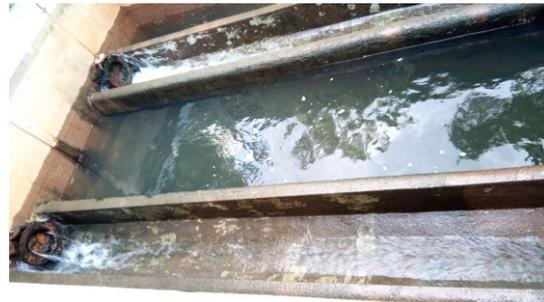
Imagen N° 30: Filtro Planta Potabilizadora Centro
