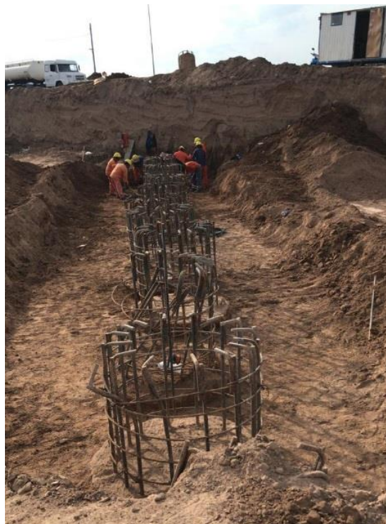
Figura 7. 6. Hormigonado de Pilotes Columnas
