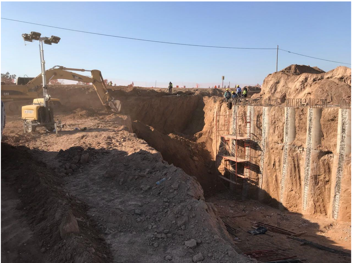
Figura 7. 7. Apertura de Trincheras
