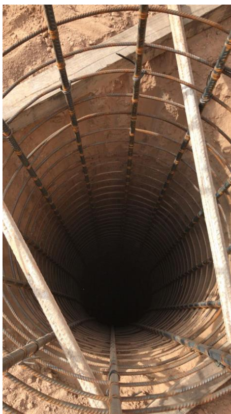
Figura 7. 1. Pozo y Armadura de Pilotes - Columnas
