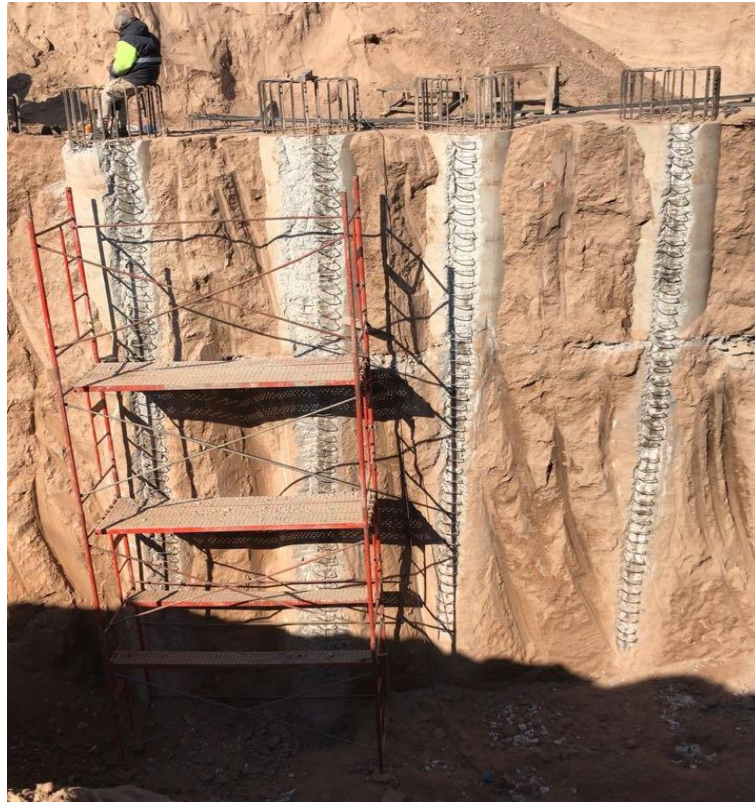
Figura 7. 9. Excavación Pantalla Frontal
