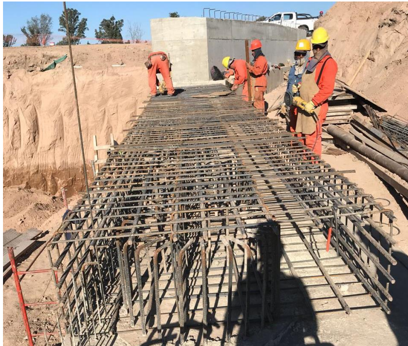
Figura 7. 15. Armadura de Viga Riostra Lateral
