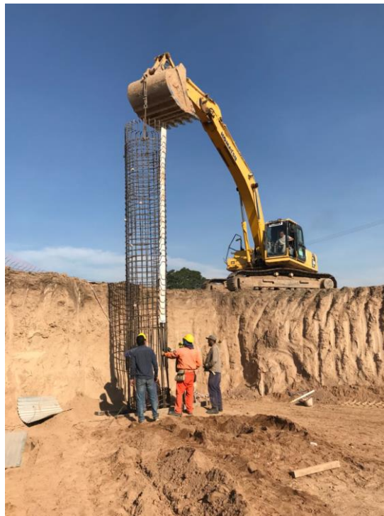
Figura 7. 4. Ubicación de Armaduras de Pilotes - Columnas
