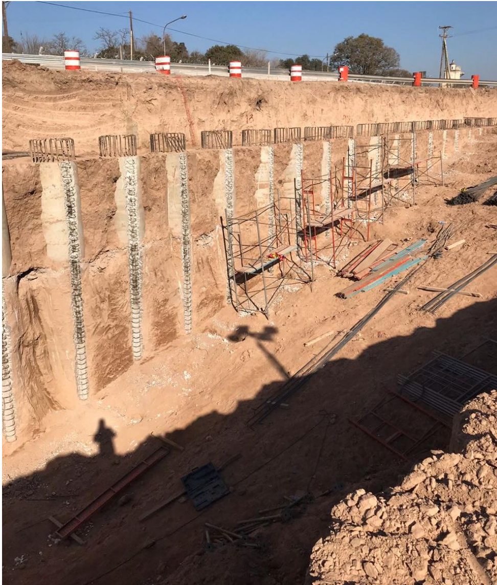
Figura 7. 8. Excavación Pantalla Lateral
