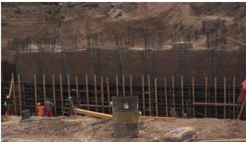
Figura 7. 12. Encofrado de Pantalla Frontal
