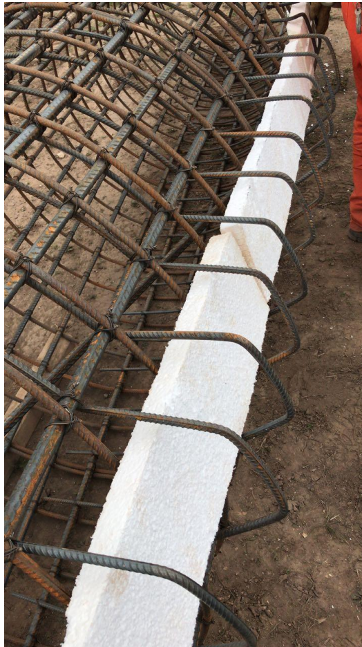
Figura 7. 2. Armadura de Pilotes-Columnas
