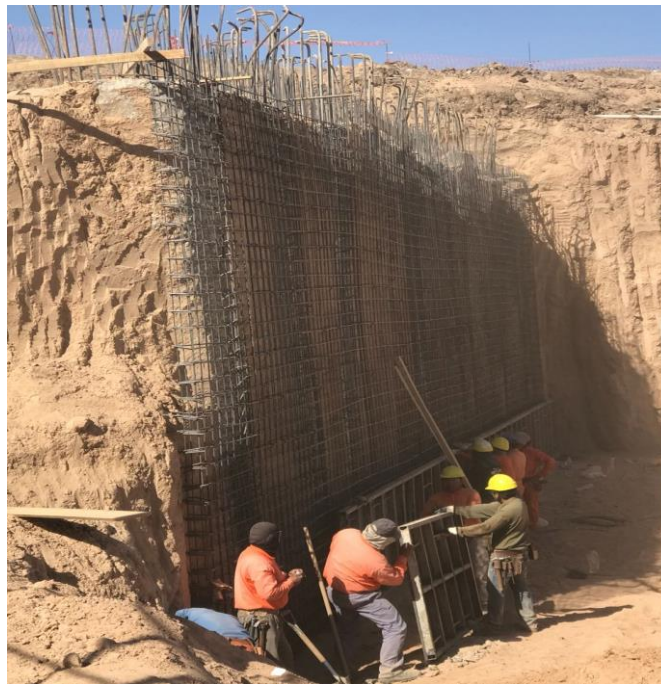
Figura 7. 11. Armadura de Pantalla Frontal
