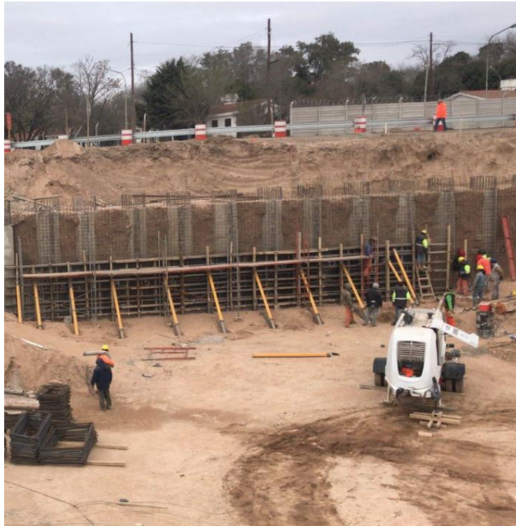
Figura 7. 13. Armadura y Encofrado de Pantalla Lateral
