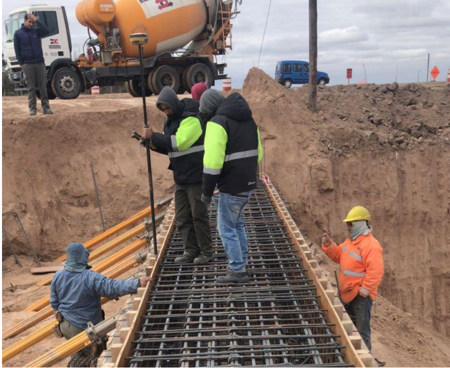
Figura 7. 17. Encofrado de Viga Riostra Lateral
