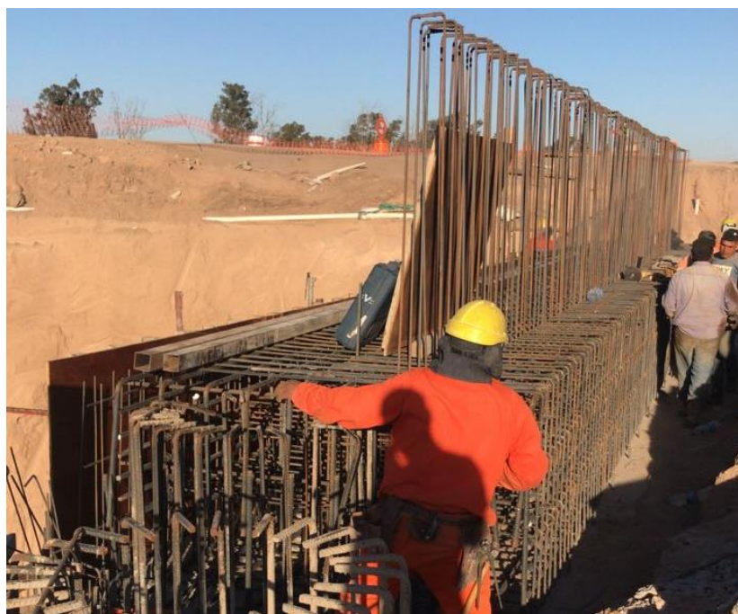
Figura 7. 16. Armadura de Viga Dintel
