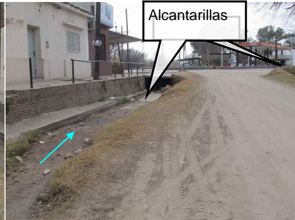
Foto 12: Alcantarillas en RN N°9.
