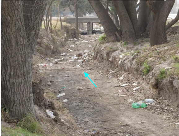
Foto 15: Cuneta Norte de ruta de enlace.
