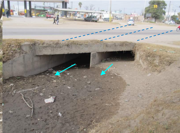
Foto 16: Alcantarillas desde cámara a cuneta.
