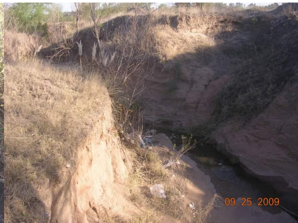
Foto 6: Erosión del canal hacia el Río
