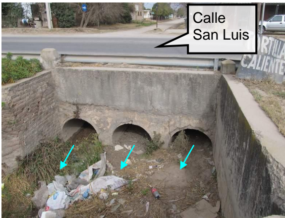
Foto 13: Descarga de alcantarillas circulares en cámara.
