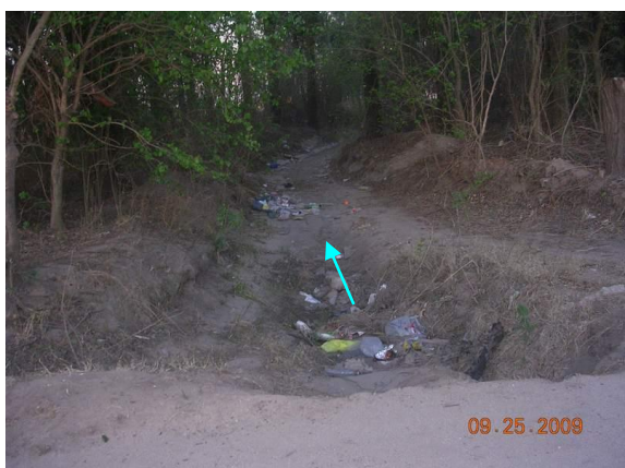
Foto 9: Canal salida de alcantarilla.
