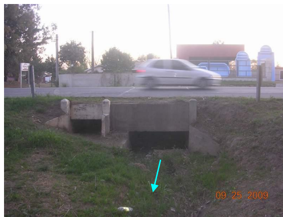
Foto 8: Alcantarilla de cruce RN N°9.
