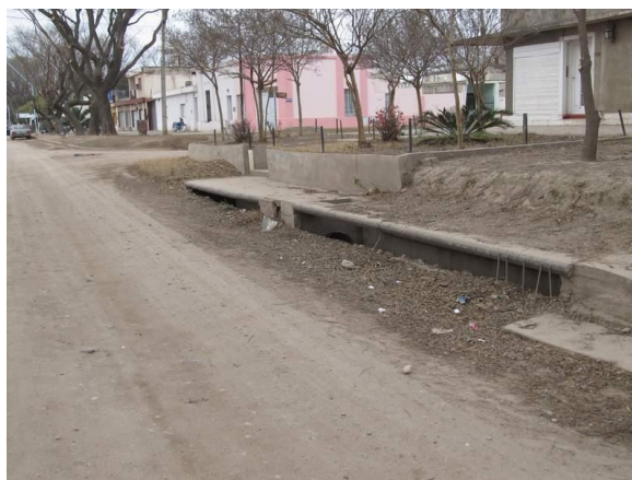
Foto 2: Sumidero en Bv. Roca – Inicio de conducto
