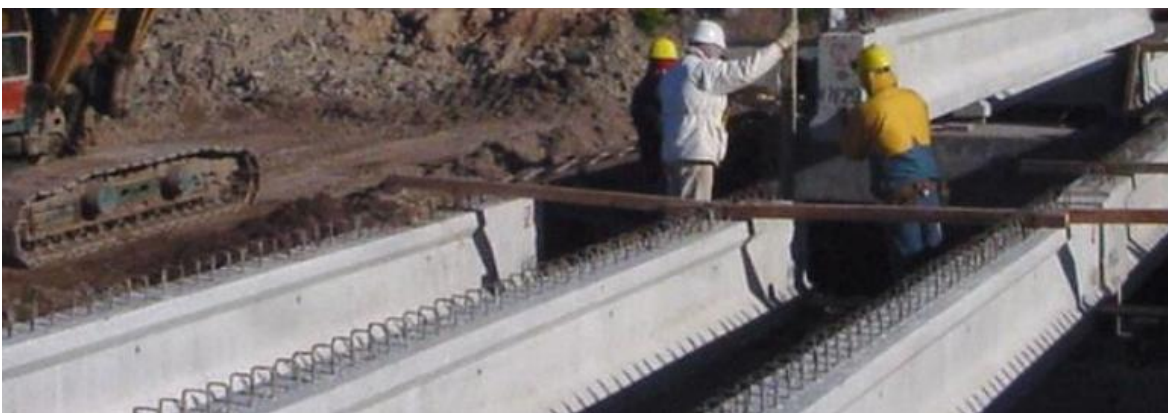
Figura 4.3: Barras en espera sobre vigas longitudinales
