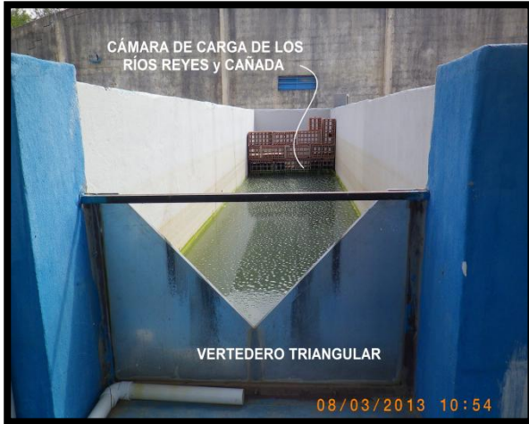
Figura 11: Cámara de aforo del Río Reyes
