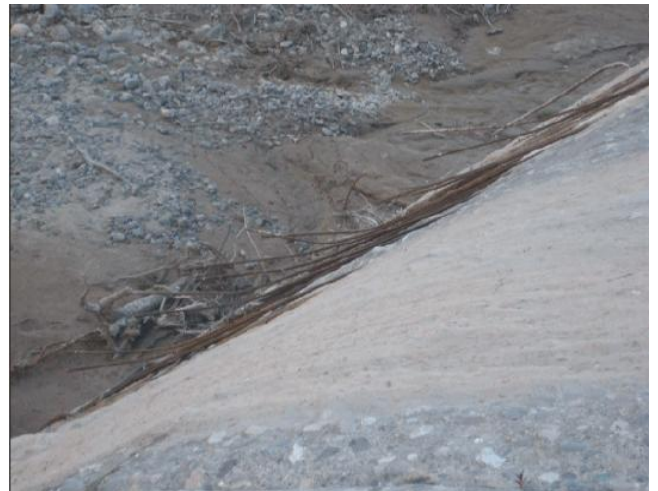
Figura 7: Abrasión del dique fijo.
