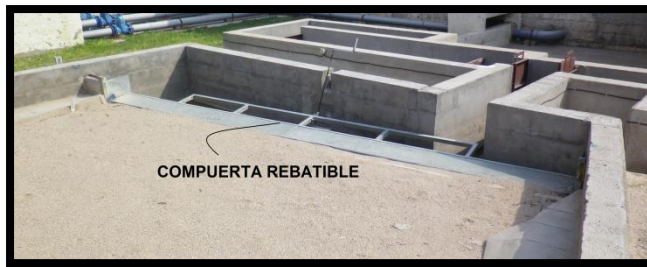
Figura 16: Compuerta rebatible
