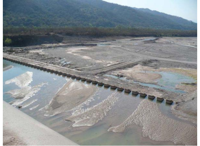
Figura 5: Erosión generalizada en el lecho del río
