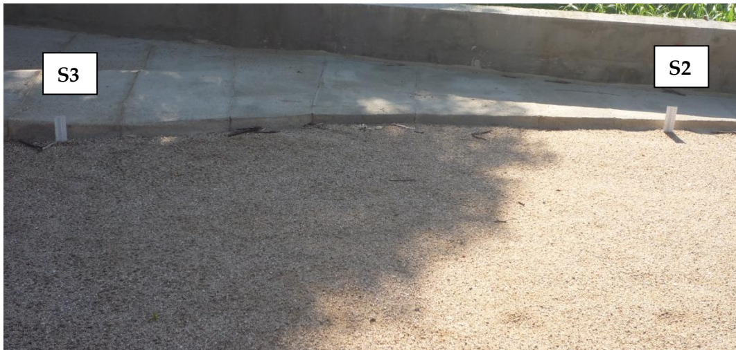
Figura 19: Escalas graduadas en las secciones 2 y 3, aguas abajo de la presa.
