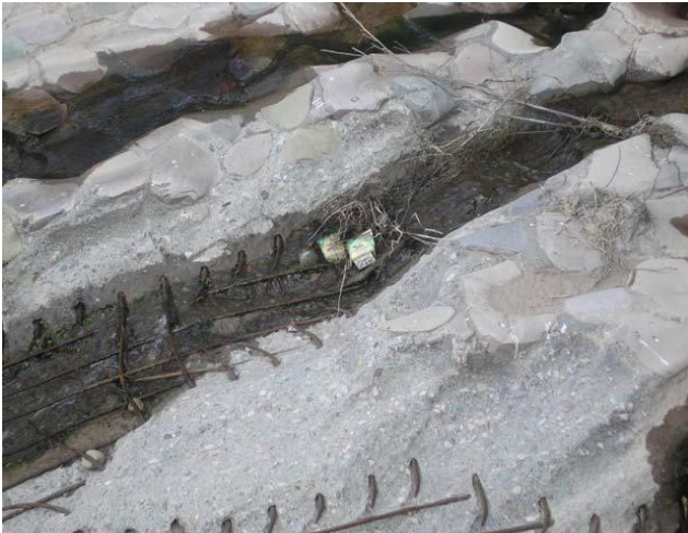
Figura 6: Abrasión del dique móvil.
