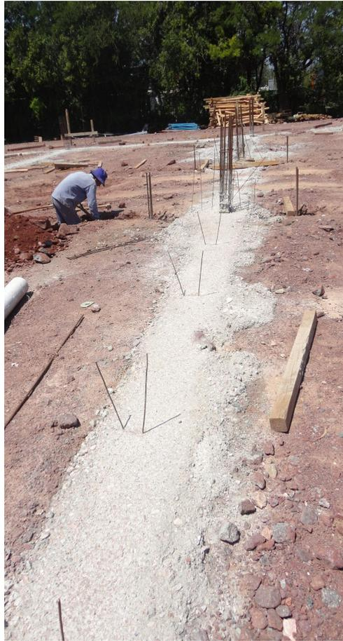
**Figura 5.49:** Viga riostra terminada.
