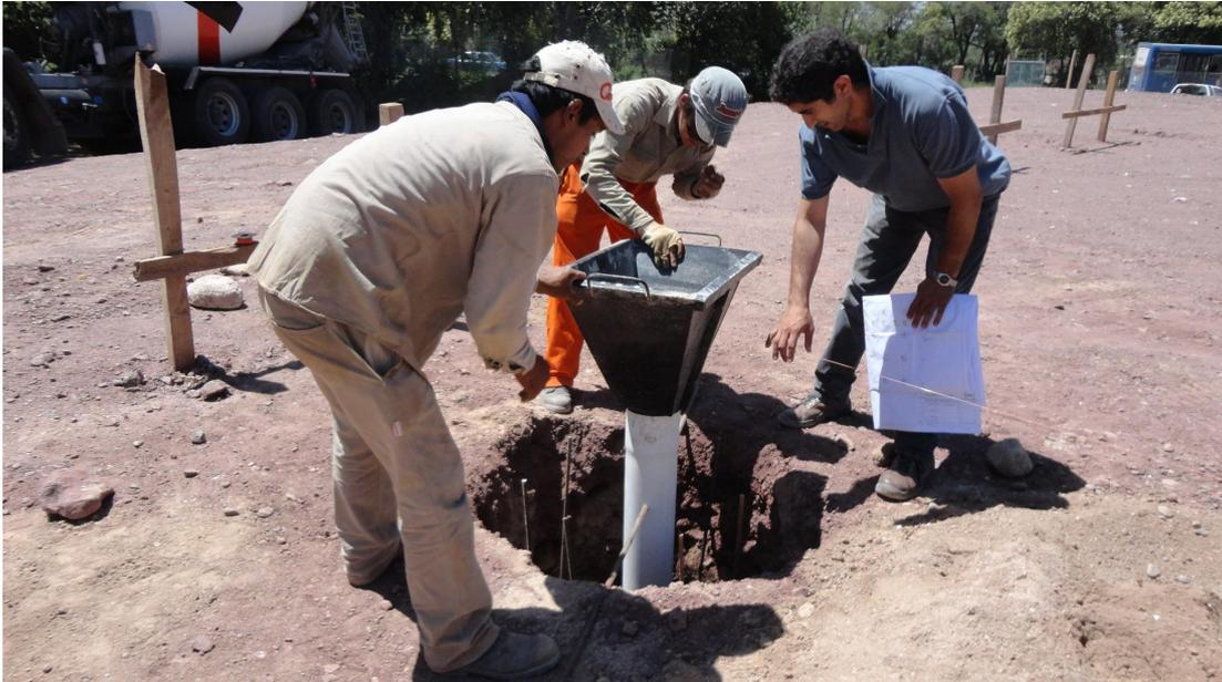
**Figura 5.15:** Colocación de la canaleta para el colado del hormigón.
