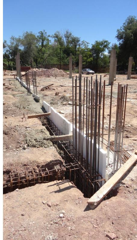
**Figura 5.73:** Junta de dilatación.
