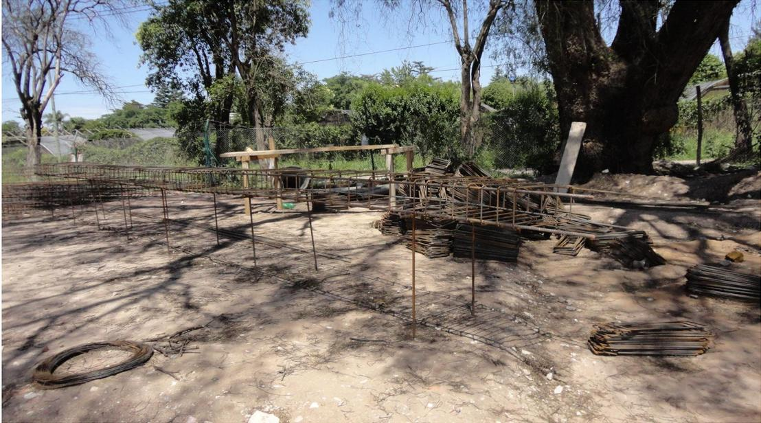
**Figura 5.39:** confección de armaduras para vigas riostras y de fundación.
