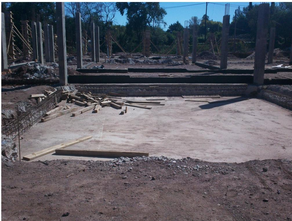
**Figura 5.63:** Losa sanitaria terminada.
