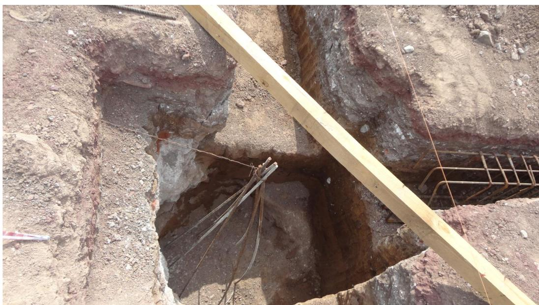
**Figura 5.56:** Excavación para cabezal.
