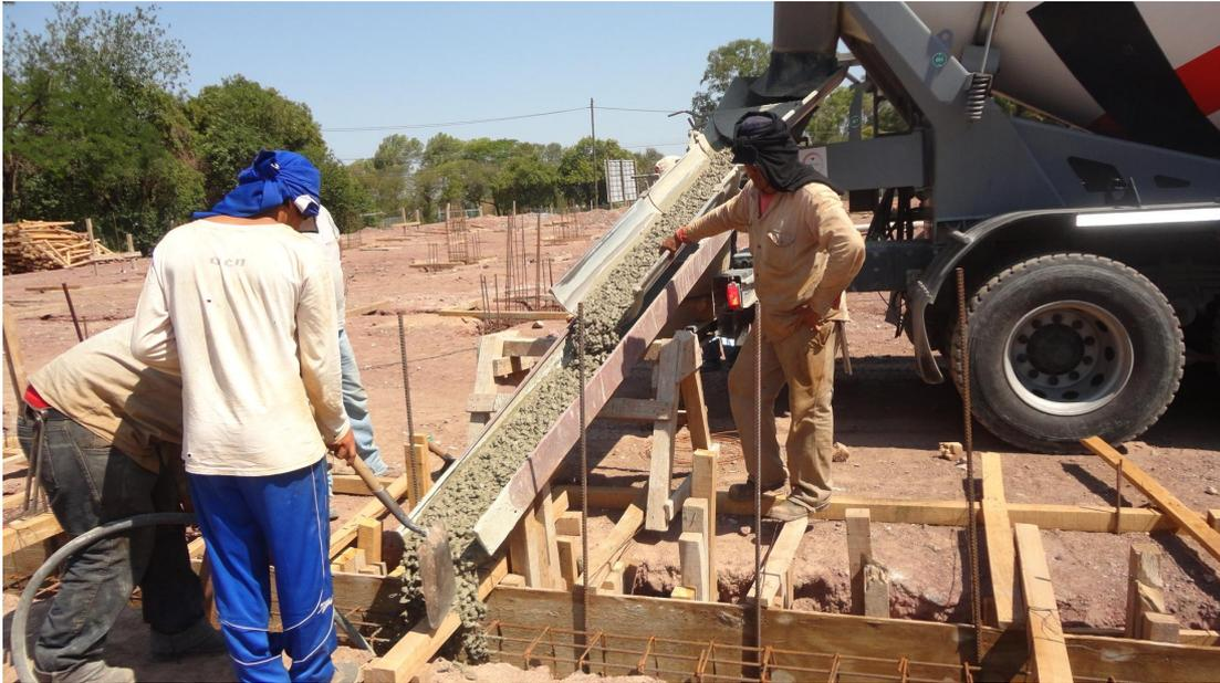
**Figura 5.68:** Hormigonado de viga riostra adyacente a una junta de dilatación.
