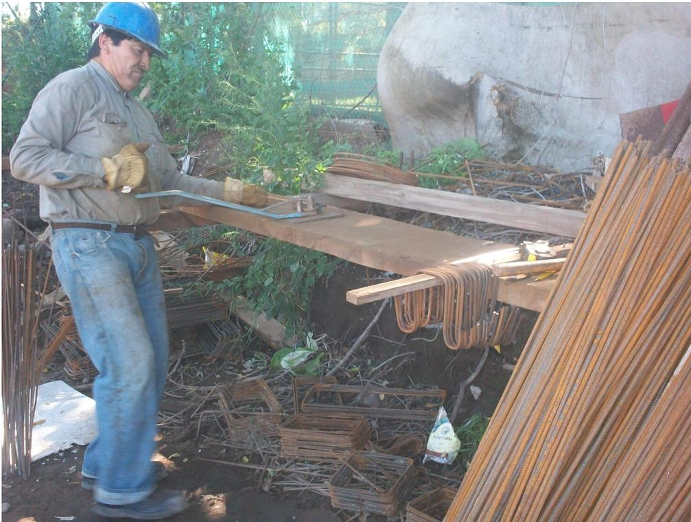
**Figura 5.38:** Doblado de armaduras.
