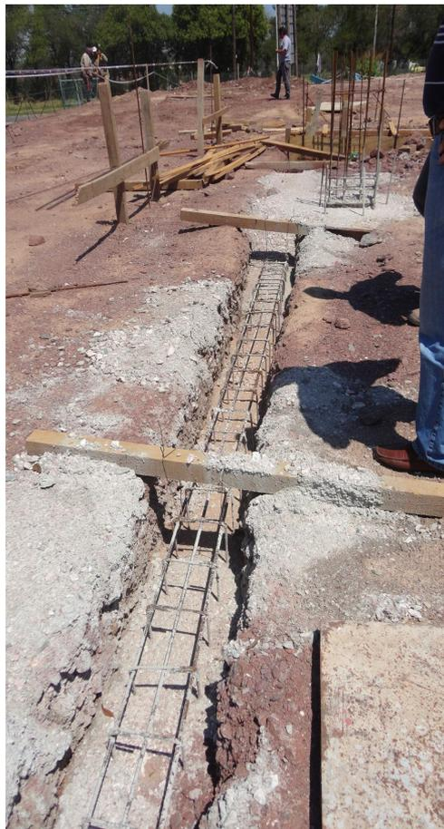
**Figura 5.59:** vigas de fundación perimetrales.
