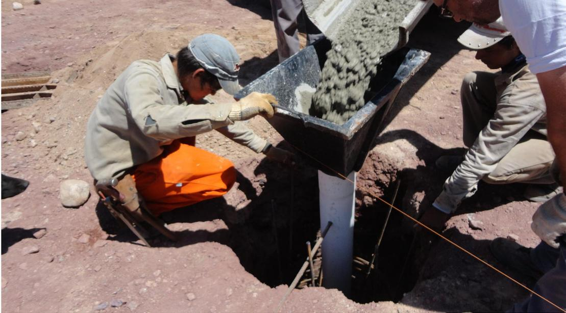
**Figura 5.17:** Colado del hormigón por medio de manga.
