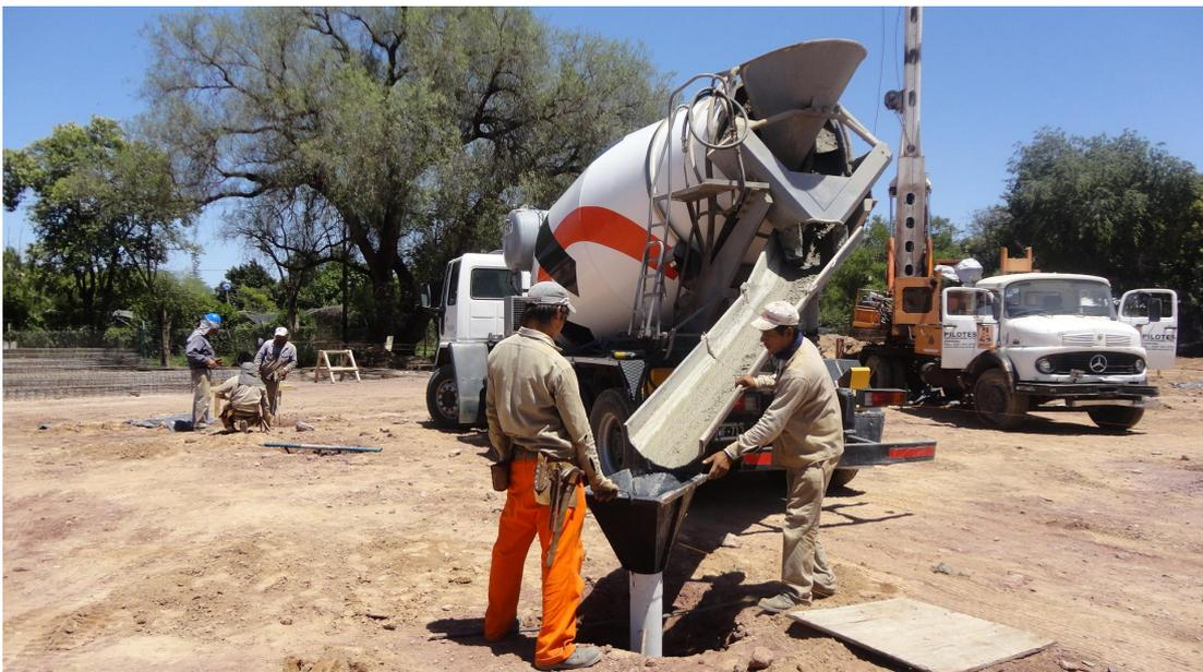
**Figura 5.16:** Colado del hormigón por medio de manga.
