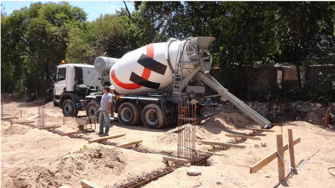
**Figura 5.45:** Colado de hormigón en vigas riostras y de fundación.
