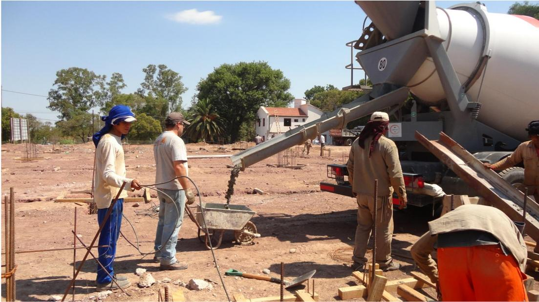
**Figura 5.21:** Extracción de muestra para la elaboración de probetas.
