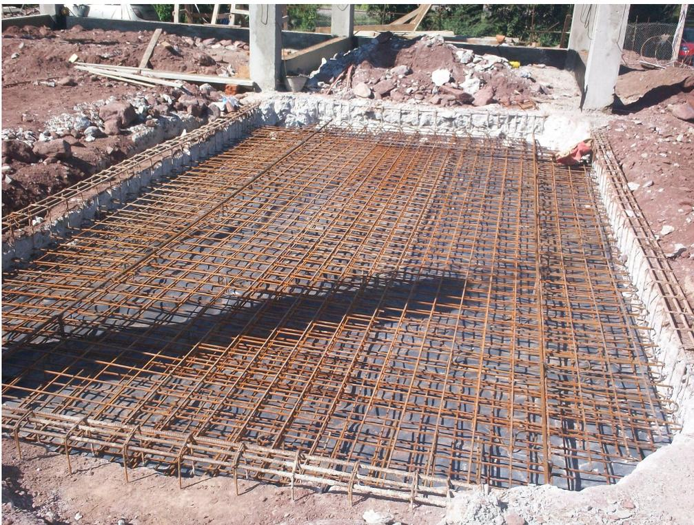
**Figura 5.61:** Losa sanitaria lista para hormigonar.
