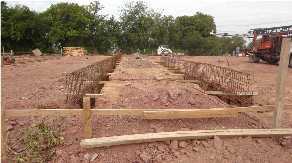
**Figura 5.40:** Disposición de armaduras para realizar en encuentro se vigas.
