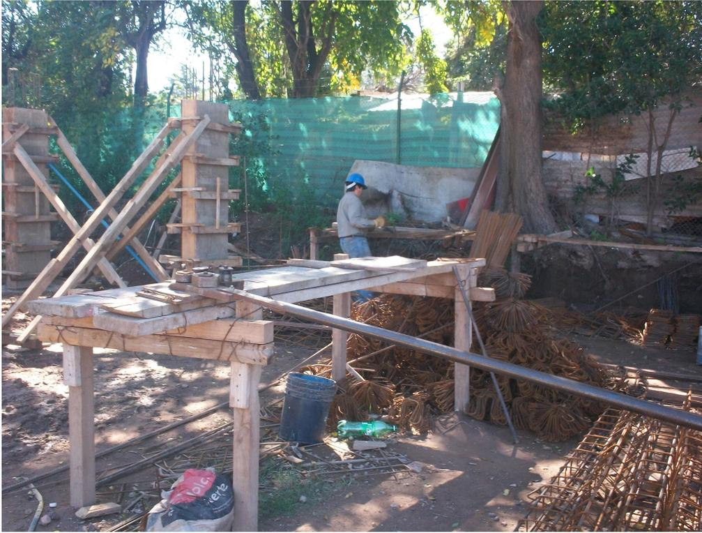
**Figura 5.37:** Sector destinado al doblado de armaduras.
