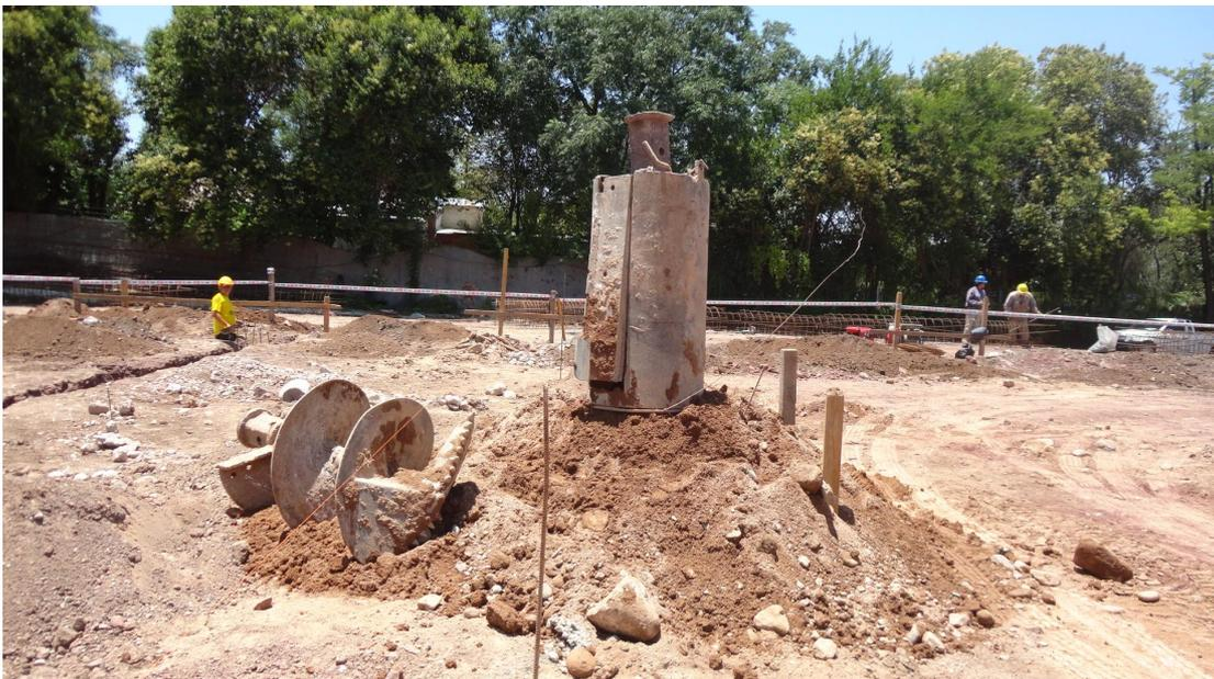
**Figura 5.7:** Herramientas utilizadas para excavación de pozos y ensanche de campana.
