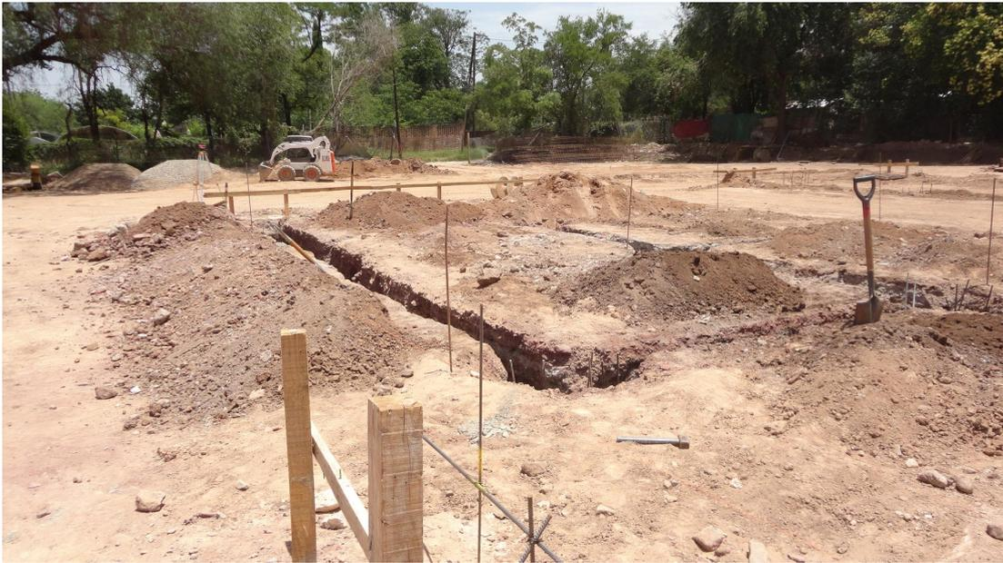
**Figura 5.36:** Excavación de vigas riostras y de fundación.
