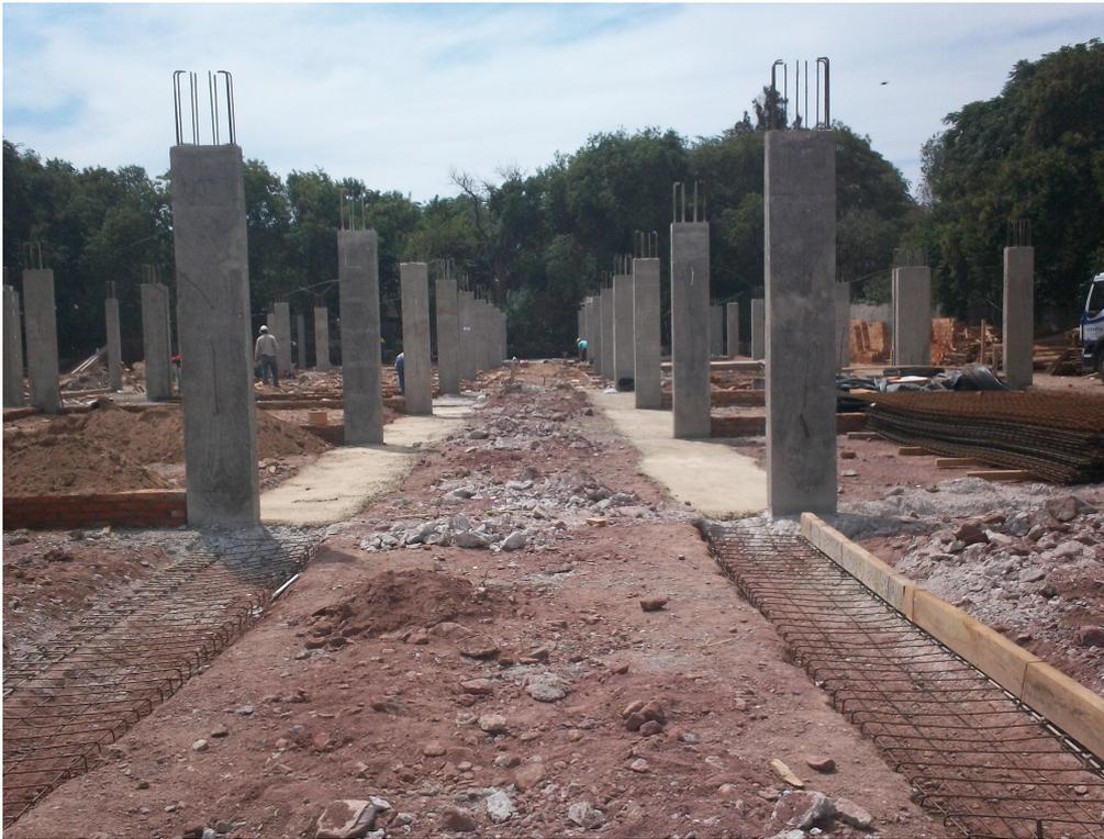
**Figura 5.66:** Vista de las planchetas de fundación.
