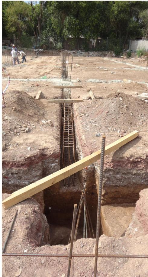
**Figura 5.57:** Excavación para cabezal.
