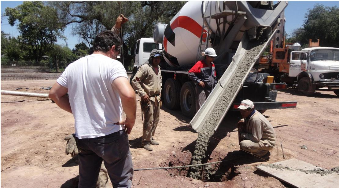
**Figura 5.18:** Colado del hormigón desde la superficie por medio de canaleta.
