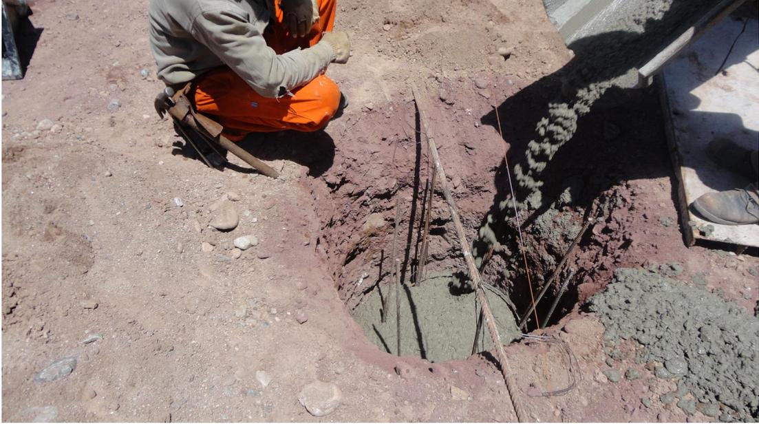
**Figura 5.19:** Colado del hormigón desde la superficie por medio de canaleta.
