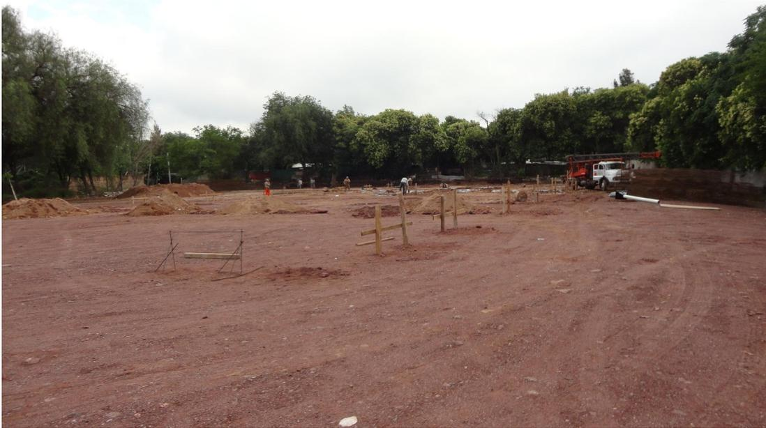
**Figura 5.4:** Corralito parcial para el replanteo de pilotes.
