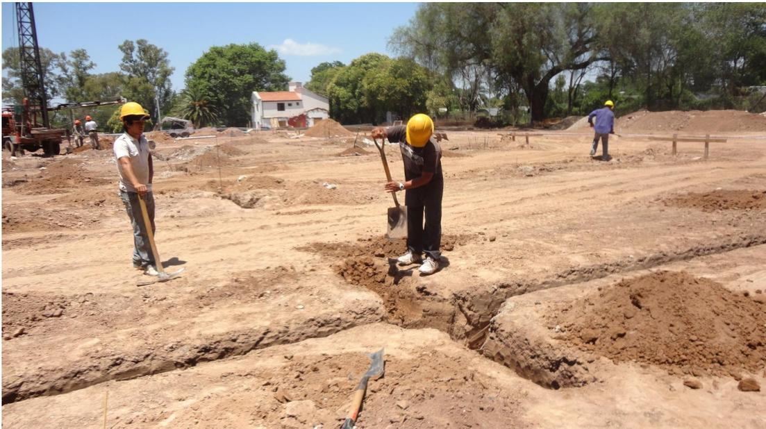
**Figura 5.35:** Excavación de vigas riostras y de fundación.
