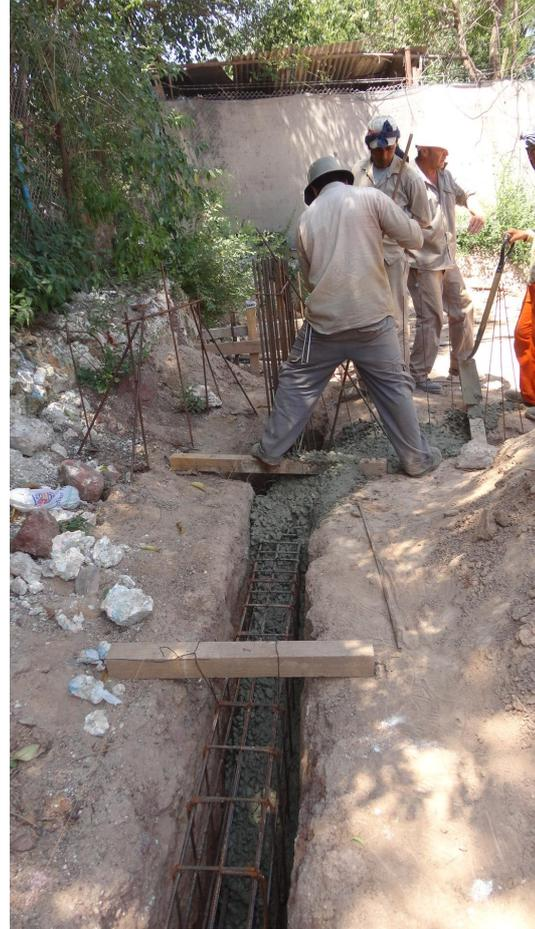
**Figura 5.46:** Hormigonado de vigas riostras. **Figura 5.47:** Hormigonado de vigas riostras.
