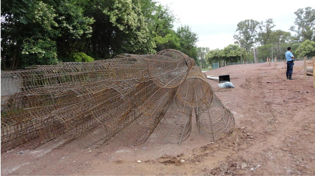
**Figura 5.13:** Acopio de armaduras listas para la colocación.
