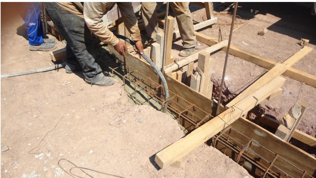
**Figura 5.69:** Vibrado de viga riostra adyacente a una junta de dilatación.
