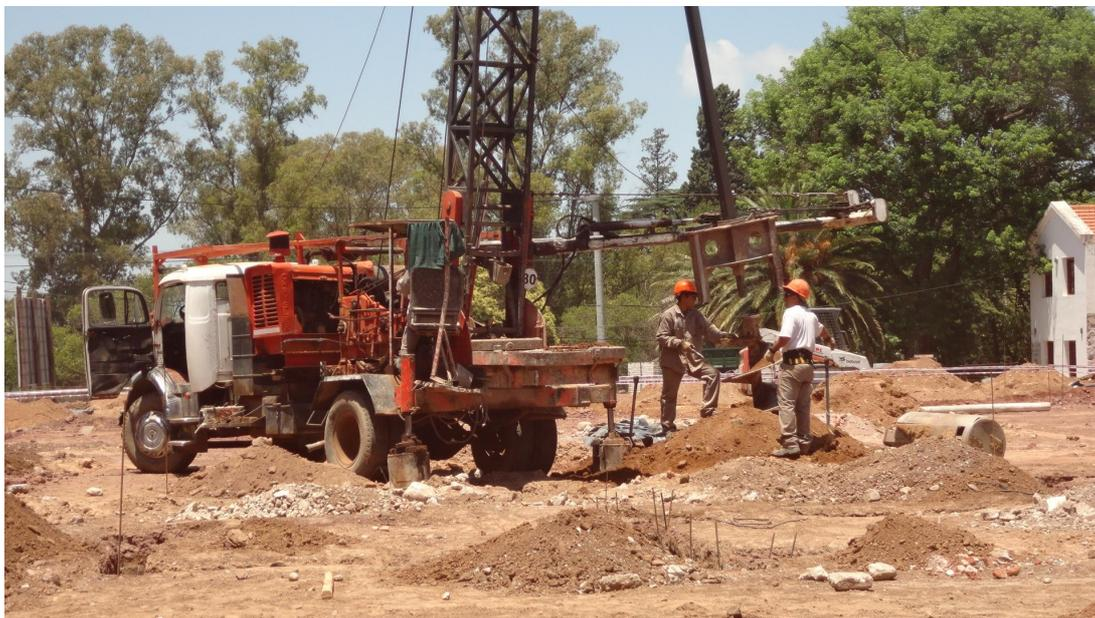
**Figura 5.8:** Cambio de mecha por herramienta ensanchadora de campana.
