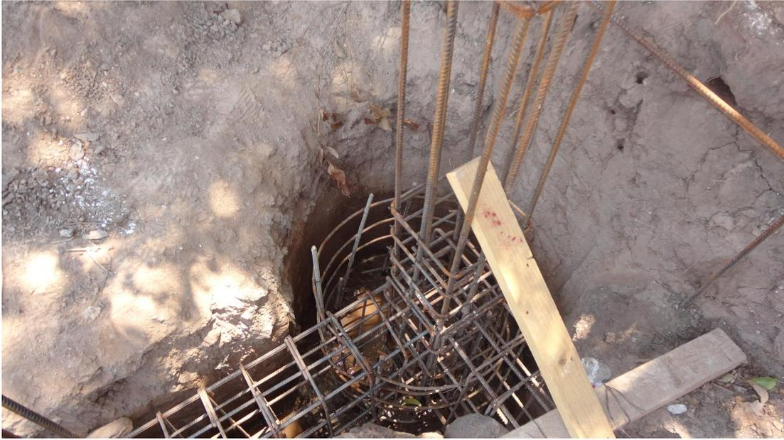
**Figura 5.52:** Viga riostra con agua y barro en su interior por lluvia.
