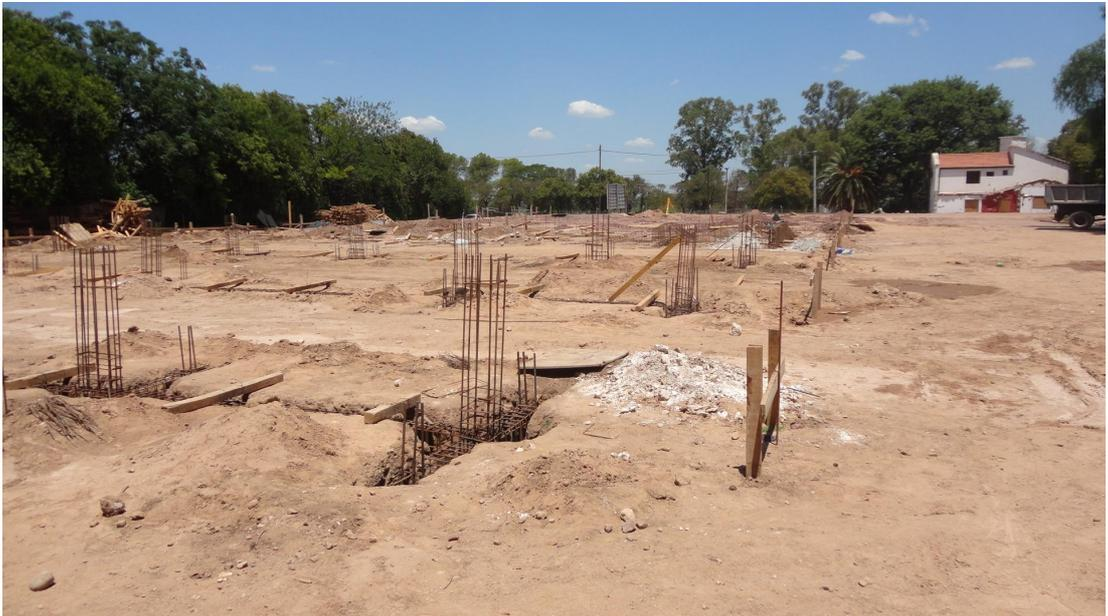
**Figura 5.44:** vigas riostras listas para hormigonar
