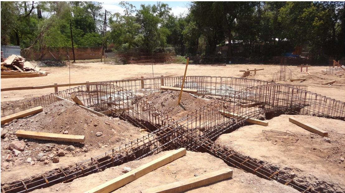
**Figura 5.42:** Descenso de las armaduras dentro de las excavaciones.
