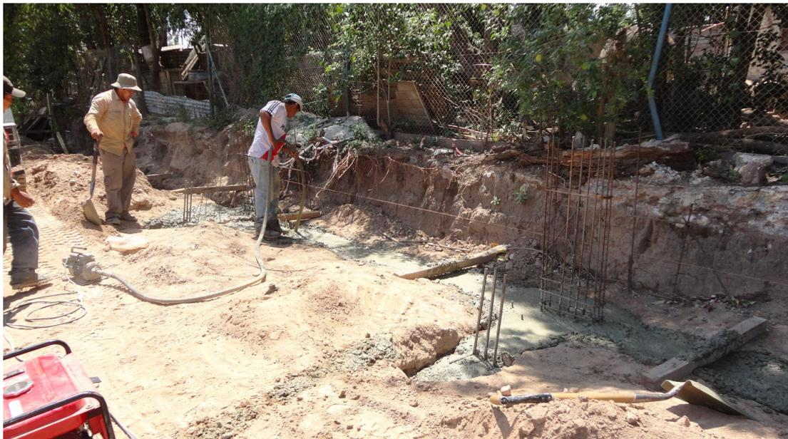
**Figura 5.48:** Vibrado de hormigón en vigas riostras.
