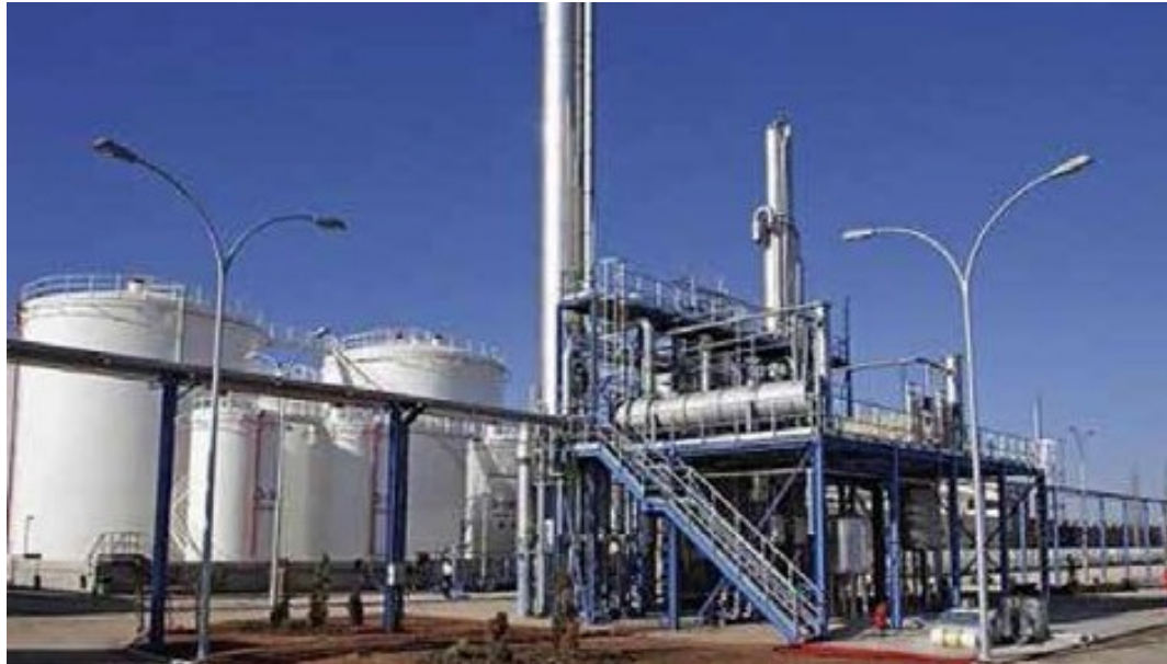
Figura 3-3 Construcción de planta de Bioetanol
