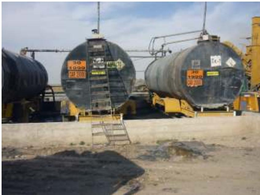
Fig. 3.7 Tanques de almacenamiento con cartelería y ruptores de vacío.
