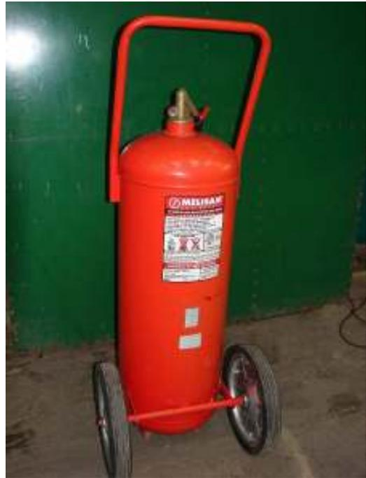
Fig. 3.9 Matafuego 25kg con carro para uso en planta.
