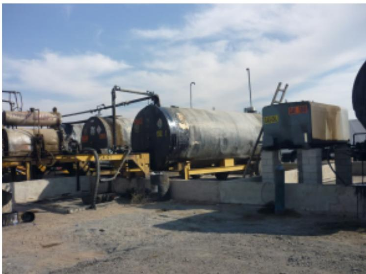
Fig. 3.6 Tanques de almacenamiento alojados dentro del recinto anti derrames. También se observa el tanque de reserva de gasoil que alimenta la caldera
