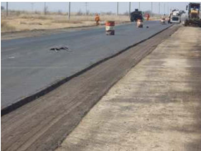
Fig. 2.7 Fresado de extremo de calzada existente, bacheo con base negra y restitución de banquina. Tareas subcontratadas a FOROBRA SA.
