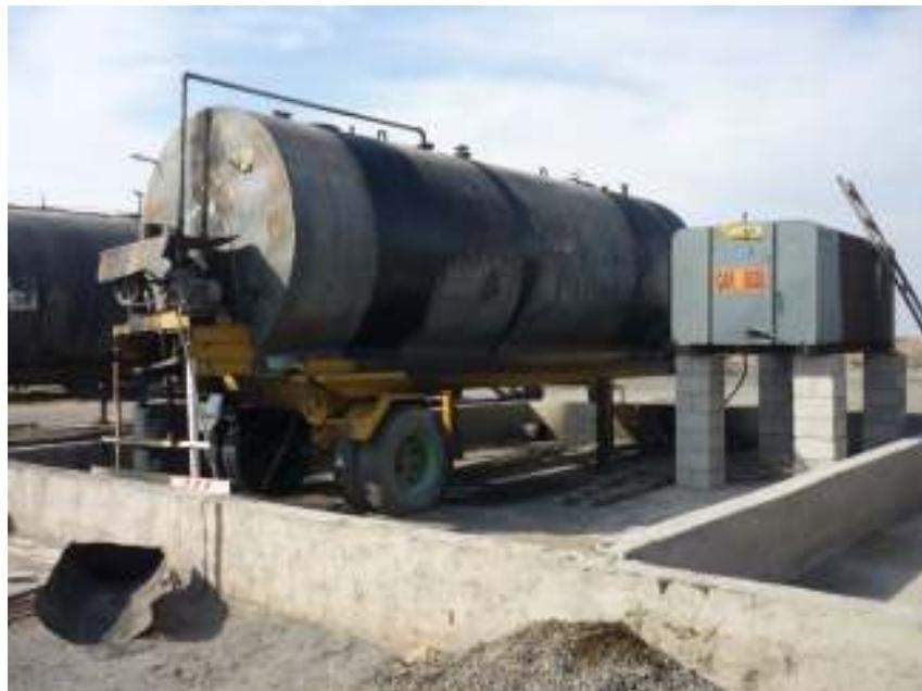
Fig. 3.8 Recinto anti derrames, impermeable con muros cortafuego.
