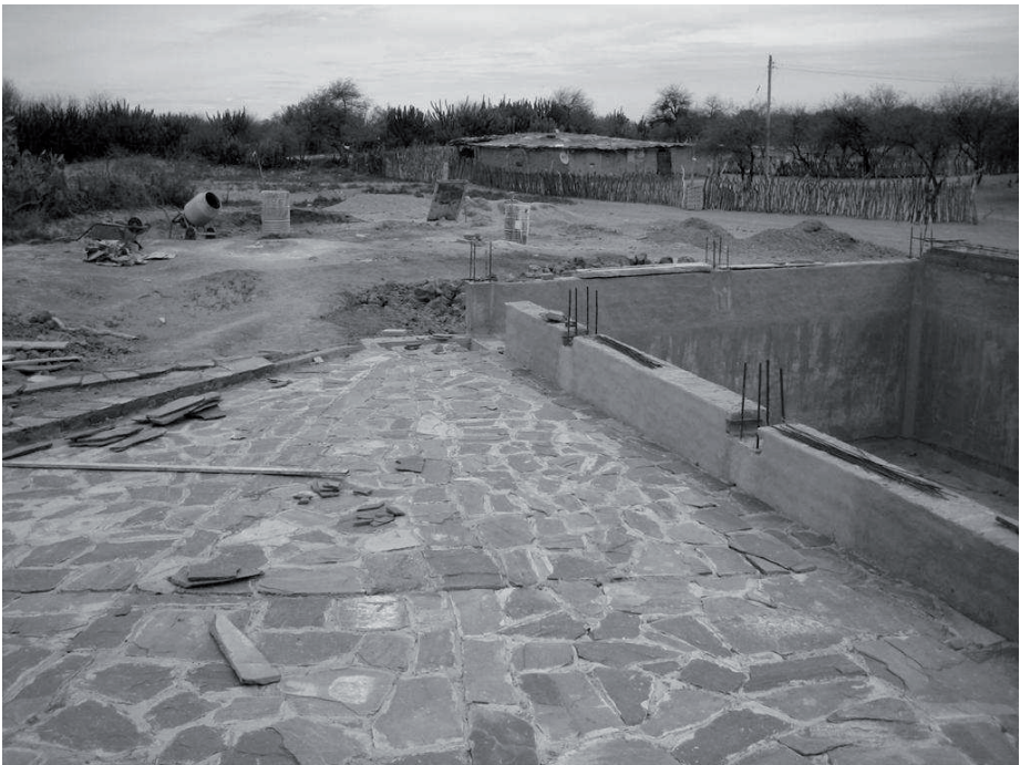
Figura 10.2: Cisterna en construcción en Palo Santo, Salinas Grandes (Catamarca). En la cabecera de la cisterna, el desarenador. © M. Karlin.
