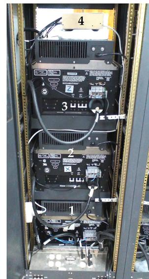
Figura 4.8: Fotografía del rack con los 3 amplificadores de gradientes utilizados. Los números 1 – 3 indican los amplificadores, el número 4 indica el sistema de protección fabricado para prevenir fallas de los amplificadores (ver texto).
