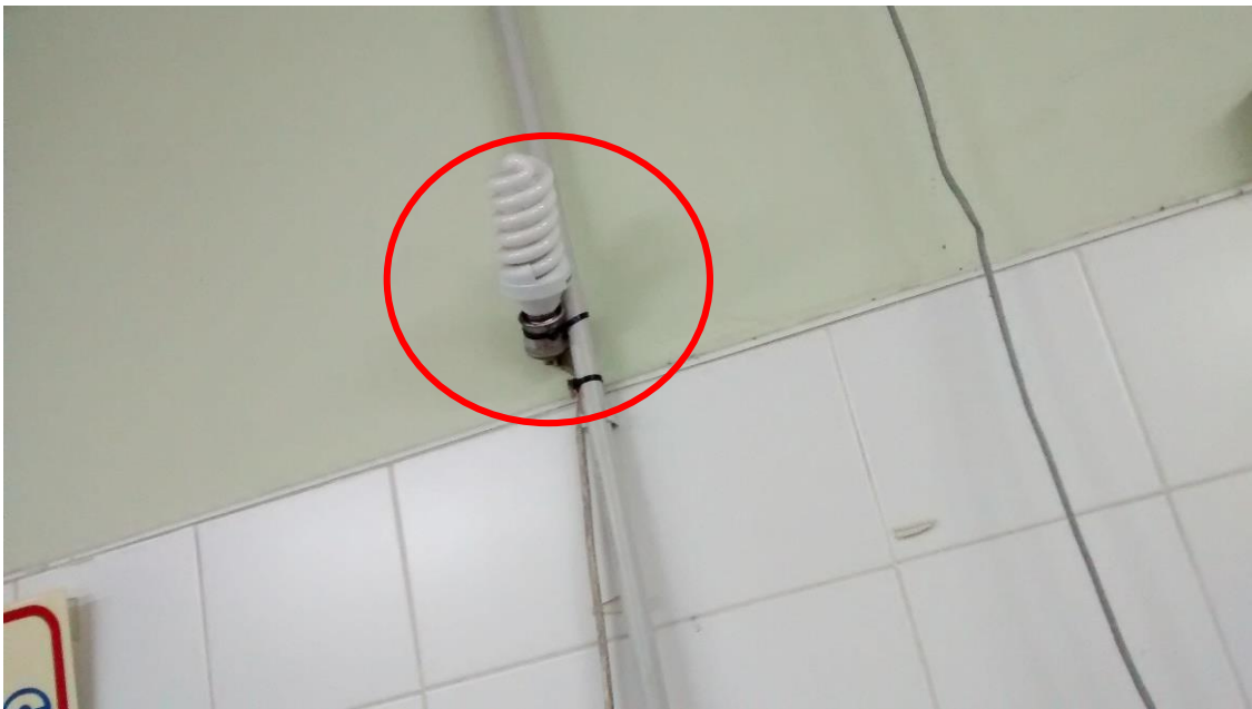
Foto 20. Pasillo de circulación
