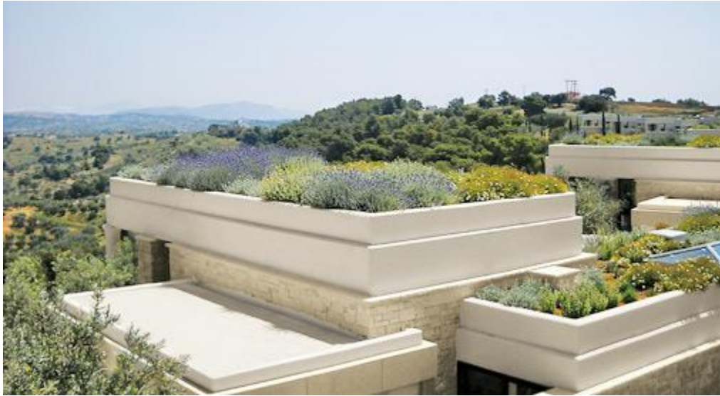
Figura 21. Cubierta vegetal semi-extensiva
