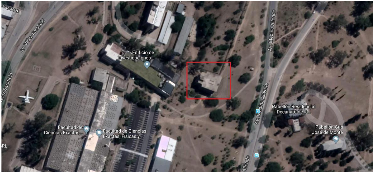
Figura 2. Vista aérea de la Ciudad Universitaria de Córdoba
