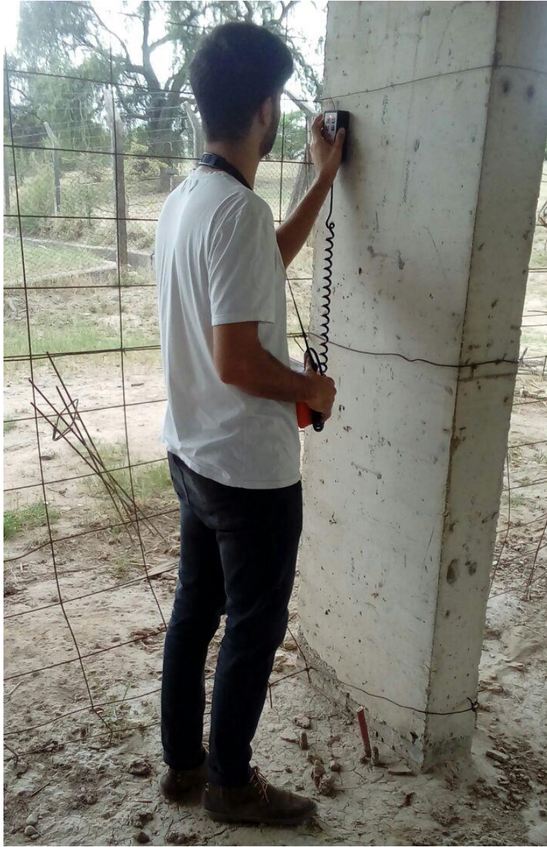
Figura 14. Uso del localizador de armadura – Visita Técnica
