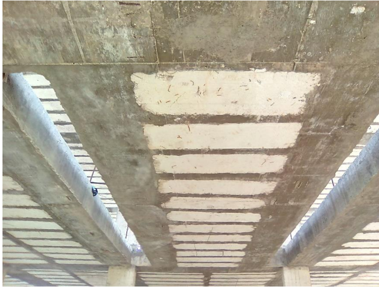
Figura 9. Losa N°10 – Visita Técnica
