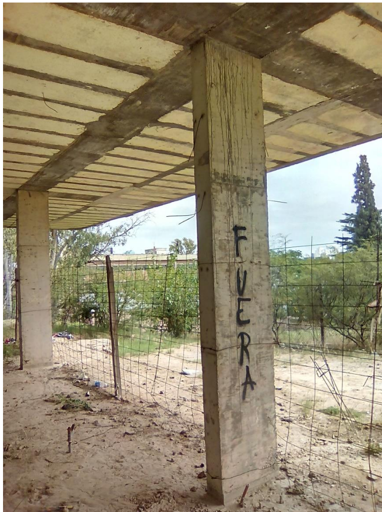
Figura 10. Columna N°10 – Visita Técnica
