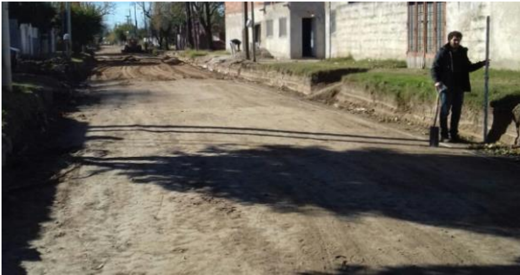
Figura 31. Nivelación de la subrasante de la calle San Marino entre Varsovia y Praga.
