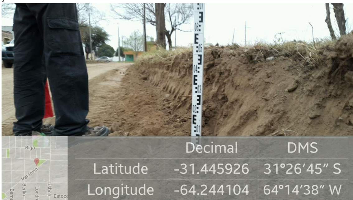
Figura 45. Espesor del desmonte de la calle De Isasi entre Varsovia y Tirana.
