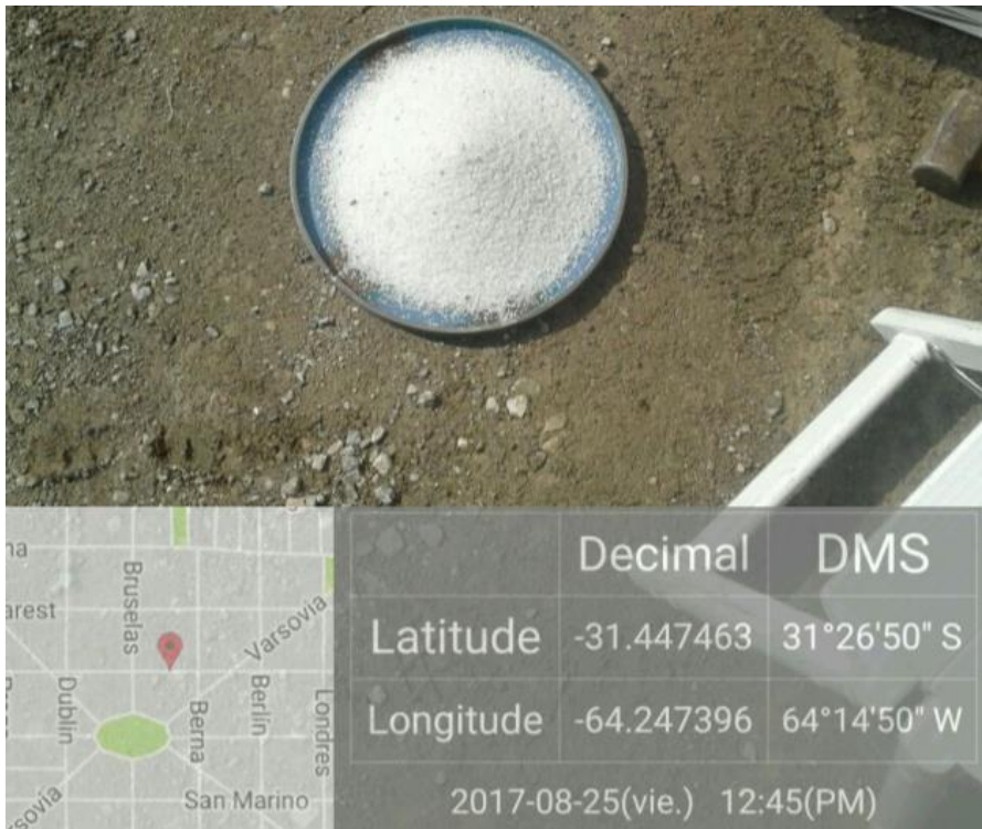
Figura 47. Ensayo de Base granular en la calle Ámsterdam entre Avdor. Petirosi y Berna.
