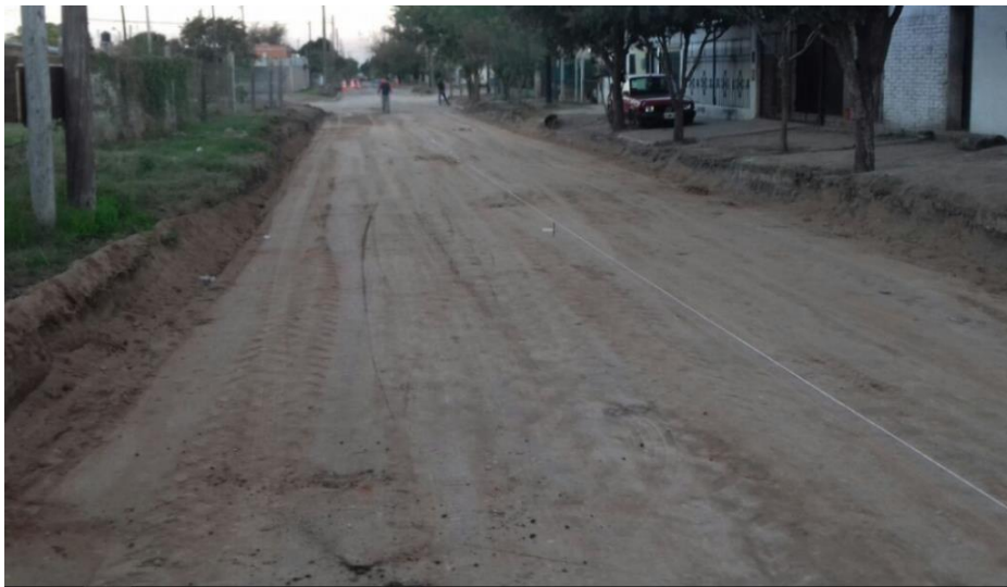
Figura 33. Nivelación de la subbase de la calle San Marino entre Berna y Copenhague.
