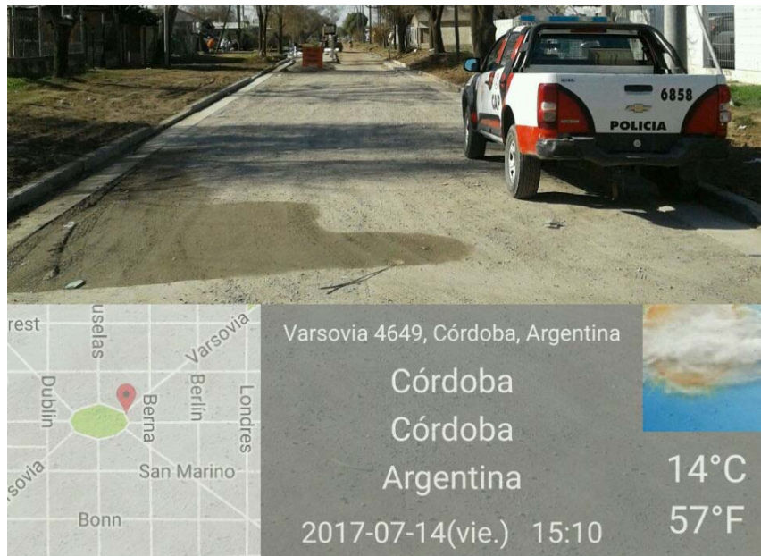
Imagen 7. Base granular entre Rotonda y Berna.
