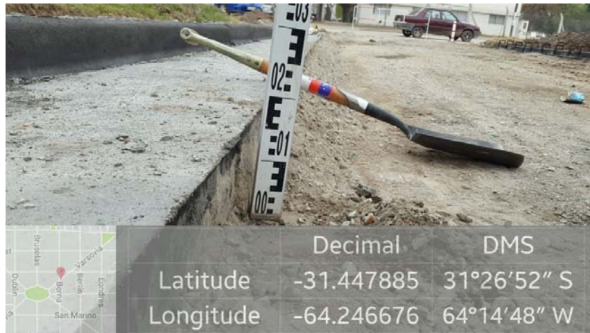
Imagen 7. Cordón cuneta Varsovia entre Rotonda y Berna.
