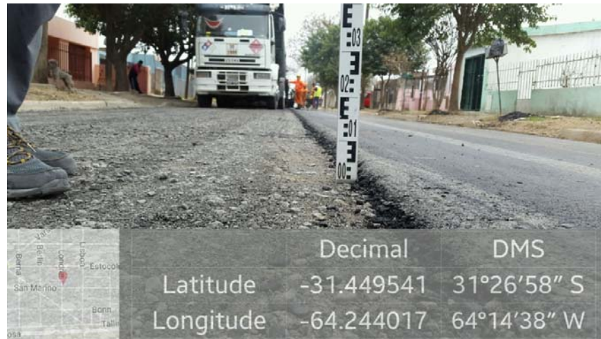
Imagen 23. Carpeta asfáltica De Isasi entre Estocolmo y San Marino.
