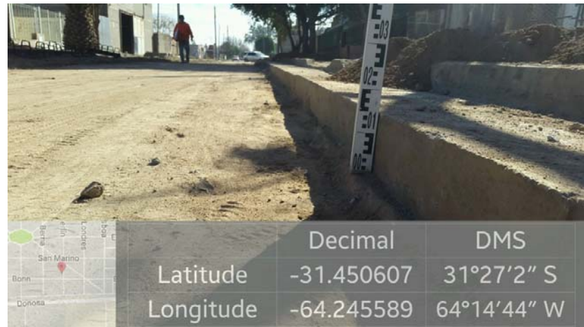
Imagen 17. Cordón cuneta Berlín entre Copenhague y Bonn.
