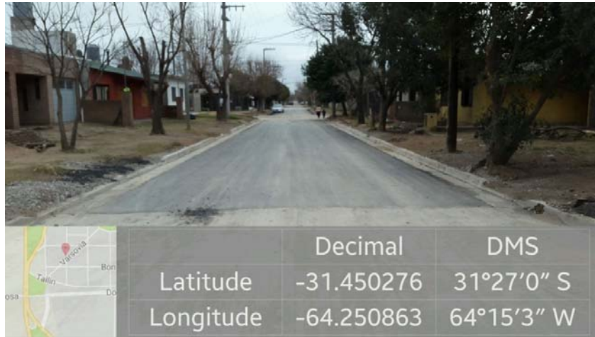
Imagen 8. Carpeta asfáltica entre San Marino y Varsovia.
