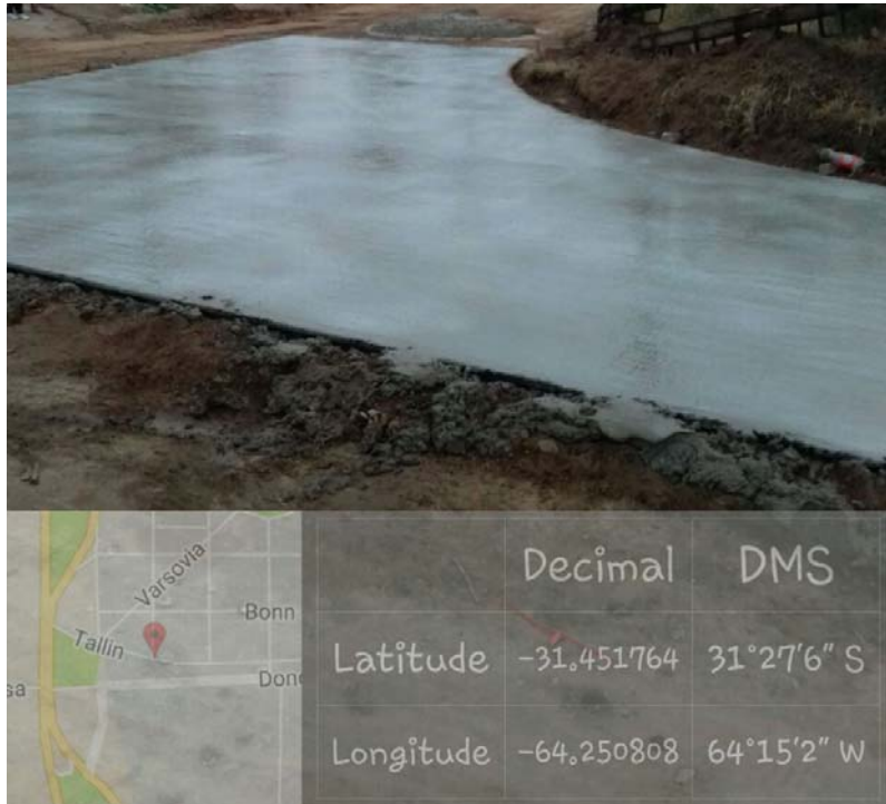
Imagen 7. Hormigón bocacalle con Praga.
