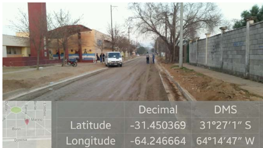
Imagen 13. Base granular entre Avdor, Petirosi y Berna.
