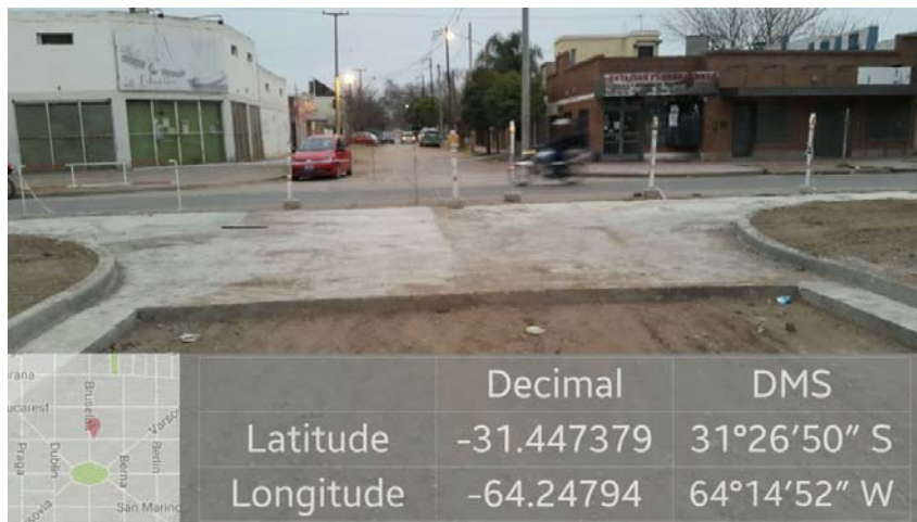
Imagen 1. Demolición y hormigón ¼ bocacalle con Avdor. Petirosi.
