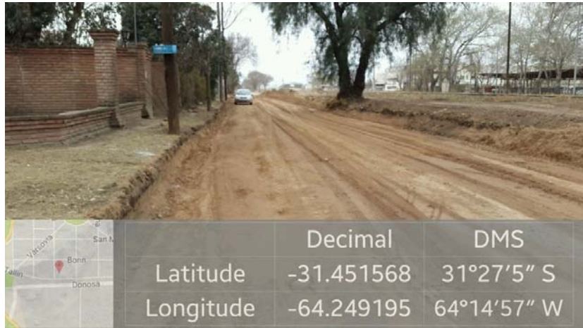
Imagen 9. Subbase entre Avdor. Petirosi y Dublín.
