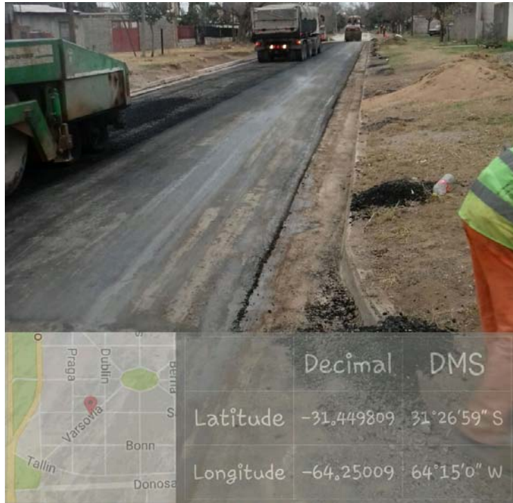
Imagen 6. Carpeta Asfáltica entre San Marino y Praga.
