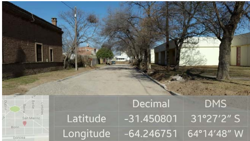
Imagen 2. Base granular entre Bonn y Tallin.
