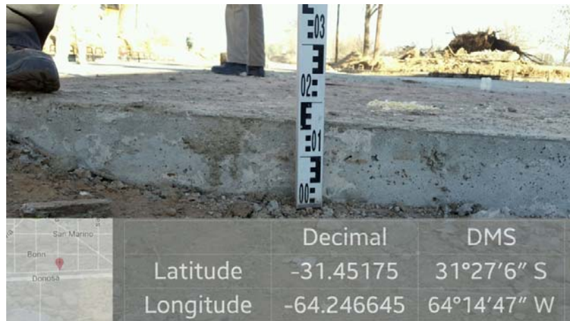
Imagen 6. Hormigón bocacalle Berna y Tallin.
