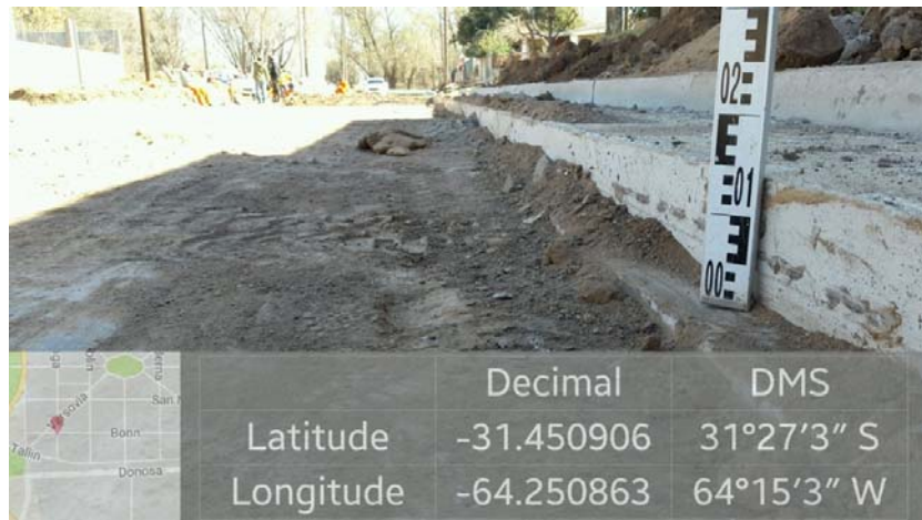
Imagen 14. Cordón cuneta Bonn entre Praga y Varsovia.
