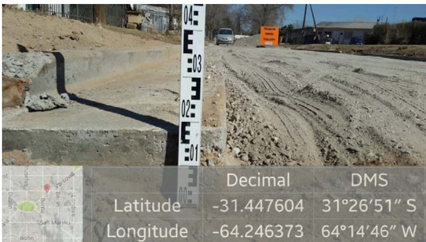
Imagen 9. Cordón cuneta Varsovia entre Berna y Ámsterdam.
