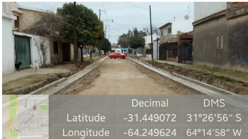
Imagen 2. Cordón cuneta entre Dublín y Praga.
