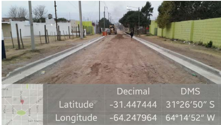
Imagen 2. Cordón cuneta entre Avdor. Petirosi y Berna.
