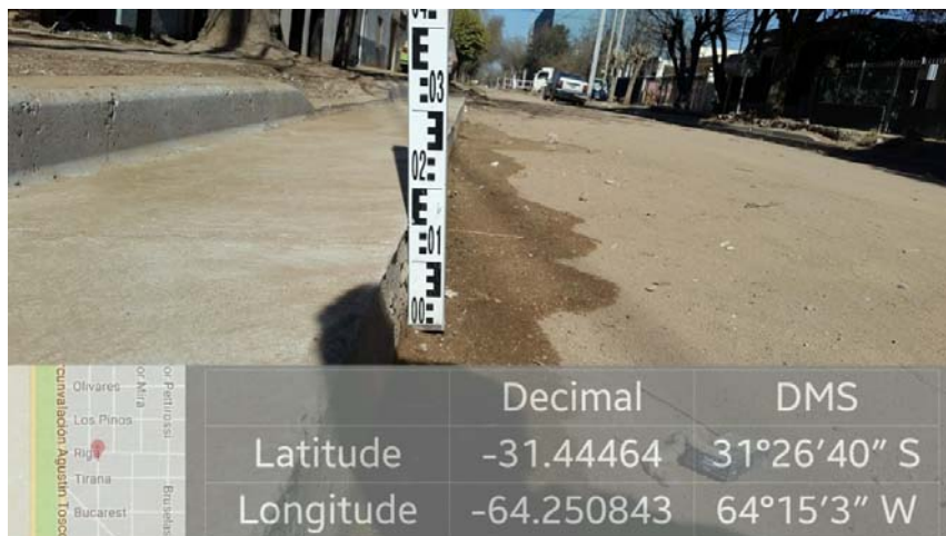
Imagen 11. Cordón cuneta Praga entre Riga y Tirana.
