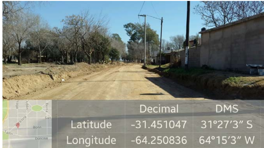
Imagen 1. Subbase entre Praga y Varsovia.
