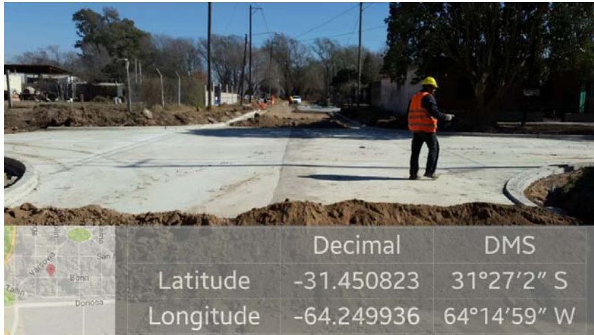
Imagen 8. Hormigón bocacalle con Praga.
