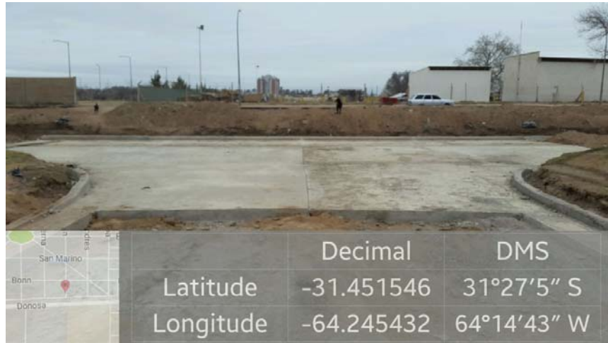
Imagen 3. Hormigón bocacalle con Tallin.
