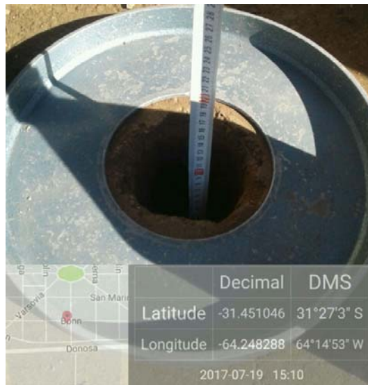
Imagen 16. Subbase Bonn 4664 entre Avdor. Petirosi y Berna.
