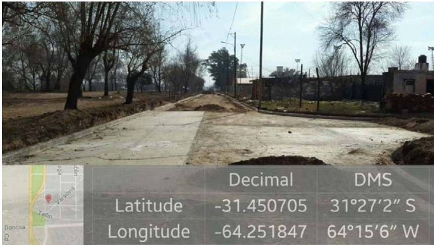
Imagen 9. Hormigón bocacalle con Luxemburgo.
