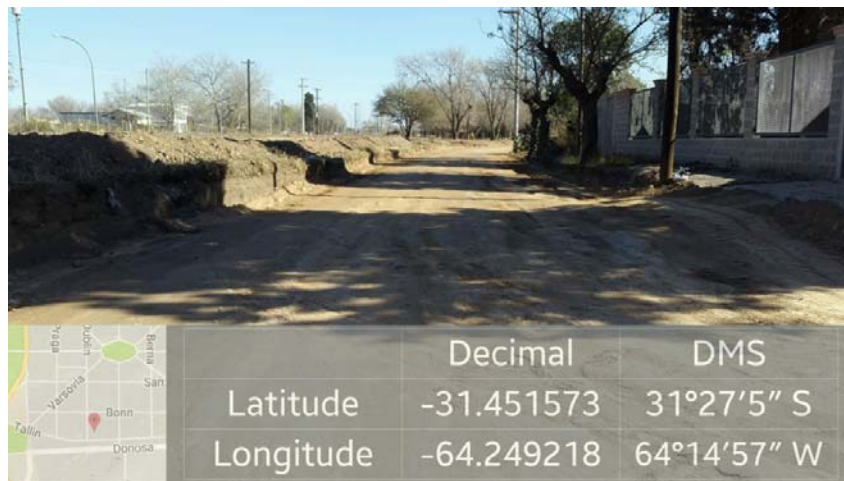
Imagen 2. Subbase entre Praga y Dublín.
