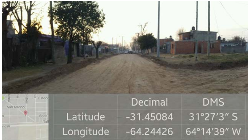
Imagen 5. Subbase entre Copenhagen y Arias.
