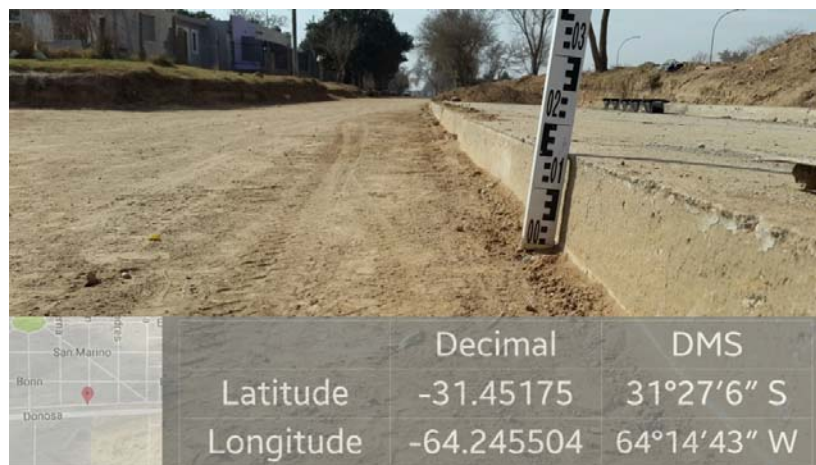
Imagen 2. Hormigón bocacalle Tallin y Berlín.
