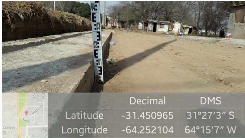
Imagen 13. Cordón cuneta Luxemburgo entre Bonn y Tallin.
