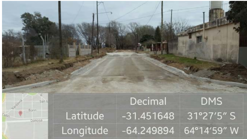
Imagen 14. Base granular entre Varsovia y Praga.
