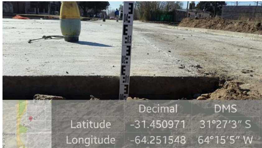
Imagen 5. Hormigón bocacalle Bonn y Varsovia.
