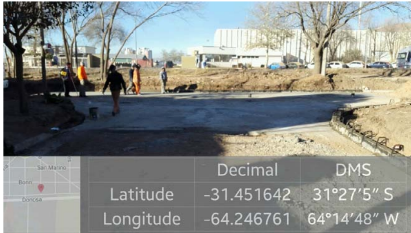
Imagen 4. Hormigón bocacalle con Berna.
