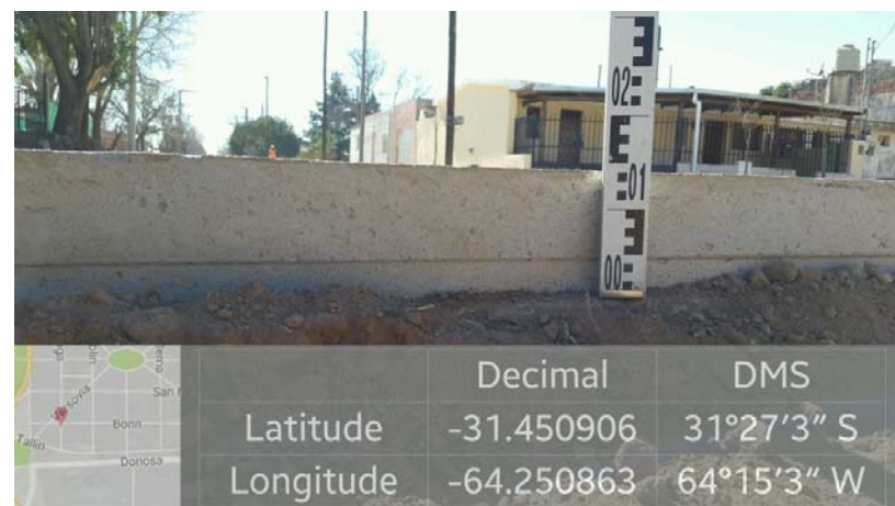
Imagen 3. Hormigón bocacalle Praga y Bonn.
