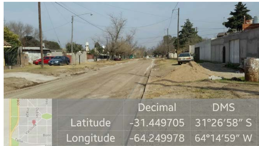
Imagen 4. Base granular entre San Marino y Praga.
