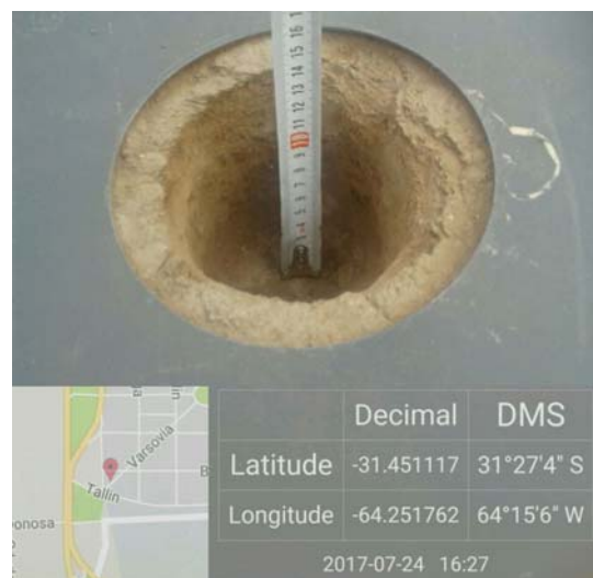
Imagen 24. Subbase Varsovia 4979 entre Bonn y Tallin.
