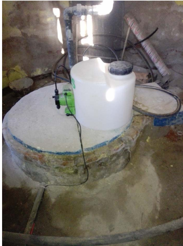
Ilustración 5: Pozo N°3 y cloración.
