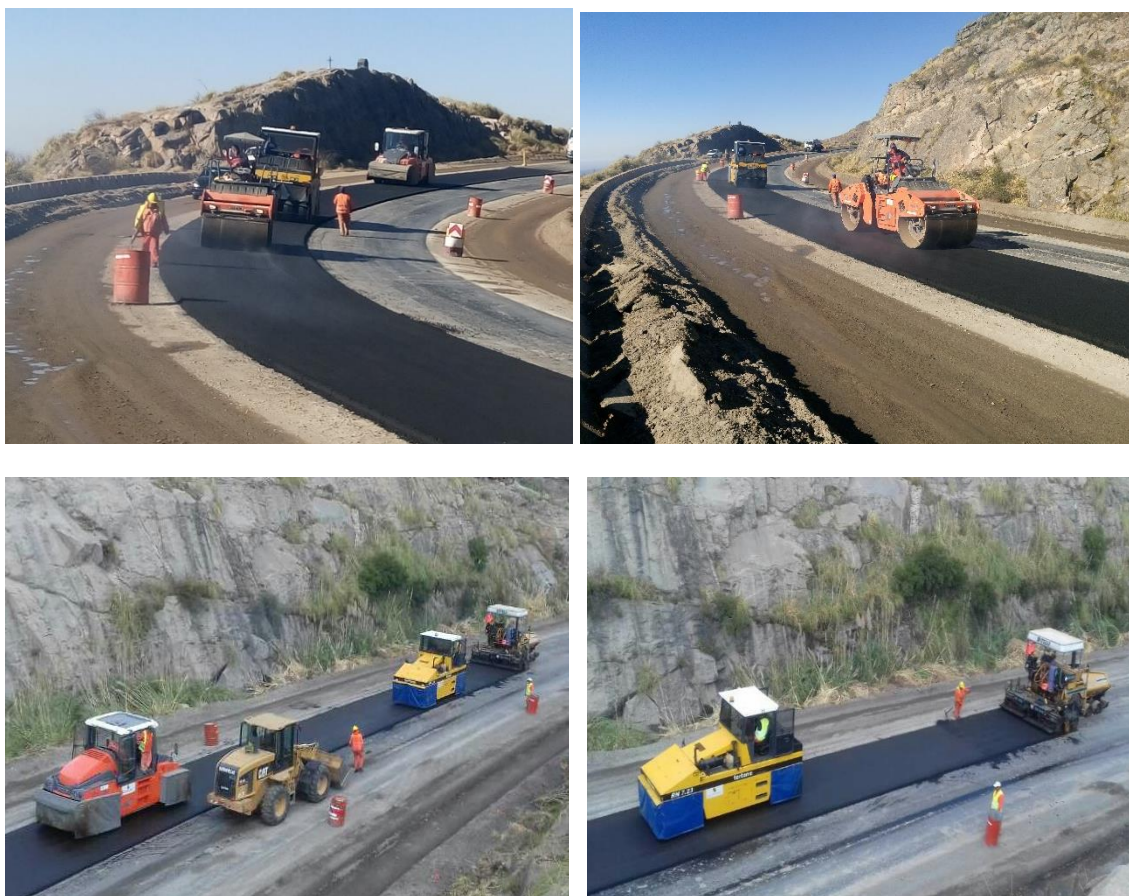
Figura 6.35: Compactación – a) y b) Rodillo liso y Rodillos Neumáticos, c) y d) Finalización de la compactación y de la cancha, ejecución de la rampa.
