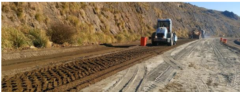
Figura 6.20: Primera Franja reciclada e ingreso del Primer Pata de Cabra
