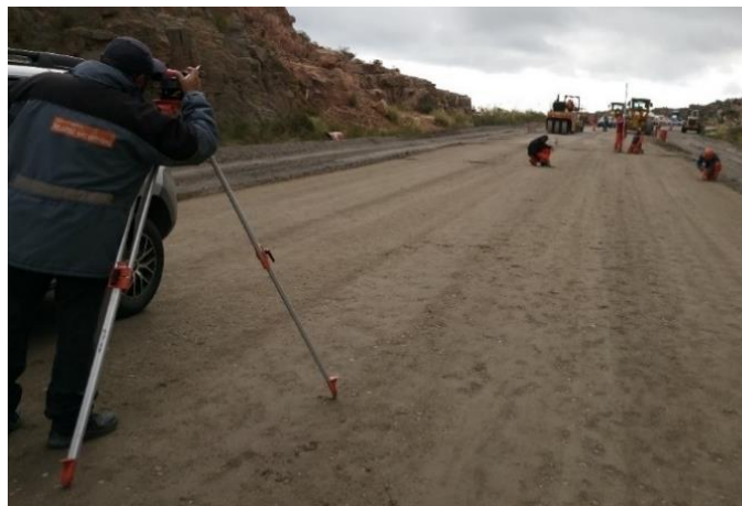
Figura 6.3: Nivelación, lectura de elevación del Terreno
