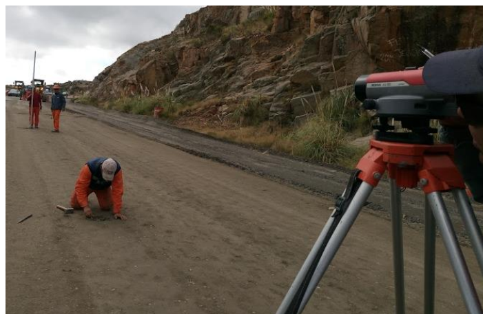
Figura 6.4: Estaquero dándole la elevación adecuada a la Estaca
