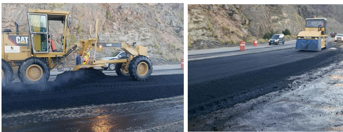
Figura 6.55: Ejecución de Acceso- a) Perfilado de Concreto asfáltico con motoniveladora, b) Compactación con rodillo Neumático
