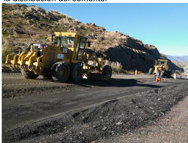
Figura 6.13: Extensión de la Carga con Motoniveladora
