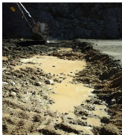
Figura 6.51: Ejecución del Dren- a) Excavación del suelo y delimitación de la zona, b) excavación del suelo
