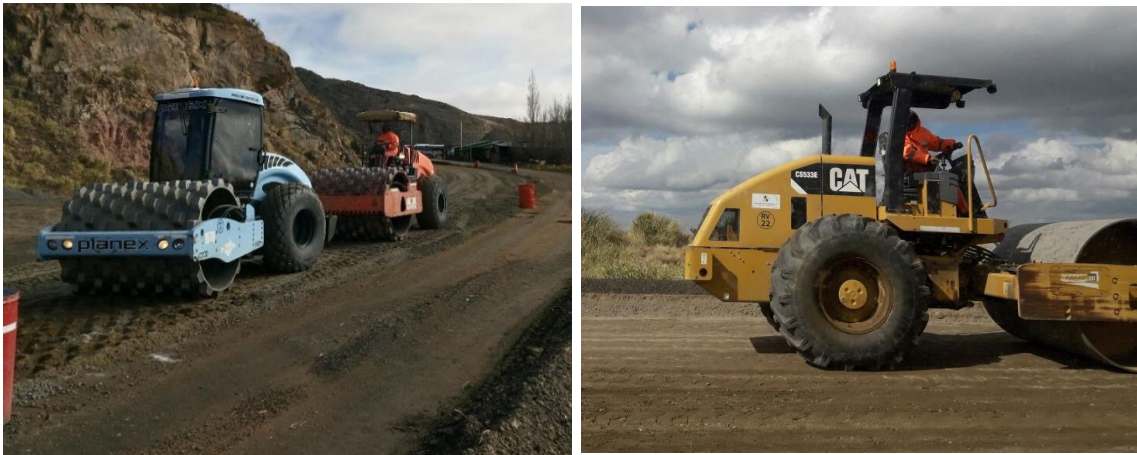
Figura 6.21: Compactación del Tramo- a) Compactación con Pata de Cabra, b) Compactación con Rodillo Liso
