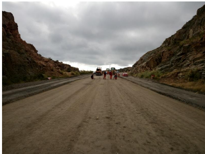
Figura 6.22: Nivelación de Base
