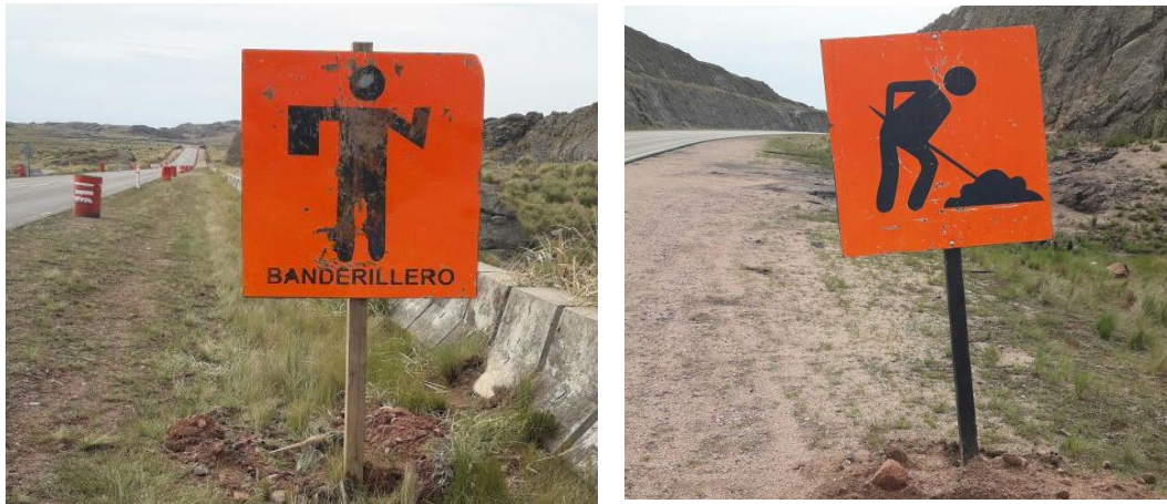
Figura 6.44: Señalización Transitoria- a) Presencia de Banderillero, b) Obreros Trabajando
