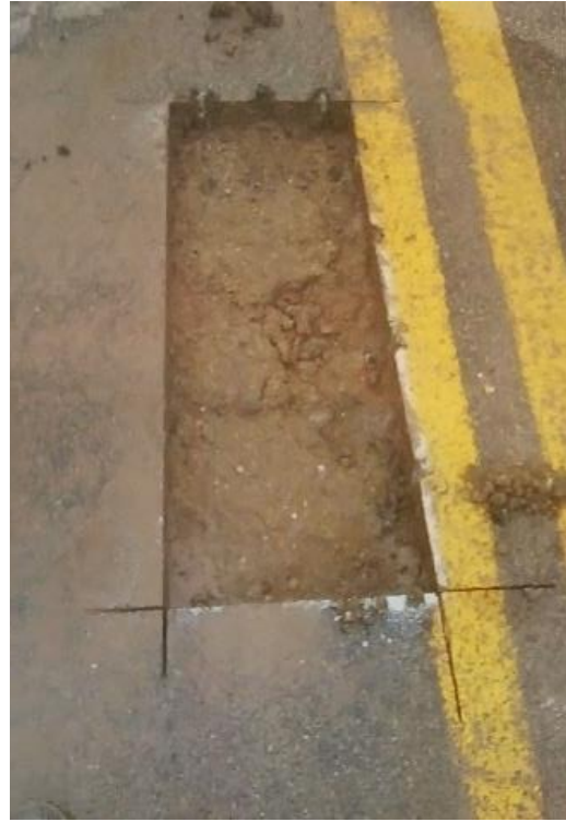
Figura 1.3: Calicata N°2 a) Presencia de Fisuras en el Eje de la Calzada; b) Extracción de Carpeta de Rodamiento
