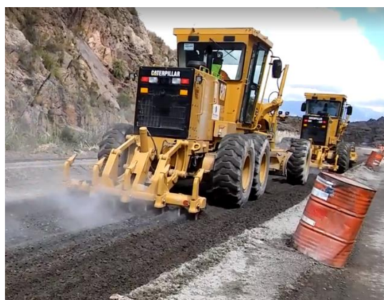
Figura 6.18: Movimiento de suelo con Motoniveladora- a) Primera Pasada Mezclado de Material, b) Escarificado de Suelo
