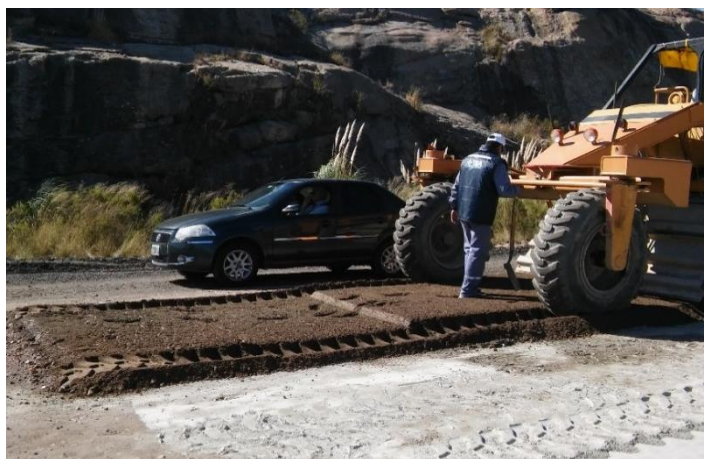
Figura 6.15: Reciclado con Reclamadora, inicio de cancha y corrección de espesor
