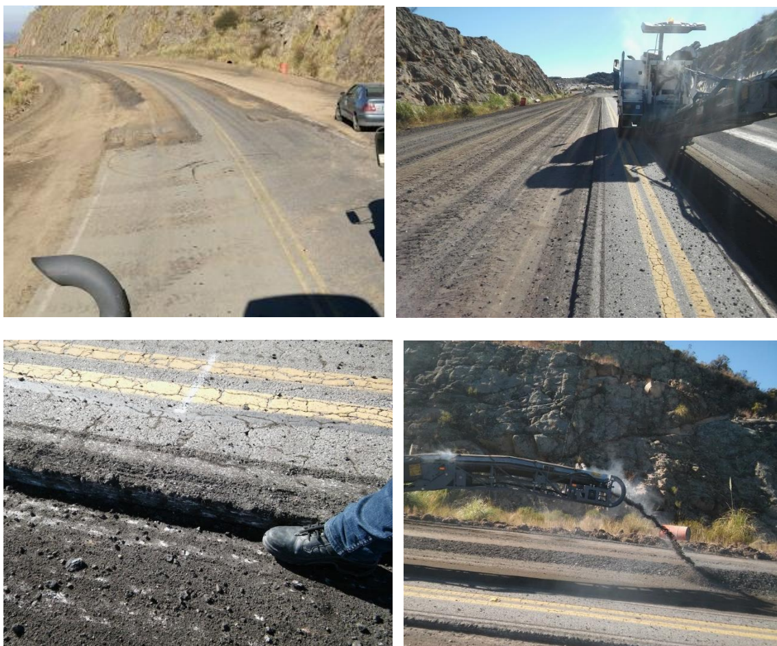
Figura 6.6: Proceso de Fresado de Carpeta Existente - a) Franjas de Fresado, b) Fresadora, c) Espesor de Carpeta de Rodamiento, d) descarga de la Fresadora
