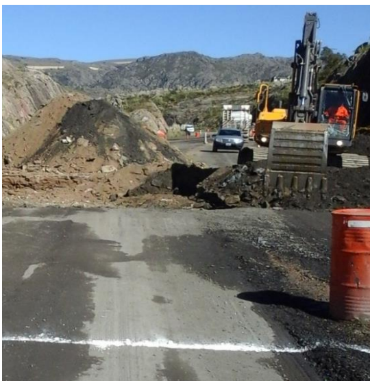
Figura 6.51: Ejecución del Dren- a) Excavación del suelo y delimitación de la zona, b) excavación del suelo
