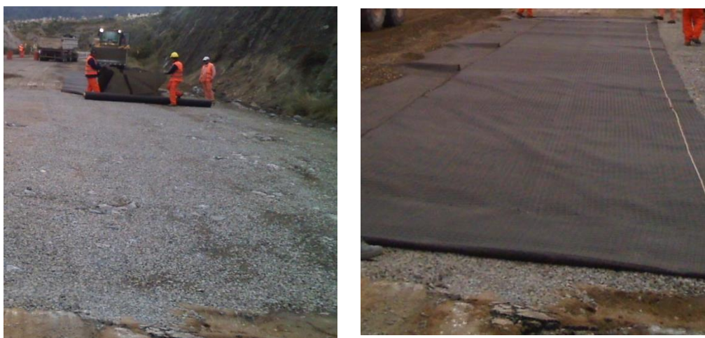
Figura 6.52: Colocación de Materiales- a) Material granular 6-25, b) extensión geotextil
