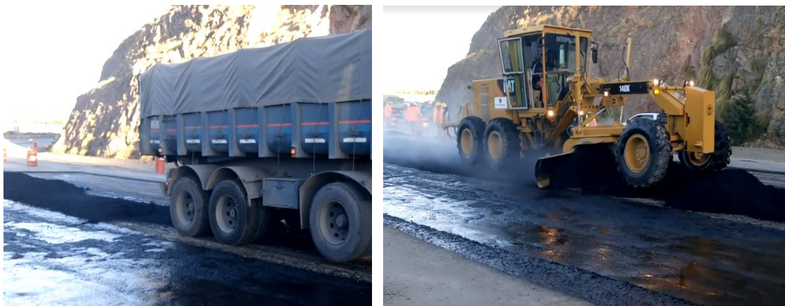
Figura 6.54: Ejecución de Acceso- a) Colocación directa del asfalto sobre riego de imprimación, b) extensión de Mezcla Asfáltica con Motoniveladora
