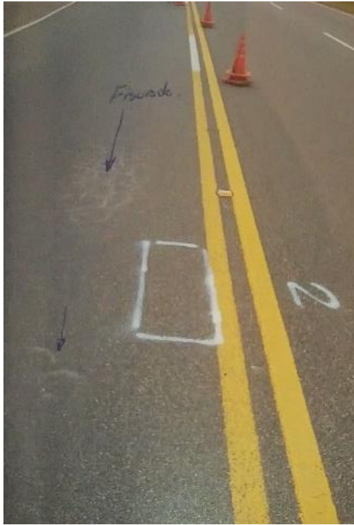
Figura 1.3: Calicata N°2 a) Presencia de Fisuras en el Eje de la Calzada; b) Extracción de Carpeta de Rodamiento
