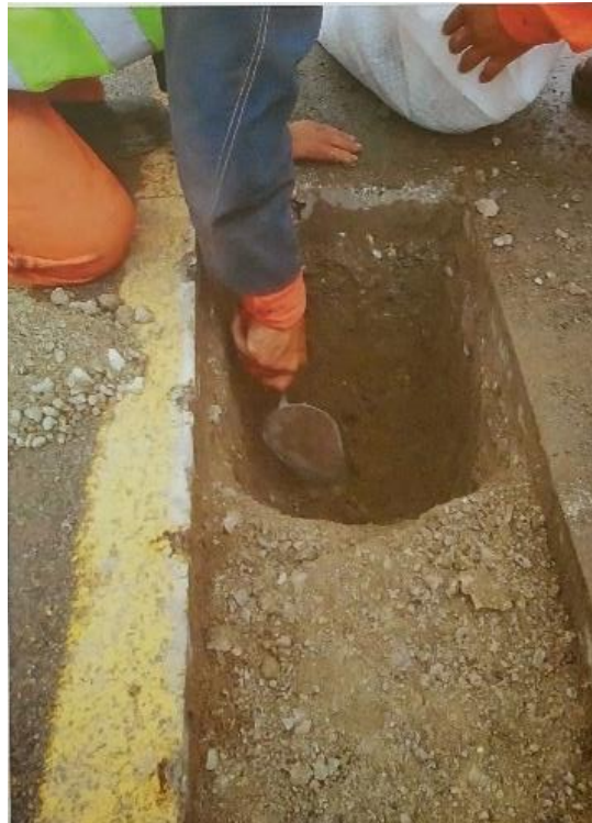
Figura 1.4: a) Concreto Asfáltico de 6 cm de espesor; b) extracción de material de Muestra para laboratorio
