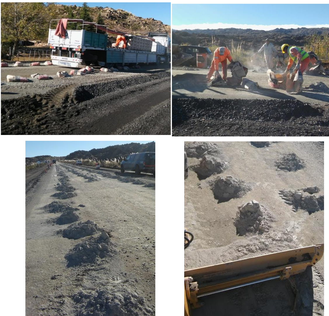
Figura 6.14: Distribución de Cemento- a) Descarga de la bolsas de Cemento, b) Extracción de las bolsas, c) Cemento Distribuido, d) Esparcimiento de Cemento con Motoniveladora
