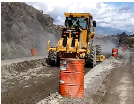
Figura 6.18: Movimiento de suelo con Motoniveladora- a) Primera Pasada Mezclado de Material, b) Escarificado de Suelo
