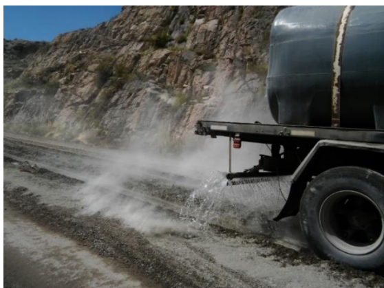
Figura 6.17: Reciclado Con Motoniveladora- a) Humedecimiento del suelo, b) Primera Pasada Mezclado de Material
