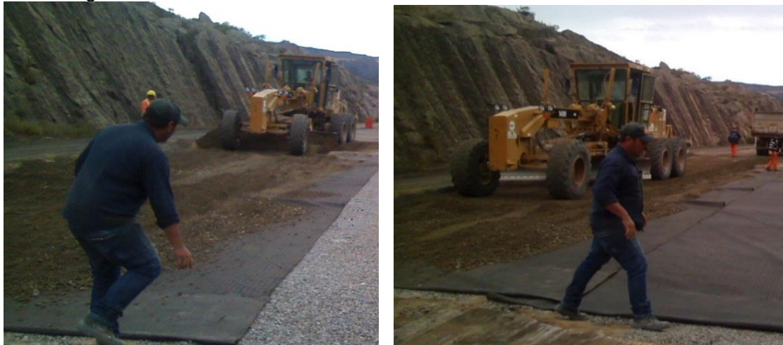
Figura 6.53: Ejecución de Base Granular a) y b) Extensión de la base con motoniveladora
