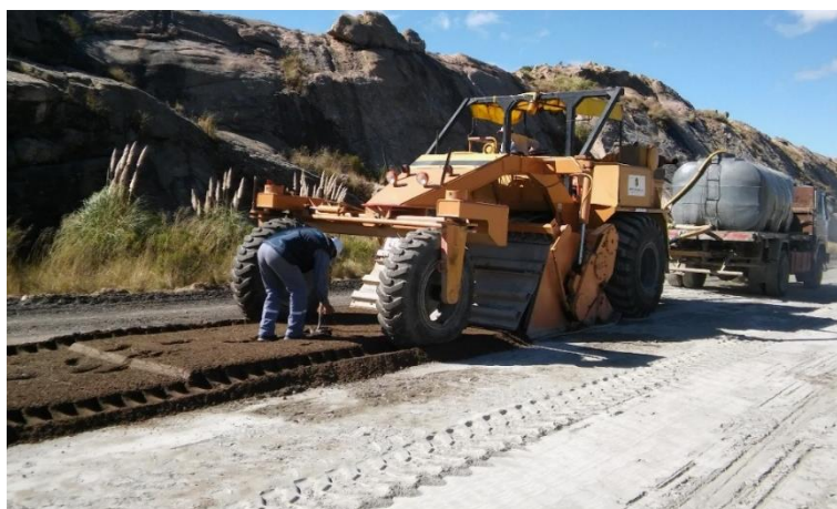
Figura 6.16: Reciclado de base, Operario realizando Ensayo de Compresión Manual
