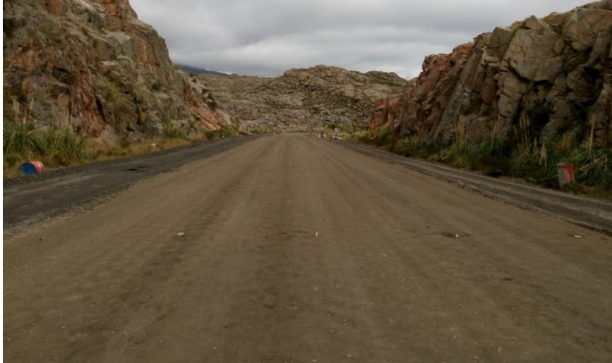
Figura 6.2: Distribución de las estacas cada 12,5 mts en los bordes, eje e intermedias
