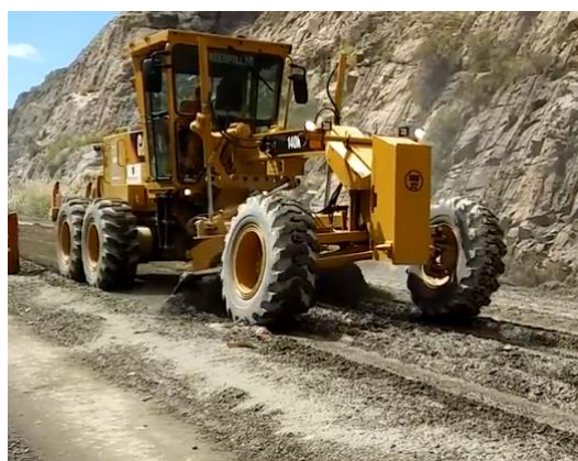
Figura 6.17: Reciclado Con Motoniveladora- a) Humedecimiento del suelo, b) Primera Pasada Mezclado de Material
