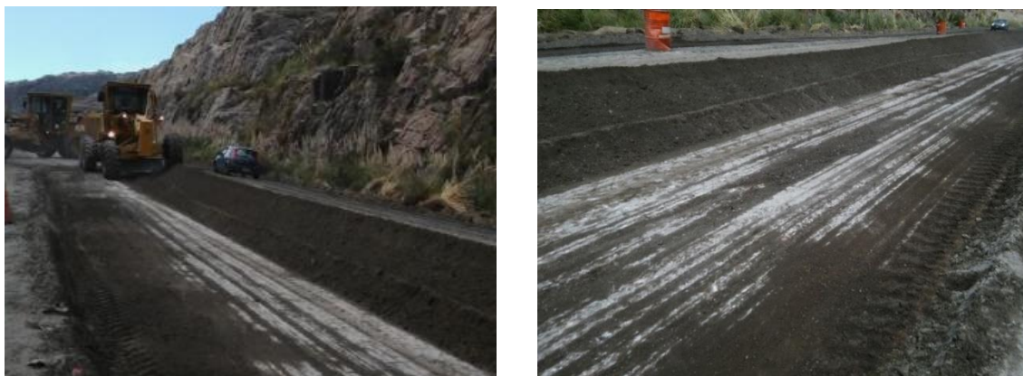
Figura 6.19: Movimiento de Suelo con Motoniveladora - a) y b) Movimiento de borde a eje del suelo.
