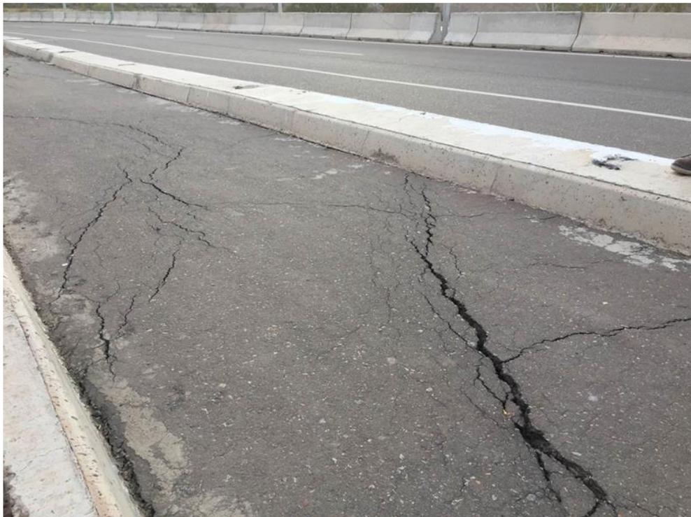
**Figura 2.4:** Fisuración con un patrón frecuente en dirección SW-NE.
