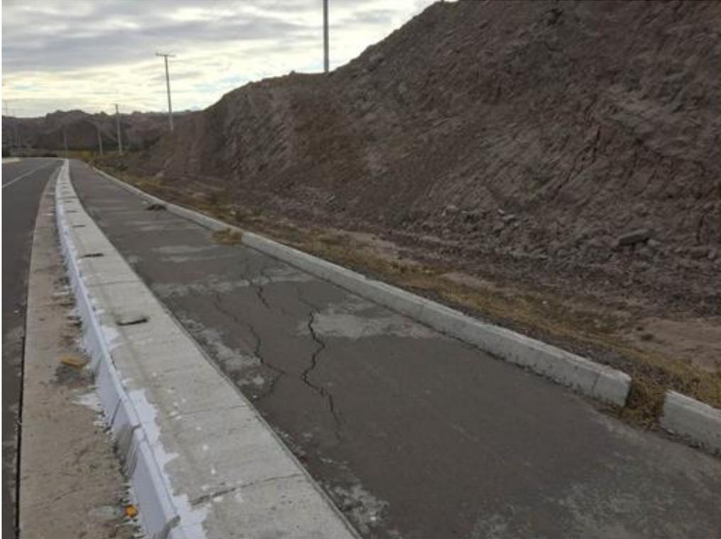
**Figura 2.5:** Vista de deterioros en margen izquierda. Al fondo contratalud con presencia alternante de materiales.
