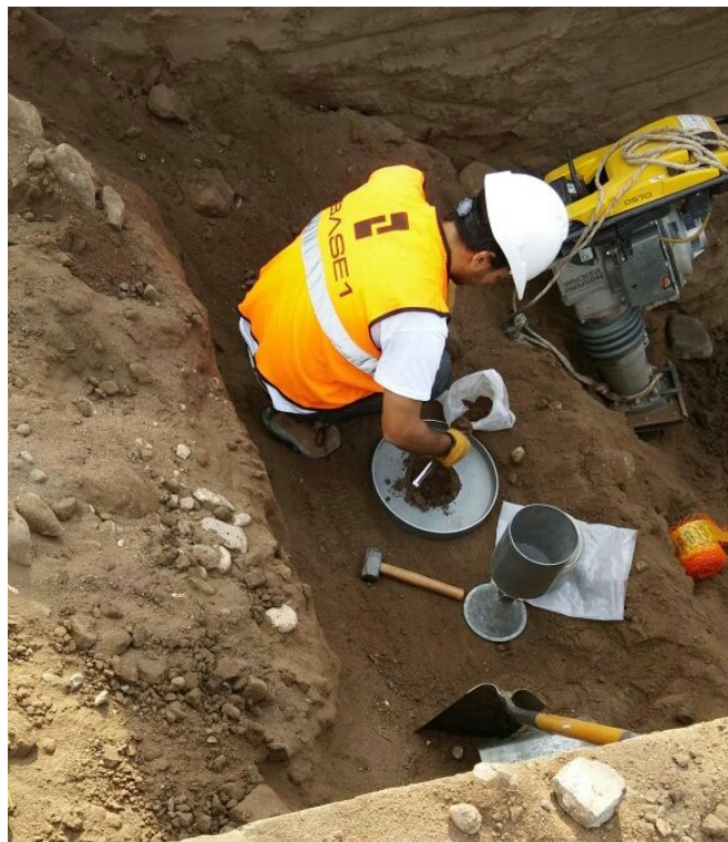
Imagen N° 7.8: Ensayos de compactación.
