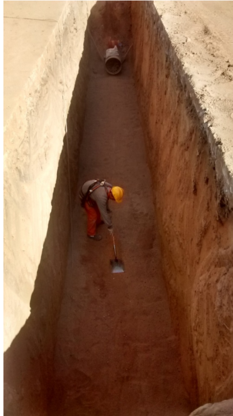
Imagen N° 7.14: Emparejado de la cama de arena.
