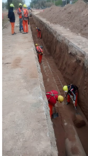
Imagen N° 7.31: Etapa de compactación.
