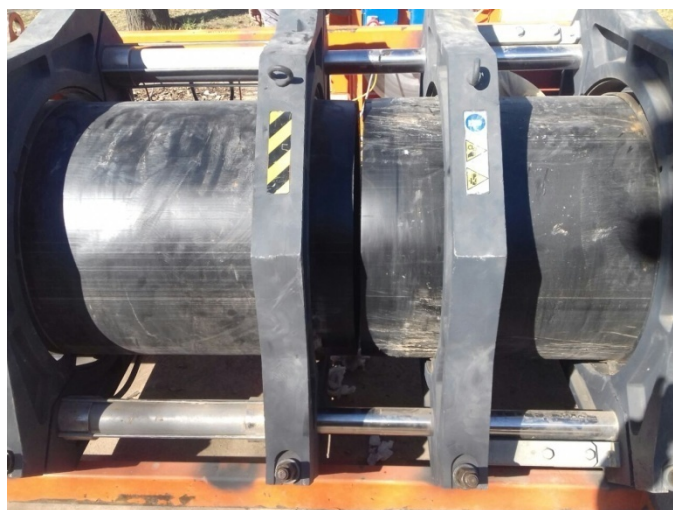
Foto N° 7.57: Soldadura a tope por termofusión.
