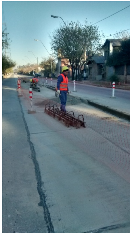
Imagen N° 7.46: Reparación del cordón central.
