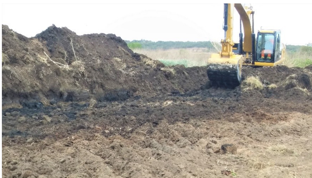
Imagen N° 4.40: Remoción de barros área digestores
