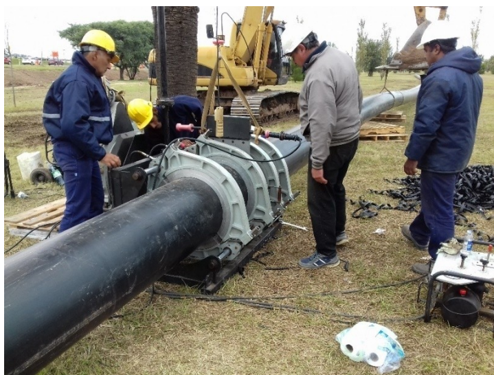
Foto N° 7.56: Túnel Teledirigido. Soldadura a tope por termofusión.
