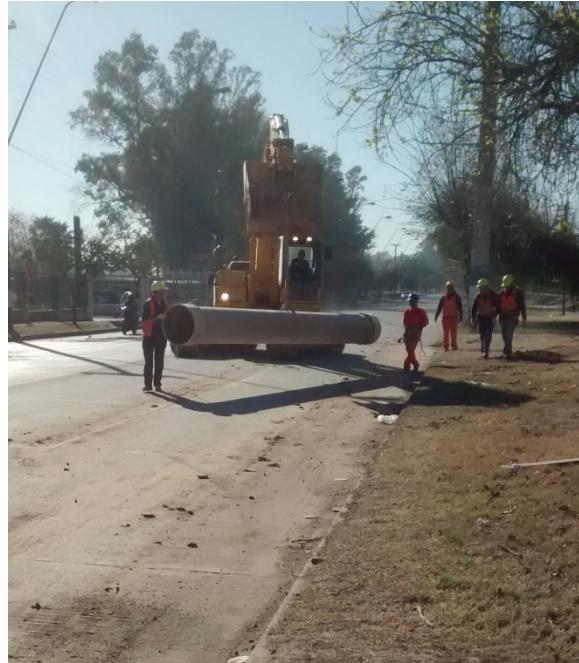
Imagen N° 7.11: Izado de tubería
