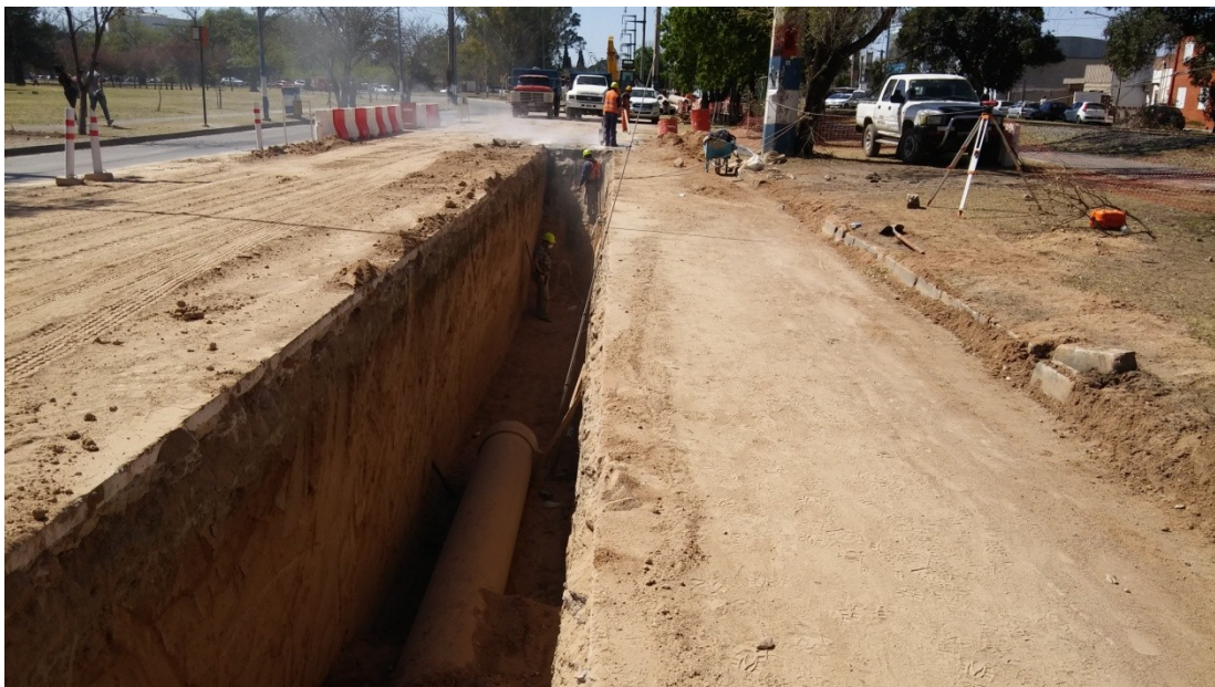
Imagen N° 4.28: Realización cama de arena, para asiento de cañería.
