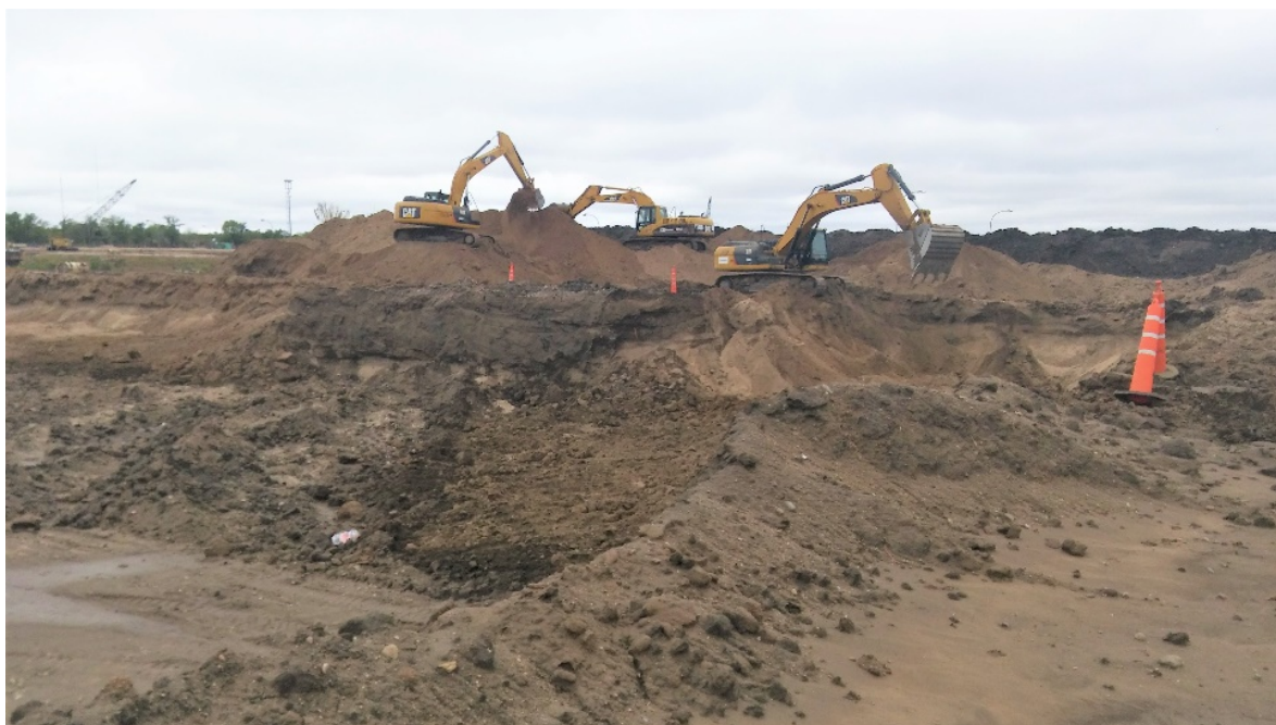
Imagen N° 4.41: Excavación de fundaciones en espesadores de barros
