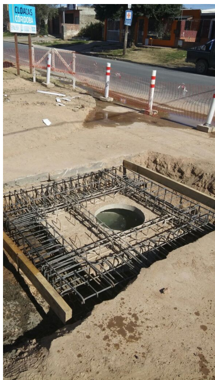
Imagen N° 7.43: Armadura para tapa de BR.
