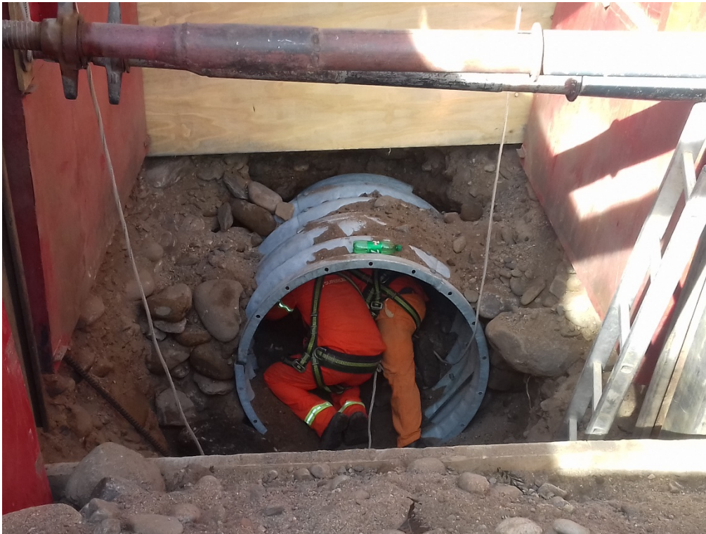
Imagen N° 7.49: Colocación en obra de tunnel liner.
