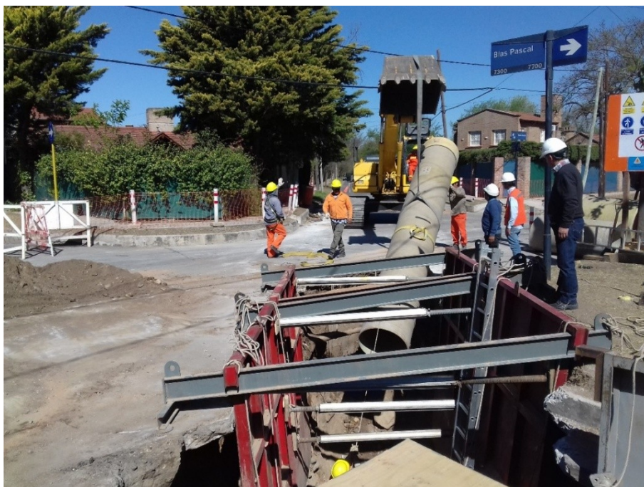
Imagen N° 4.7: Frente de obra progresiva 1629m. Colocación de cañería sobre calle Garzón.
