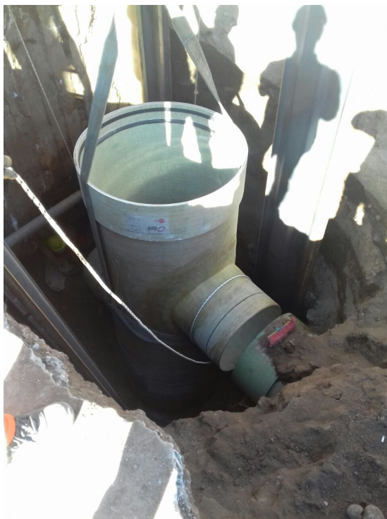
Imagen N° 7.41: Izado de BR para colocación.
