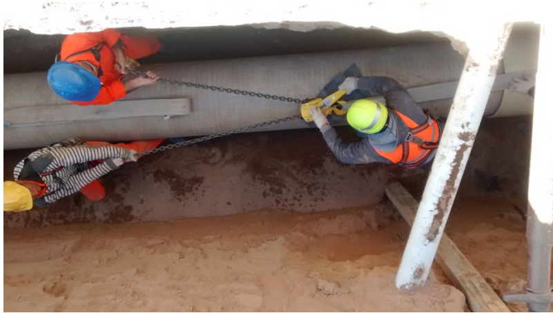
Imagen N° 7.25: Montaje del tubo.
