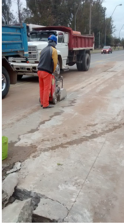
Imagen N° 7.1: Corte del pavimento con sierra a disco.
