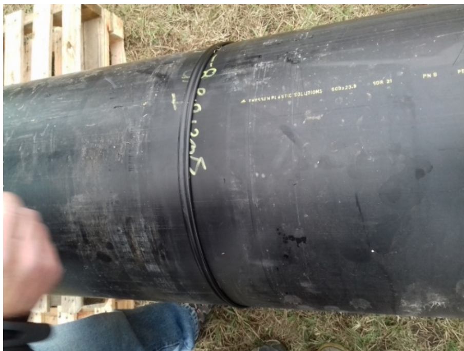
Foto N° 7.58: Túnel Teledirigido. Unión soldada a tope por termofusión.
