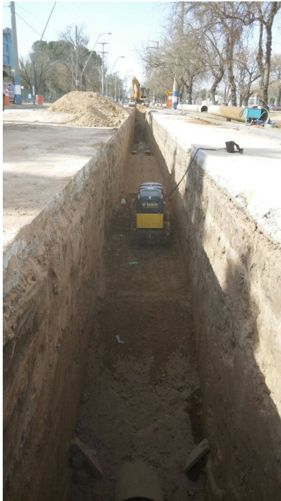
Imagen Nº 7.33: Compactación del relleno.
