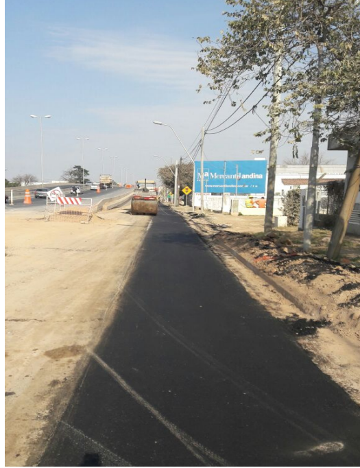
Imagen N° 4.23: Reposición de paquete estructural y terminación de carpeta asfáltica
