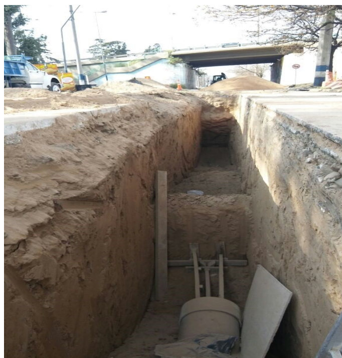
Imagen N° 4.27: Colocación de caño 600 mm próximo Vélez Sarsfield
