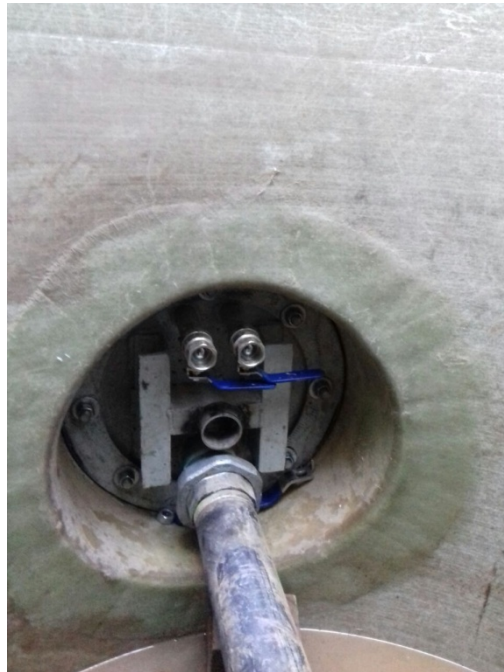
Imagen N° 7.38: Colocación del tapón para prueba hidráulica.
