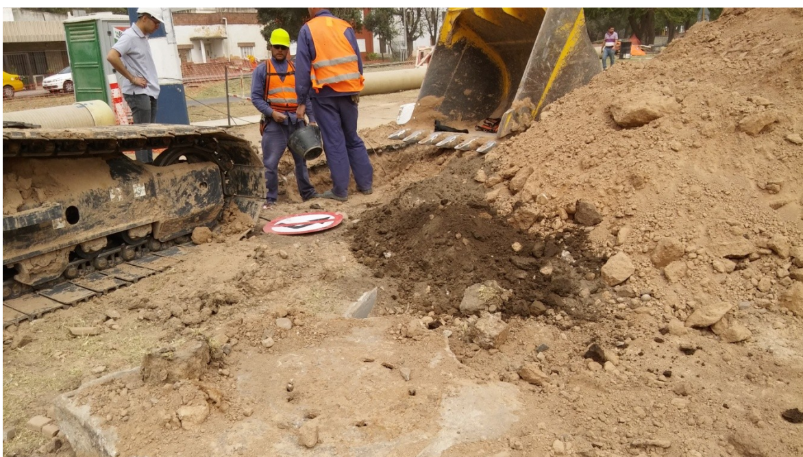
Imagen N° 4.29: Inspección de cañería existente por el alumno.
