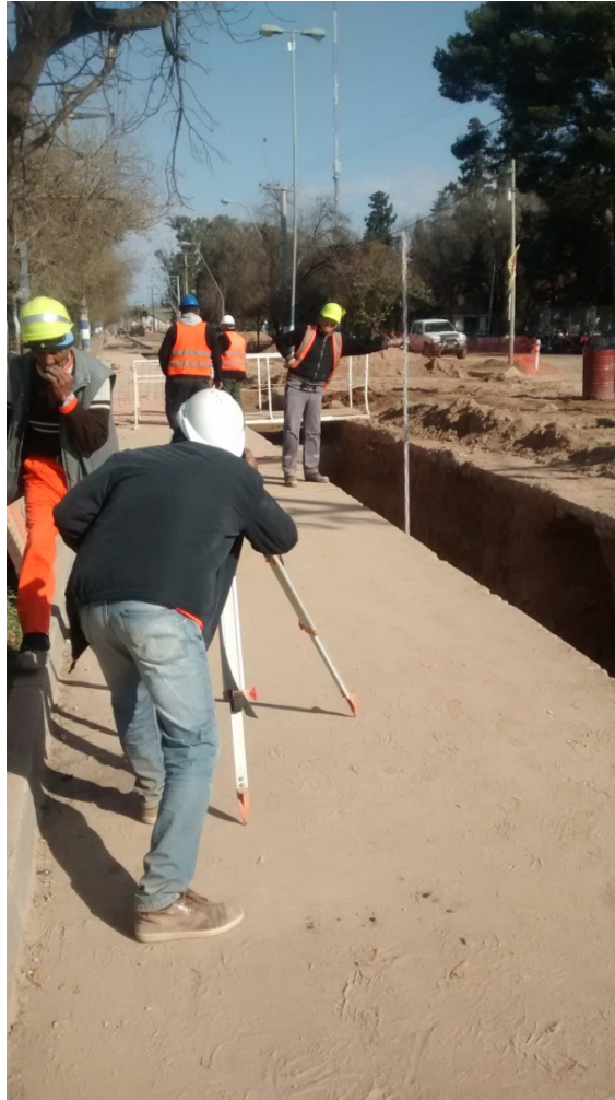
Imagen N° 7.16: Nivelación del caño.
