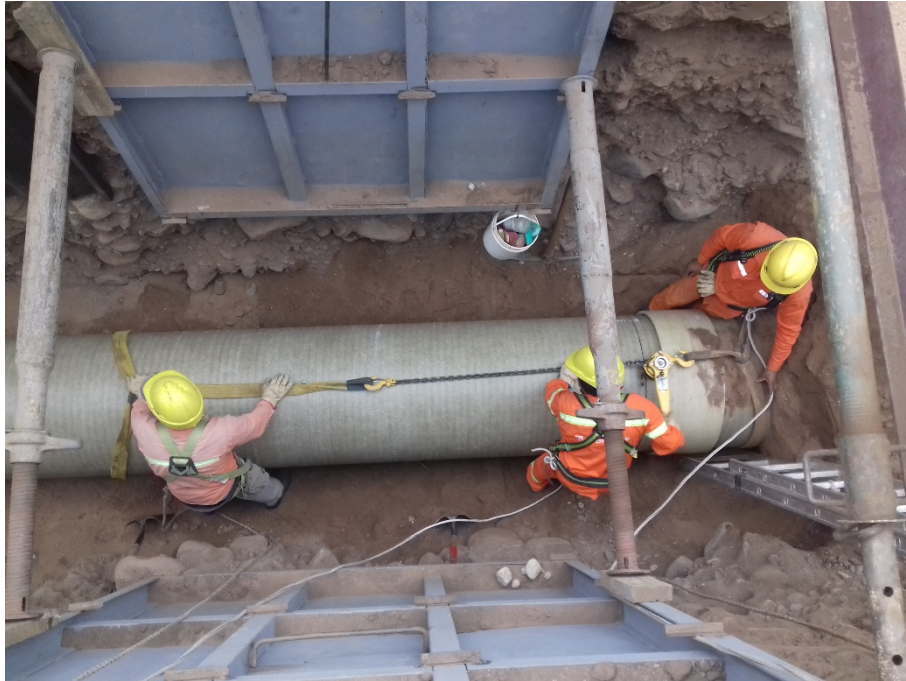
Imagen Nº 4.11: Tareas de enchufe de tubos PRFV.
