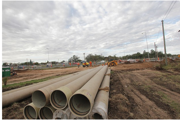
Imagen N° 7.13: Acopio de caños en obra.
