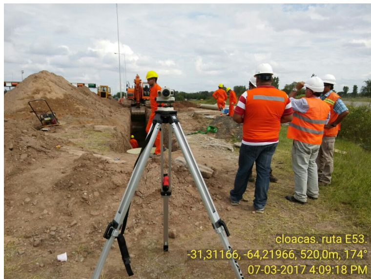
Imagen N° 4.16: Inicio actividades colector norte.
