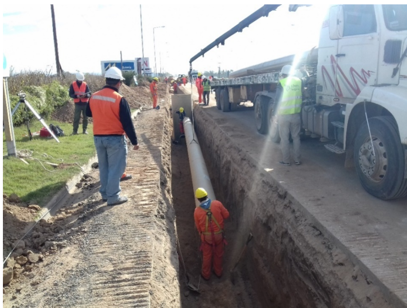
Imagen N° 4.18: Izaje de tuberías DN 450. Ubicación Ruta E53.
