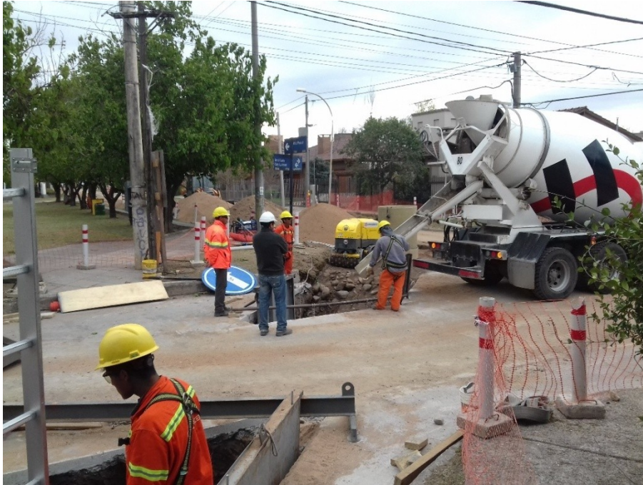
Imagen N° 4.9: Llenado de RDC (Relleno Densidad Controlada) en perímetro de caño DN 800 por debajo de canal pluvial sobre Garzón.
