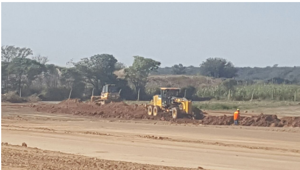
Imagen N° 4.37: Sedimentadores primarios Se avanza con capas de 20 cm por fajas de 25 m x150 m con un suelo seleccionado de cantera.
