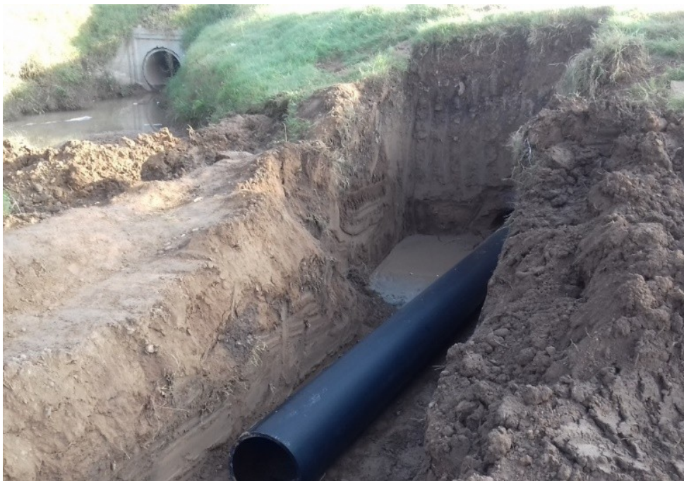
Imagen N° 7.52: Túnel Teledirigido. Tarea terminada, colocación de cañería en el túnel.
