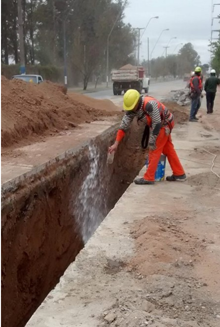
Imagen N° 7.30: Agregado de agua para compactación
