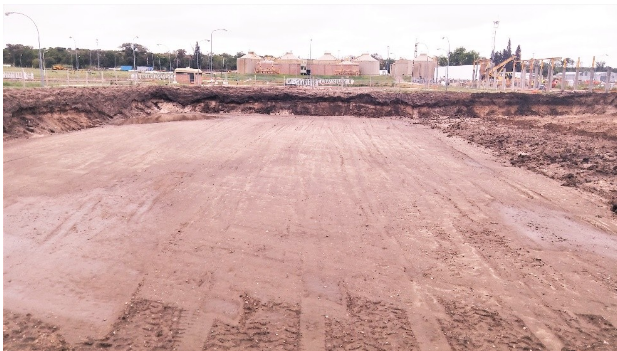
Imagen N° 4.42: Vista de la pre-excavación de fundaciones de espesadores de barros
