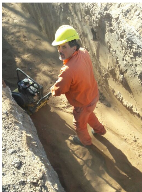
Imagen N° 7.6: Compactación del fondo de excavación.
