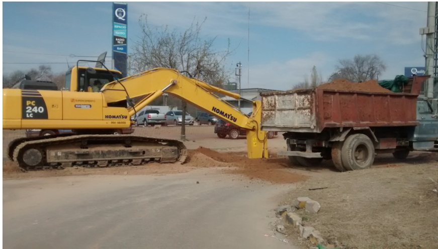
Imagen N° 7.4: Extracción del material de la zanja.
