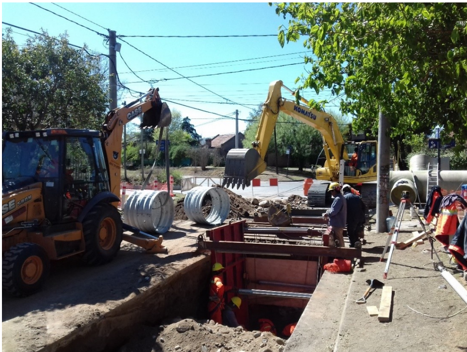
Imagen N° 4.4: Frente de obra ejecutando Tunnel Liner en poste media tensión. Ubicación Pascal esquina Garzón.
