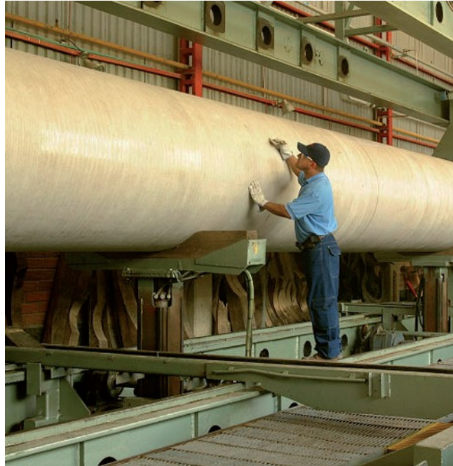
Foto N° 8.1: Inspección visual de cañería.
