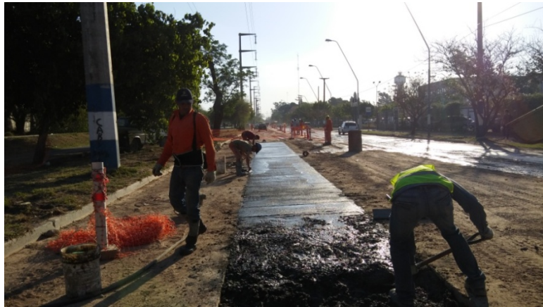
Imagen N° 7.54: Colocación del hormigón y emparejado.
