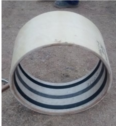
Imagen N° 7.21: Empaques de sello instalados.
