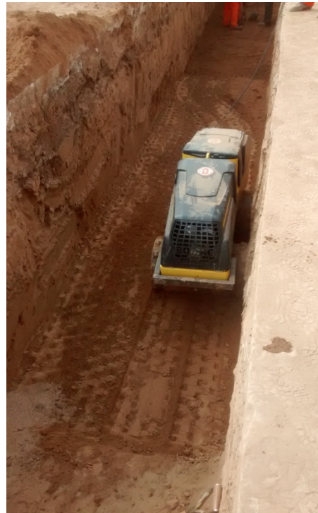
Imagen Nº 7.34: Compactación del relleno con rodillo.
