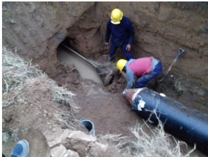
Imagen Nº 7.51: Túnel Teledirigido ejecutado. Tareas de alineación y preparación para introducción de conducto PEAD.
