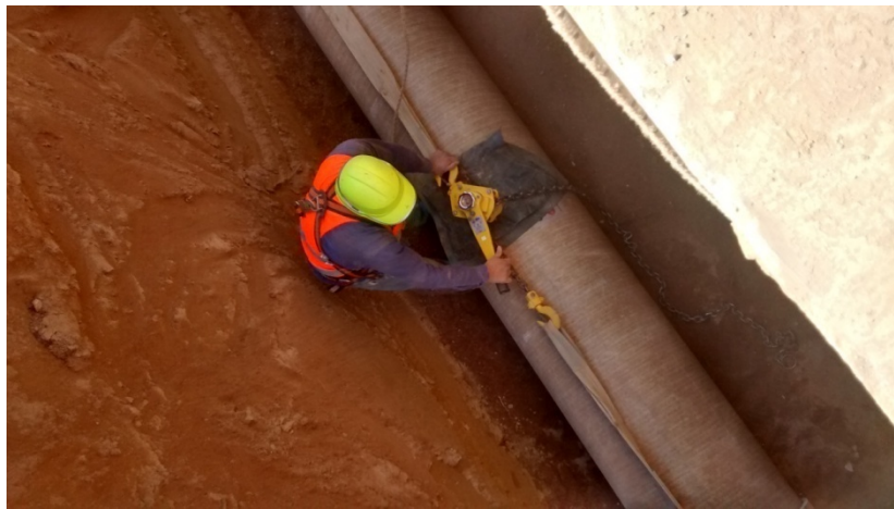
Imagen N° 7.26: Montaje del tubo.
