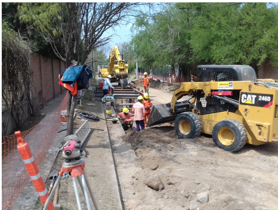
Imagen Nº 4.6: Frente de obra. Tareas denivelacion. Ubicación Gay Lussac.
