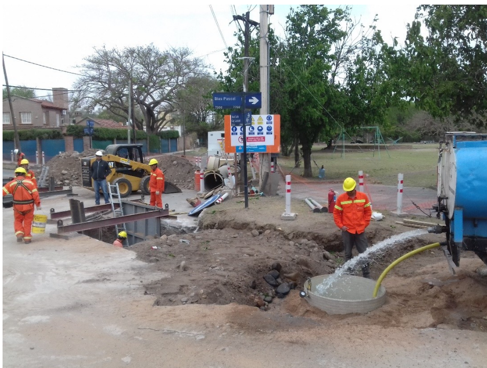
Imagen N° 4.8: Llenado de Boca de Registro N°9 para prueba hidráulica entre BR9 y BR8.
