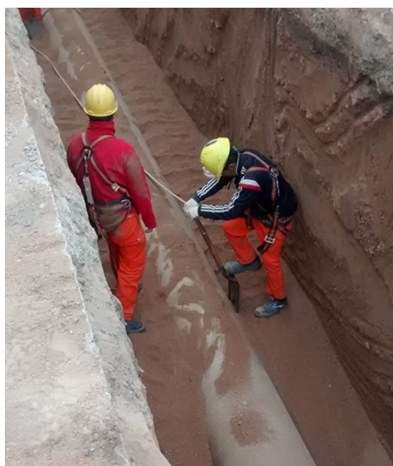
Imagen N° 7.29: Relleno del riñón del tubo
