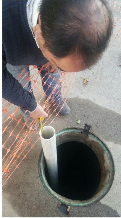
Imagen N° 7.40: Medición de la prueba hidráulica.
