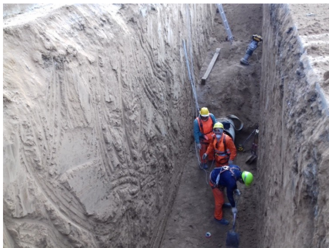
Imagen N° 7.5: Etapa de nivelación y compactación del fondo de excavación.
