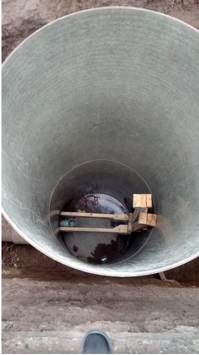
Imagen N° 7.39: Anclaje del tapón.
