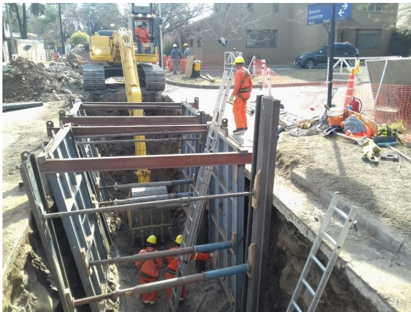
Imagen N° 4.10: Trabajo con entibados continuos apuntalados debidos a tipología de suelo, suelo desmoronable.
