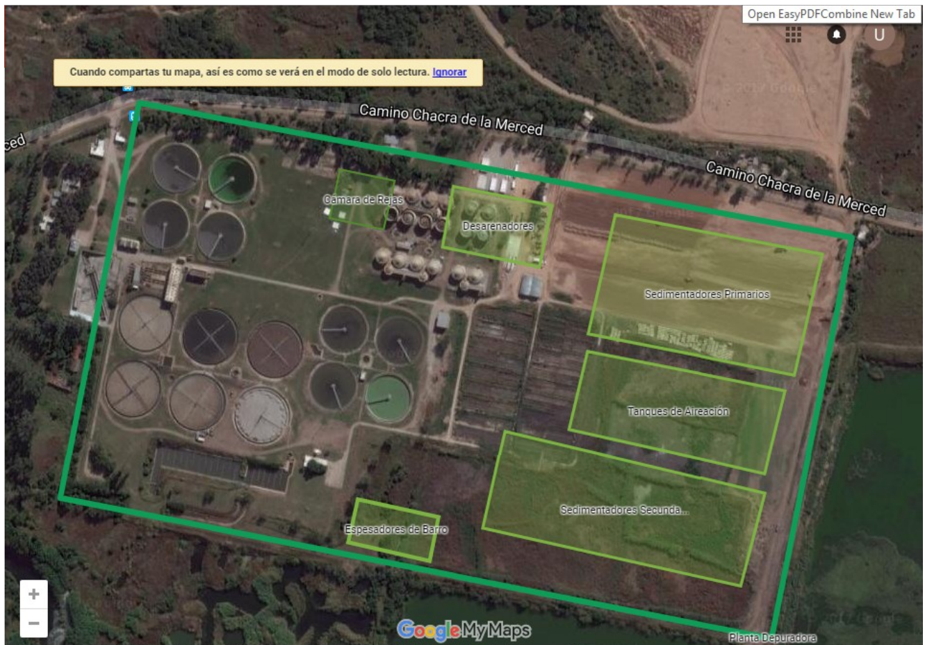
Imagen N° 4.36: Planta depuradora, ubicación de las futuras instalaciones.
