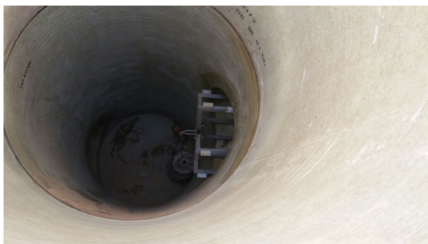
Imagen N° 7.36: Mandril a punto de ser pasado por tubería.
