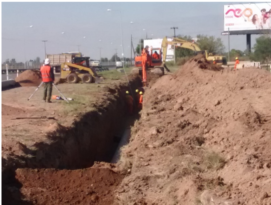
Imagen N° 4.21: Frente de excavación, progresiva +970.00 m
