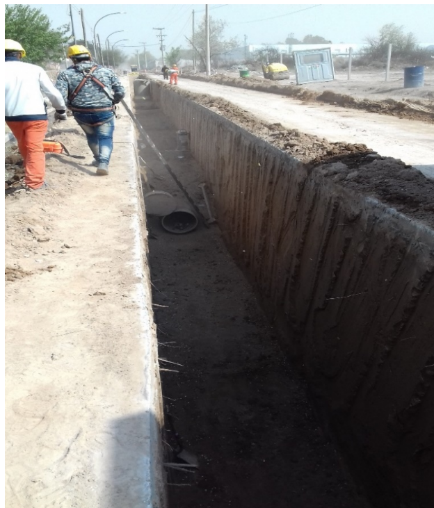
Imagen N° 4.32: Instalación de Cañerías progresiva 0+840,00. Calle Defensa Villa El Libertador
