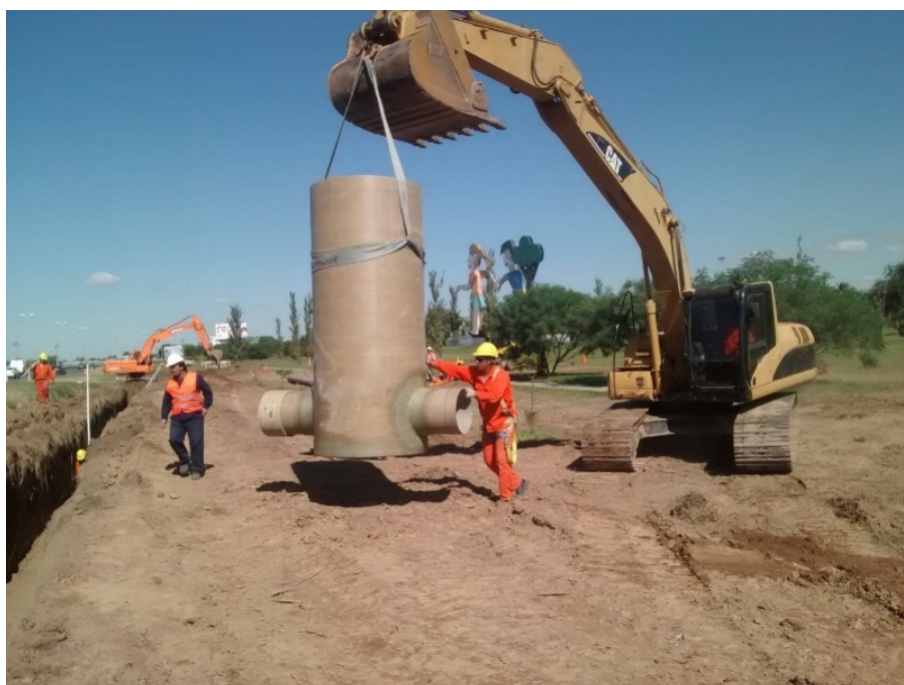
Imagen N° 4.22: Izaje boca de registro N°6.
