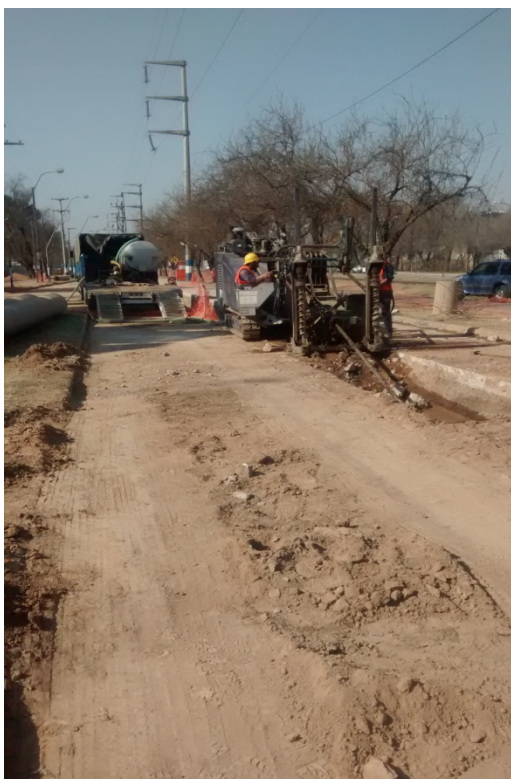
Imagen N° 7.53: Tunelera en funcionamiento
