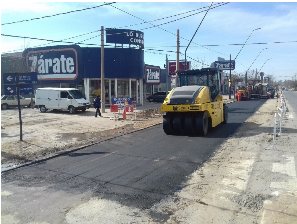
Imagen Nº 4.12: Reposición de carpeta asfáltica. Ubicación, Recta Martinolli entre Barany y Sabín.
