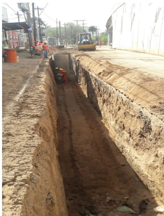
Imagen N° 4.20: Etapa de Compactación
