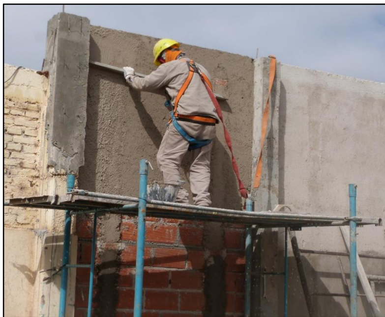
Figura 4.4: Obrero sobre andamio realizando tareas de revoque.
