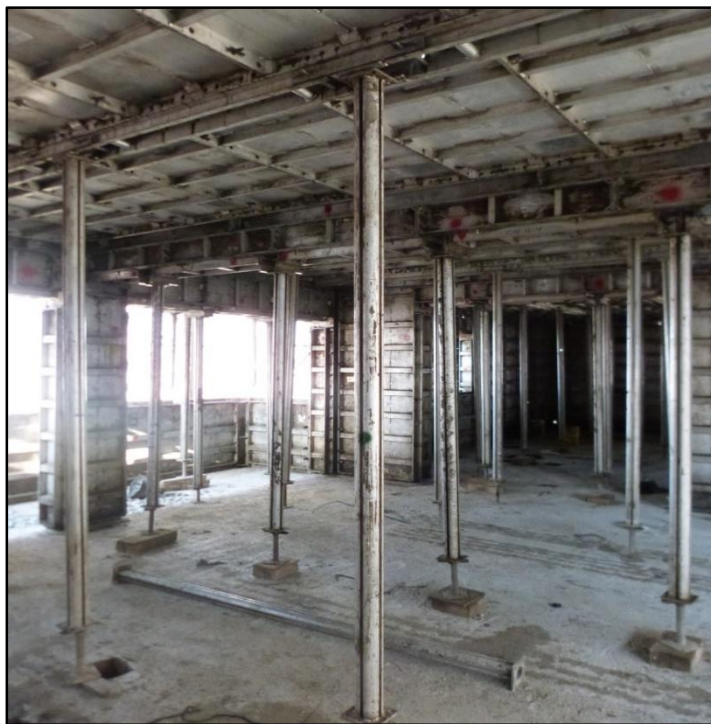
Figura 4.14: Puntales para estabilidad de losas y vigas.
