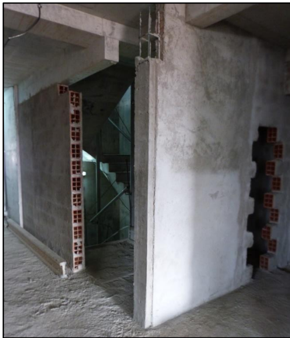
Figura 4.6: Revoque sobre núcleo de escaleras.
