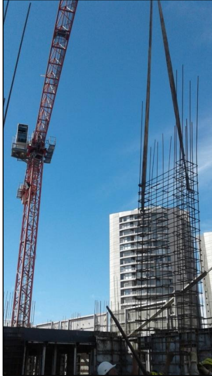
Figura 4.12: Tareas de izaje de columnas.
