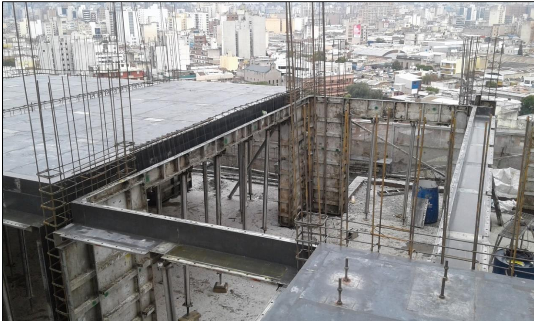
Figura 4.11: Encofrado de tabiques, columnas, vigas y losas.
