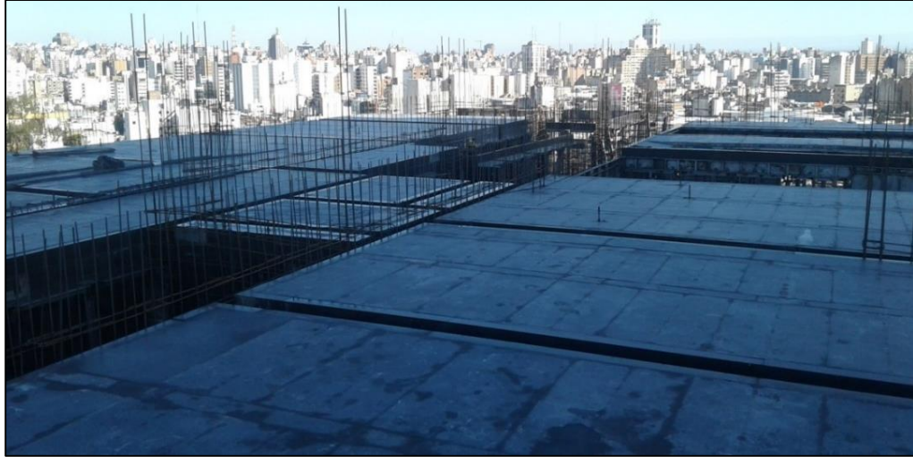
Figura 4.10: Encofrado de vigas y losas.
