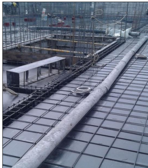
Figura 4.23: Armado de Manguera.
