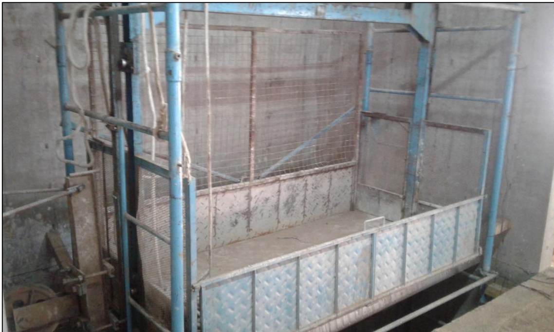
Figura 4.2: Equipo para izado de materiales.
