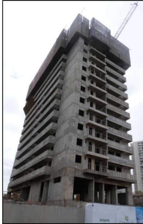
Figura 3.5: Fotografía del Edificio de la fachada Sureste al momento de inicio de la Práctica Supervisada del alumno.
