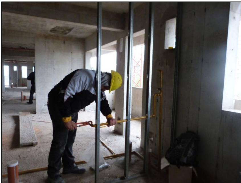
Figura 4.31: Obrero realizando instalaciones de gas.
