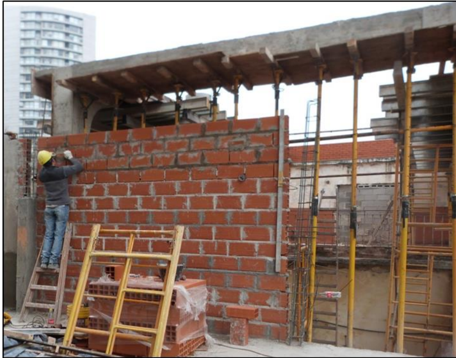
Figura 4.3: Tareas de mampostería en muro medianero.
