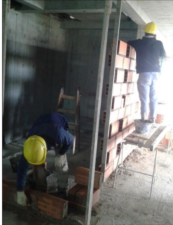
Figura 4.1: Tareas de mampostería en núcleo de escaleras.
