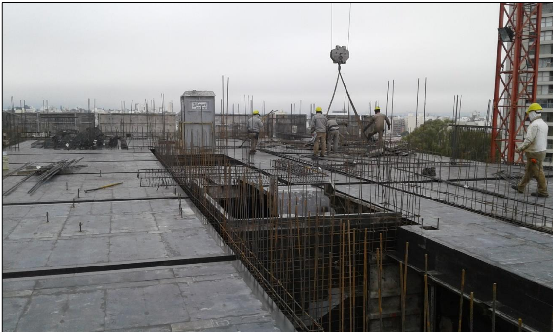
Figura 4.17: Tareas de izaje y colocación de vigas.
