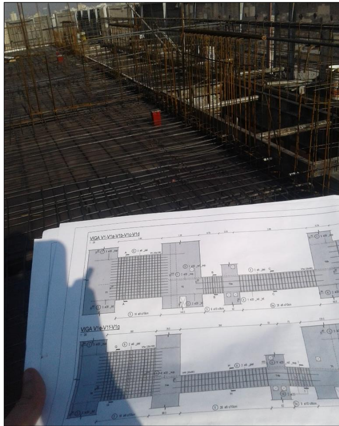
Figura 4.18: Tareas de verificación de armadura.
