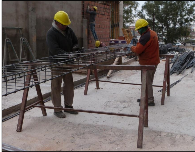
Figura 4.16: Armado de viga.
