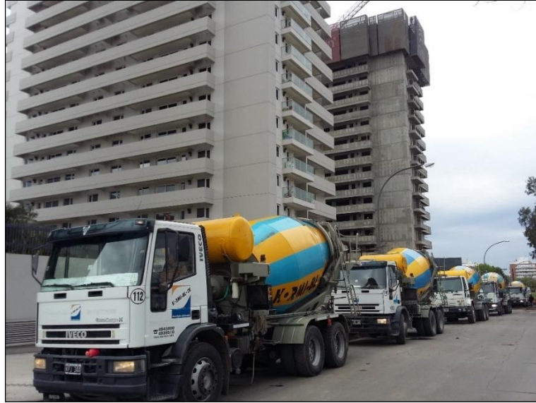
Figura 4.22: Camiones mezcladores sobre sector costanera.
