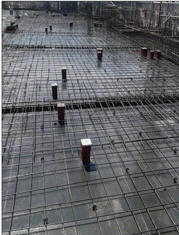
Figura 4.21: Pases en losa.
