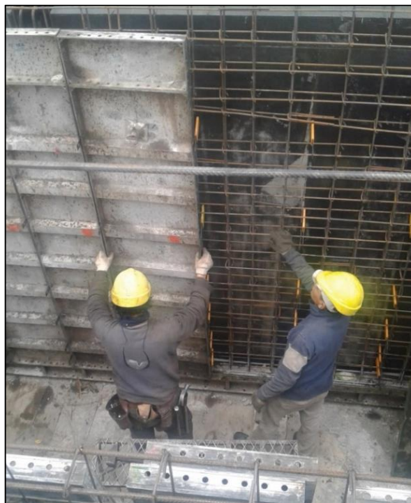
Figura 4.9: Encofrado de tabiques.
