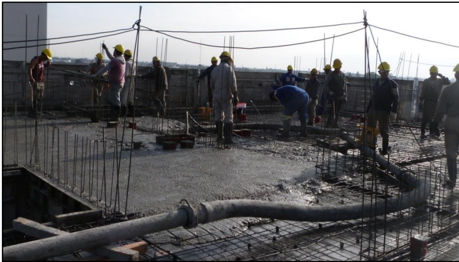
Figura 4.25: Tareas de hormigonado.
