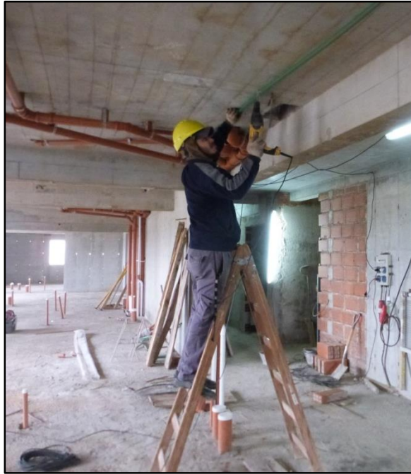
Figura 4.27: Obrero trabajando en instalaciones pluviales.
