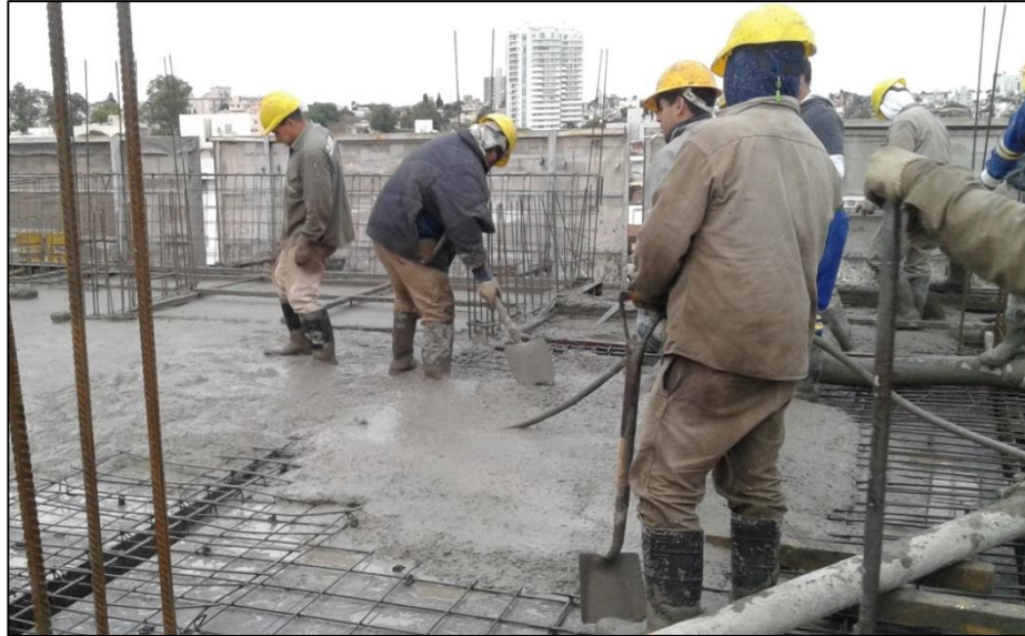
Figura 4.24: Operarios durante el hormigonado.
