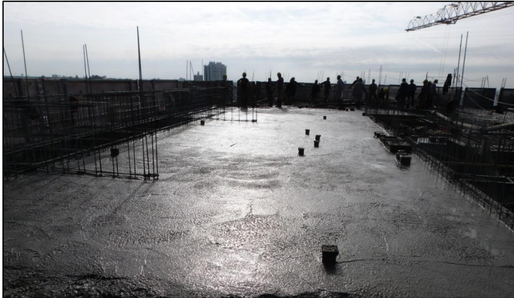
Figura 4.26: Alisado final de superficie.
