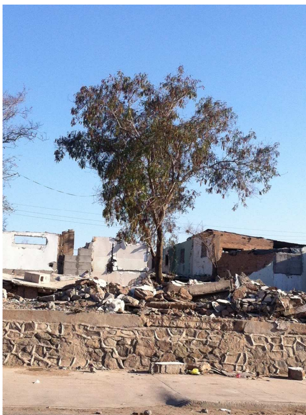
Aspecto actual del deterioro en el barrio de Pueblo Nuevo.
