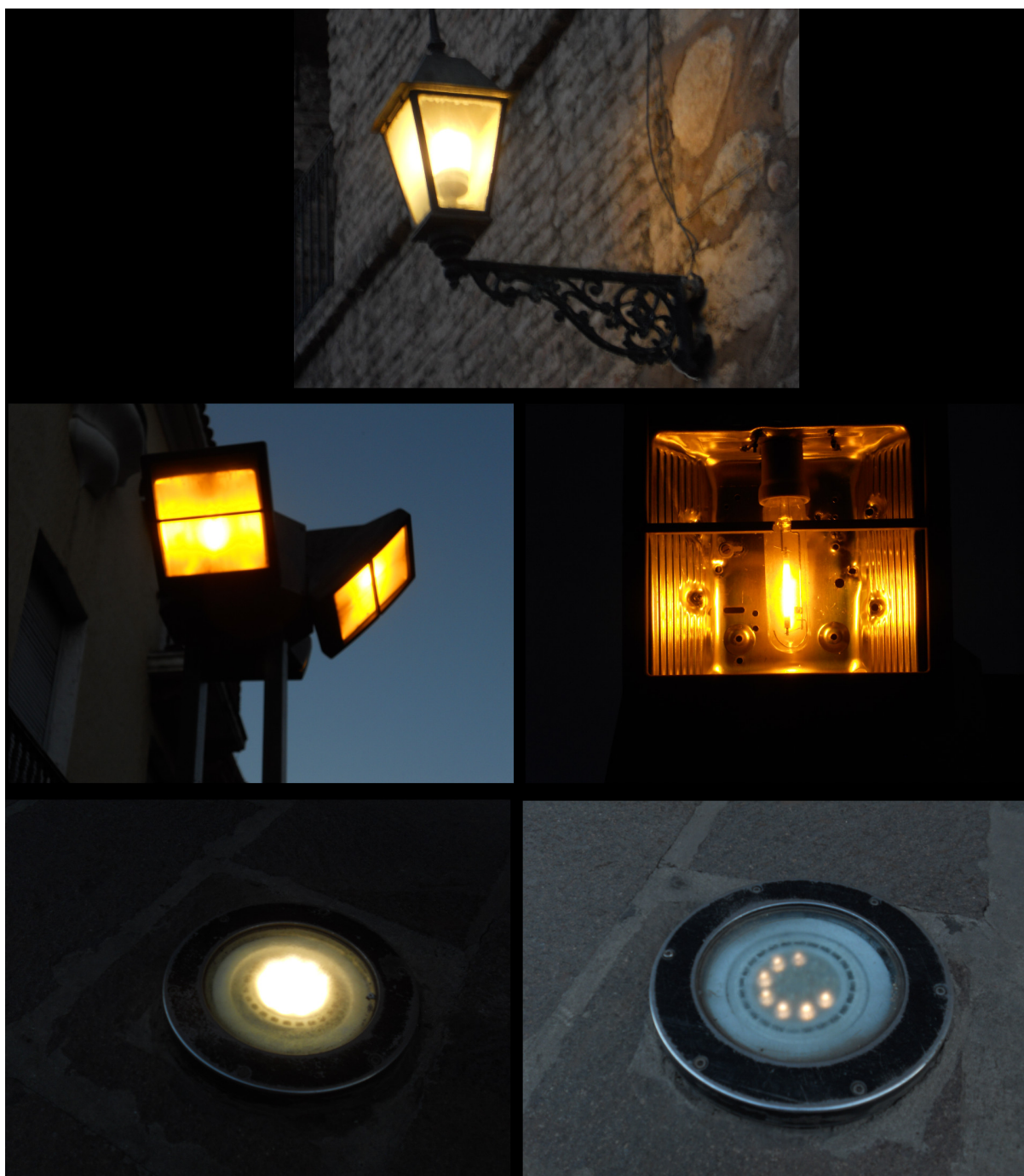
16) Detalle de luminarias, de arriba a abajo: Farol del muro de la Iglesia, farol del alumbrado público, luminaria empotrada en el suelo. Fuente: Imagen propia
