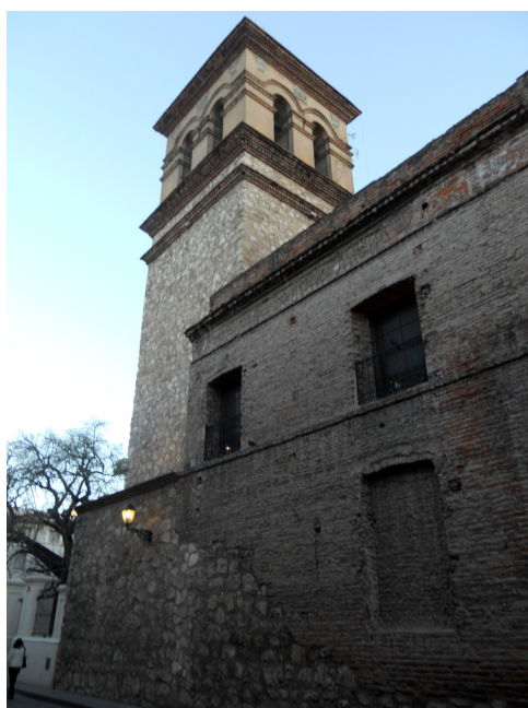
6) Vista del ingreso a la Iglesia desde Caseros
