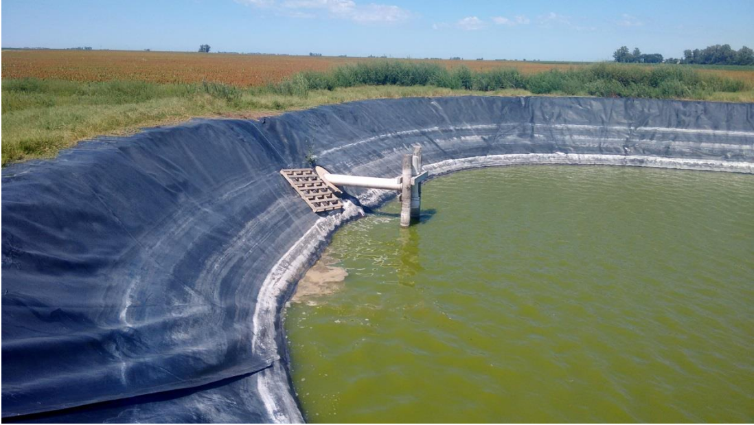
Figura 5: Salida del Líquido Tratado.
