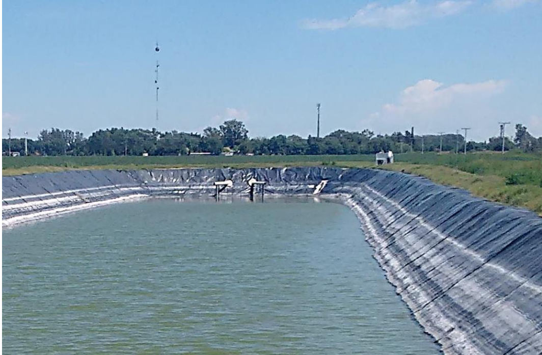
Figura 4: Ingreso del efluente cloacal a la Laguna Facultativa por medio de cañerías de PVC.
