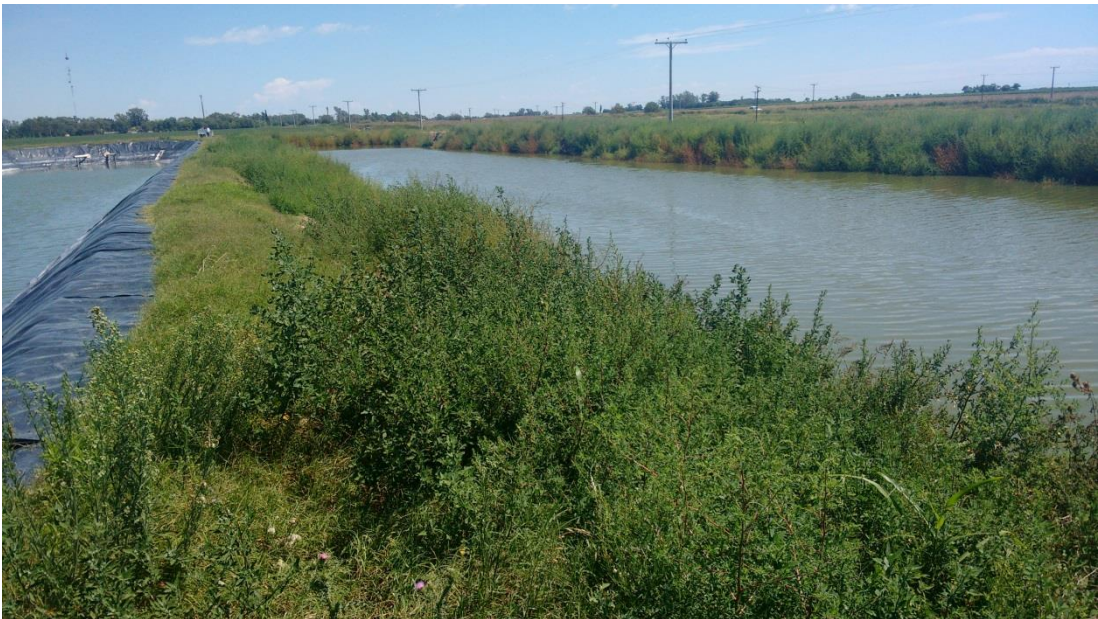
Figura 6. Sistema de Tratamiento existente por medio de Lagunas Facultativas.
