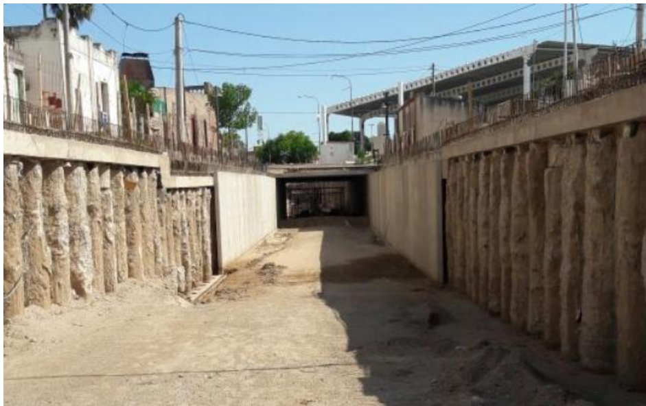
Figura 4.19 – Esquema final de la pantalla de pilotes
