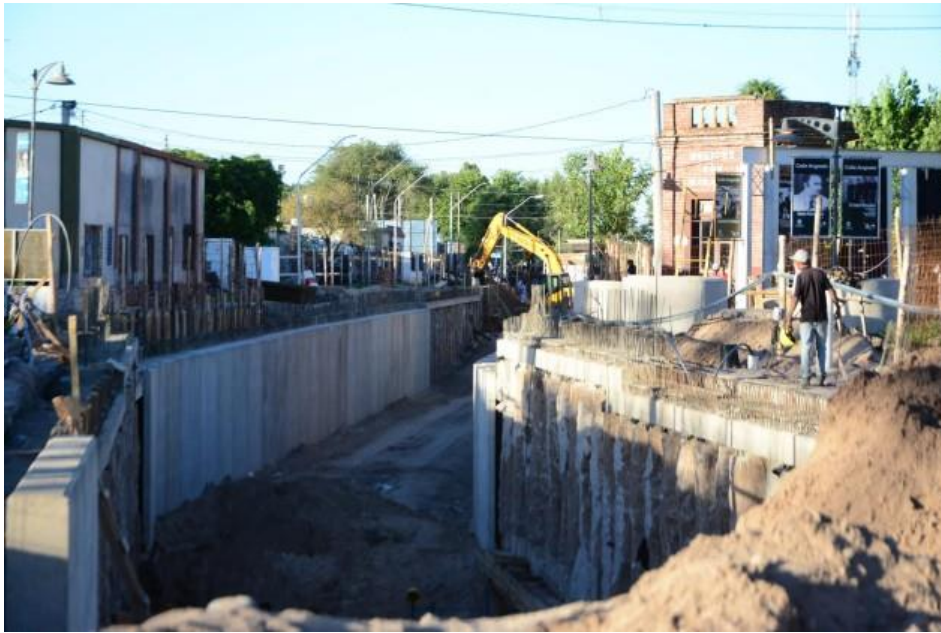
Figura 4.18 – Fotografía de pantalla de pilotes
