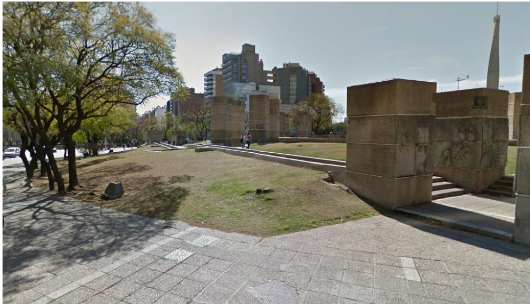
Figura 2.6 – Imagen de estructuras de Plaza España (Google Earth)
