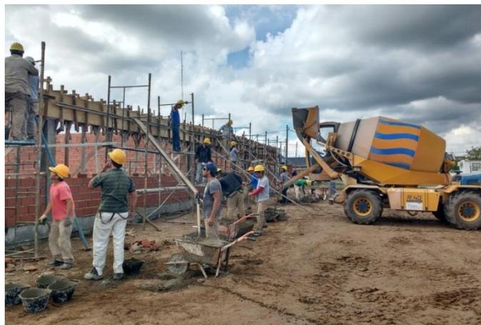
Figura 3.9.25 Hormigonado de vigas
