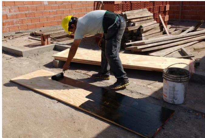
Figura 3.9.19 Aplicación de una mano de gasoil a encofrados laterales de viga
