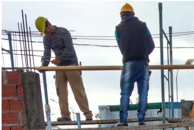
Figura 3.9.14 Colocación de fondo de viga y listón triangular de bisel
