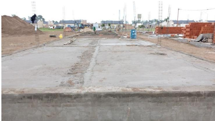
Figura 3.7.11 Llenado de juntas con hormigón
