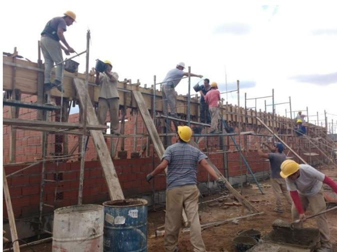
Figura 3.9.26 Modalidad de ejecución del hormigonado de vigas
