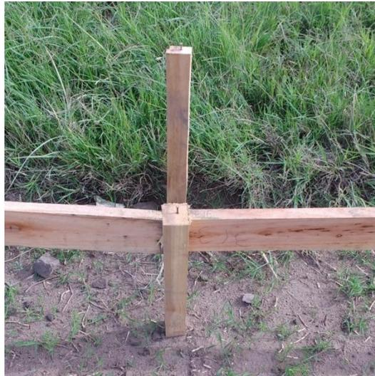
Figura 3.3.5 Detalle de materialización de nivel
