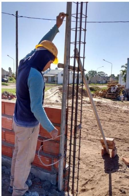
Figura 3.8.1 Aplomado de reglas metálicas verticales
