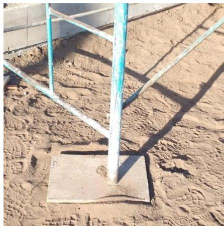
Figura 4.7.2 Zapata de apoyo de andamios
