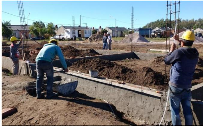
Figura 3.6.4 Traslado del nivel de referencia con nivel de burbuja.
