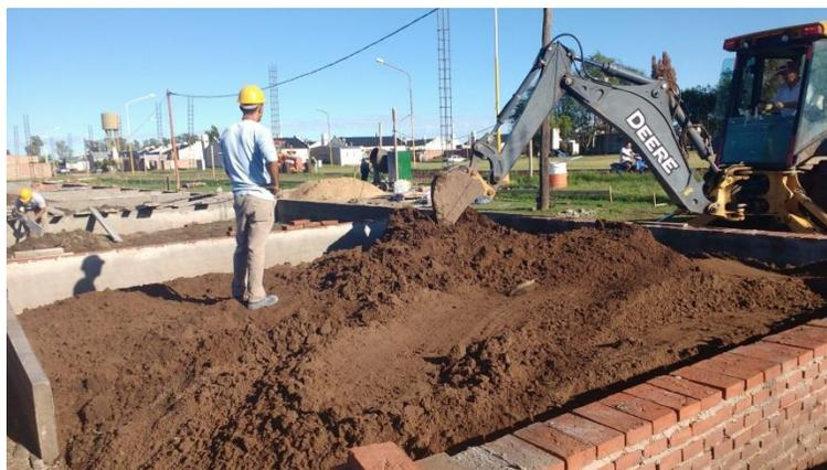
Figura 3.7.5 Aporte de suelo para relleno hasta nivel de contrapiso
