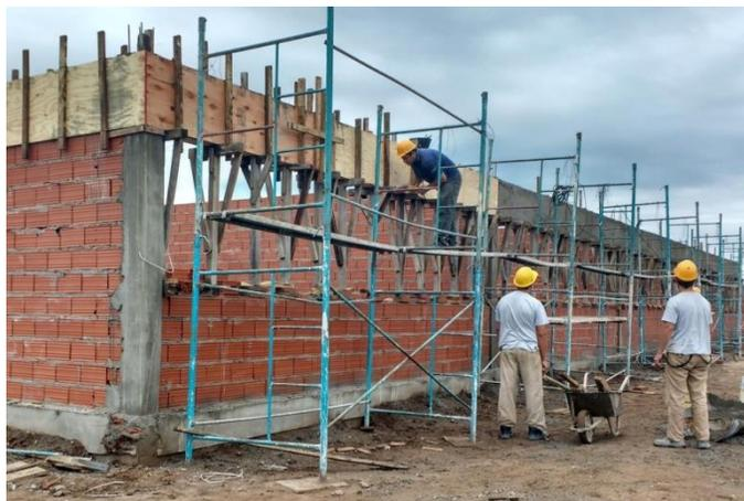
Figura 3.9.31 Desencofrado de placas laterales de vigas perimetrales
