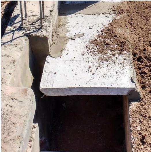
Figura 3.10.10 Empotramiento de losetas superiores del conducto de retorno
