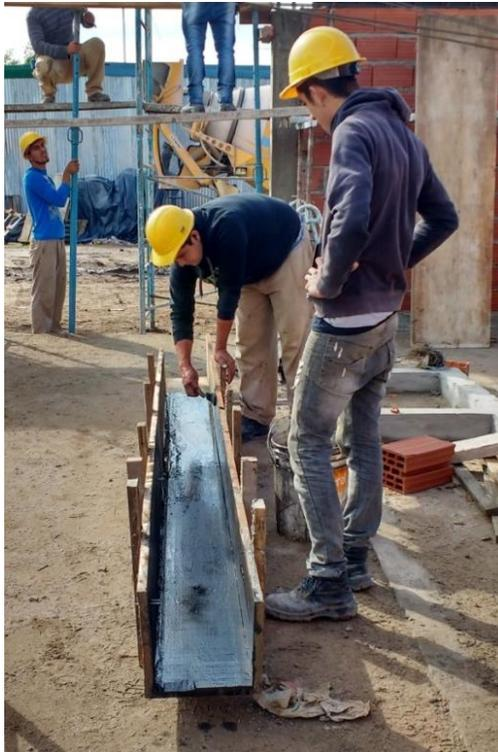
Figura 3.9.38 Aplicación de una mano de gasoil
