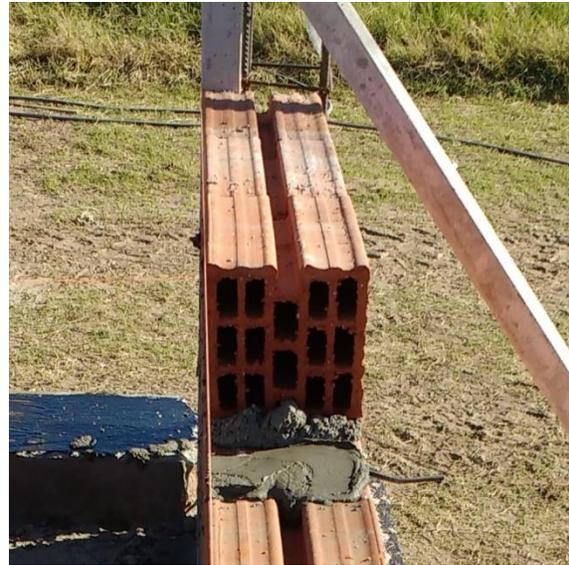
Figura 3.8.3 Alineación del canto interno del ladrillo con el hilo de tanza
