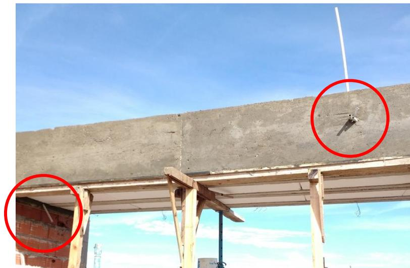
Figura 3.10.17 Canalizaciones a traves de vigas y losa
