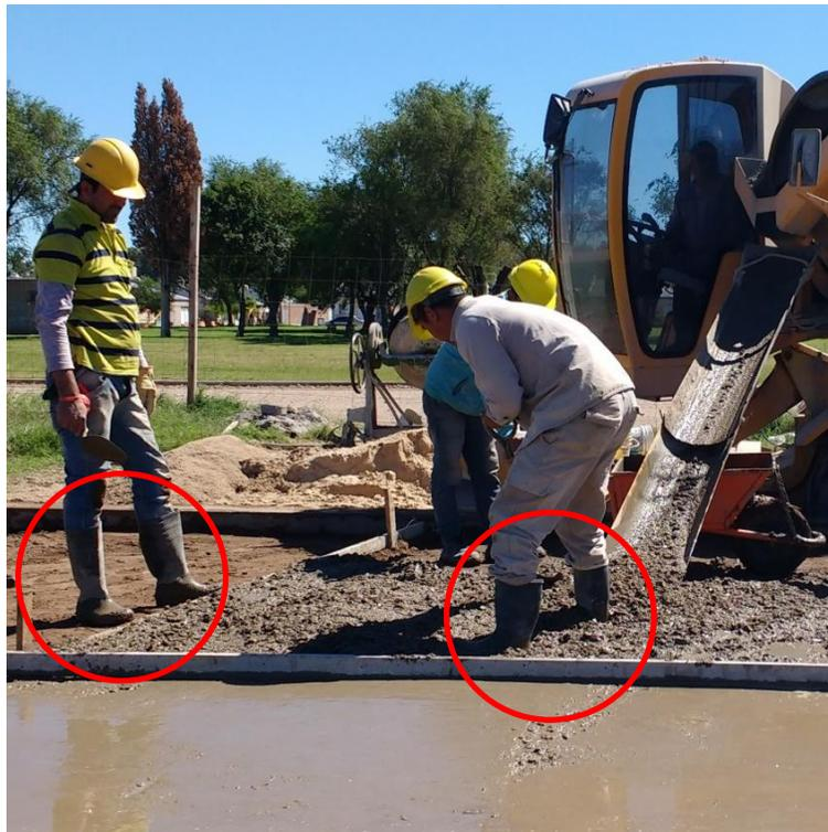
Figura 4.8.2 Botas impermeables para trabajos con hormigón
