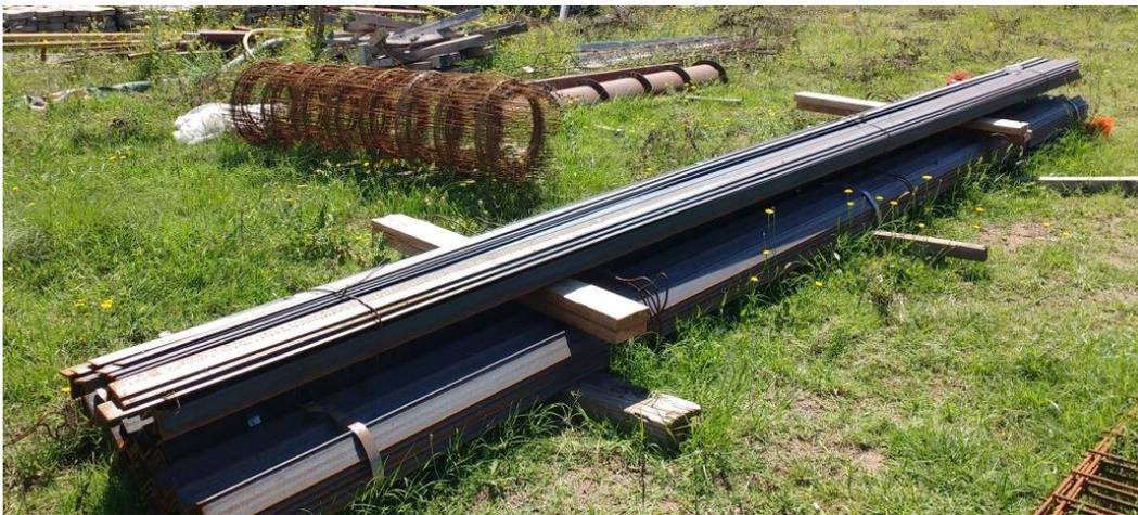
Figuras 3.2.11 Acopios de perfiles metálicos en obrador
