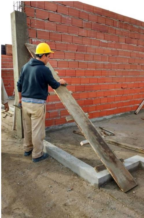
Figura 3.9.45 Limpieza de encofrados
