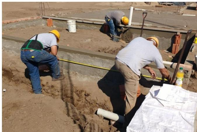
Figura 3.10.19 Posicionamiento de caños de descarga de inodoros
