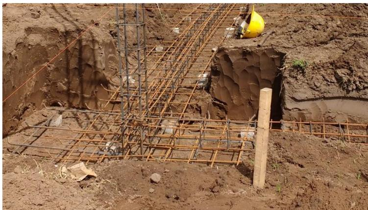
Figura 3.4.10 Encuentro de zapata corrida y zapata aislada
