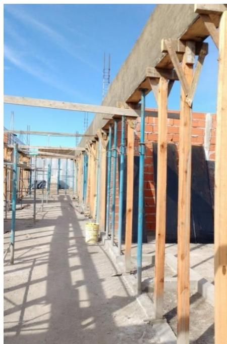
Figura 3.9.32 Desencofrado de placas laterales de vigas interiores
