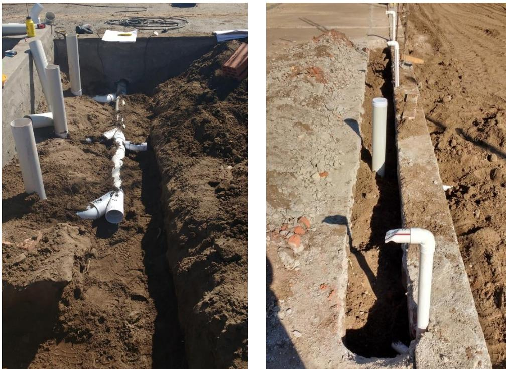
Figura 3.10.21 Cañerías colocadas debajo del contrapiso – red cloacal
