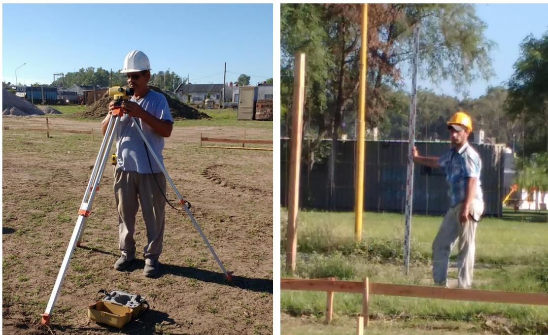
Figura 3.3.4 Nivelación con nivel óptico
