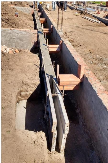
Figura 3.10.2 Hormigonado de tabique lateral del conducto de retorno
