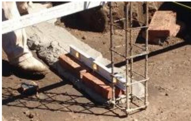
Figura 3.5.7 Verificación de hiladas con nivel de burbuja
