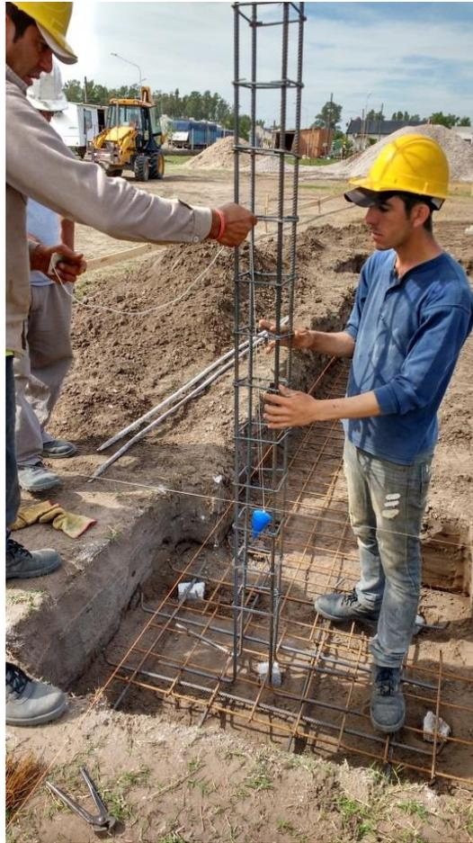
Figura 3.4.11 Verificación de verticalidad de columnas
