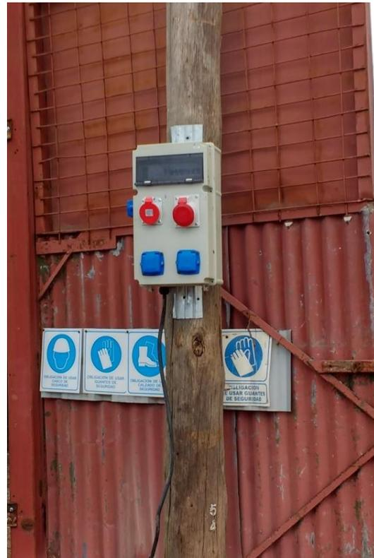
Figura 4.4.2 Tableros secundarios de conexión eléctrica
