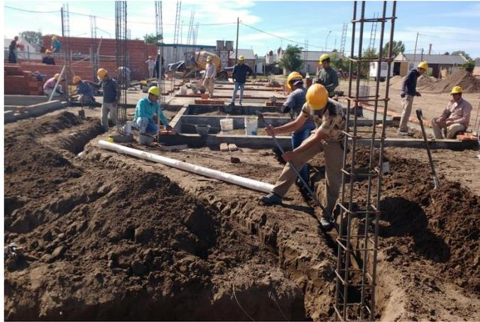
Figura 3.10.12 Excavación para tendido eléctrico subterráneo
