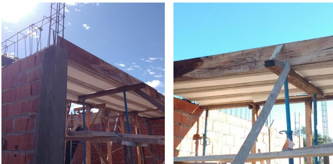
Figura 3.9.58 Encofrado para la capa de compresión
