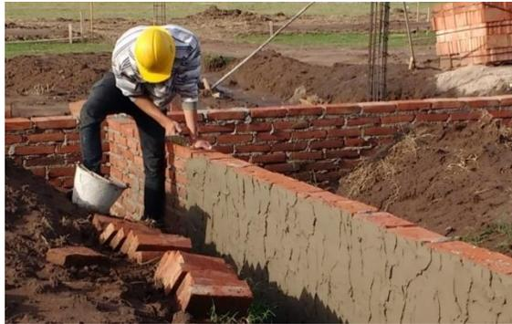
Figura 3.6.1 Azotado de mortero hidrófugo sobre mampostería de cemento.
