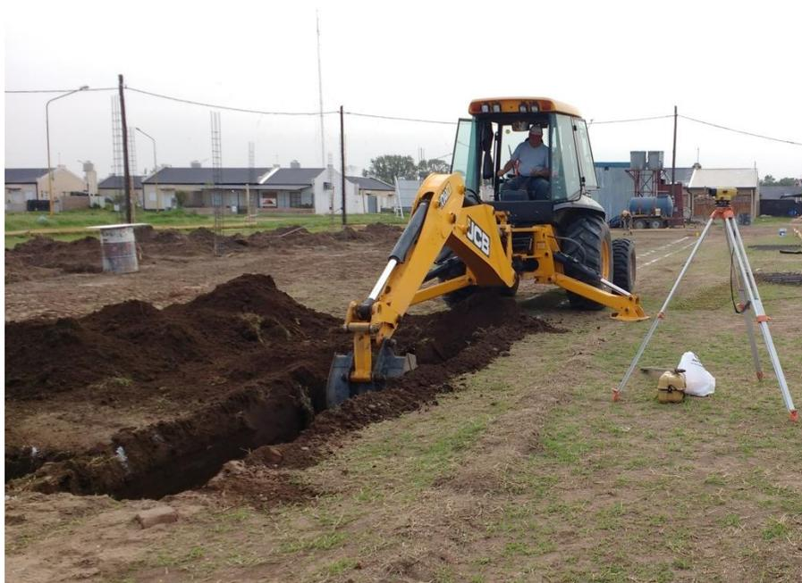
Figura 3.4.3 Excavación de zapatas corridas.
