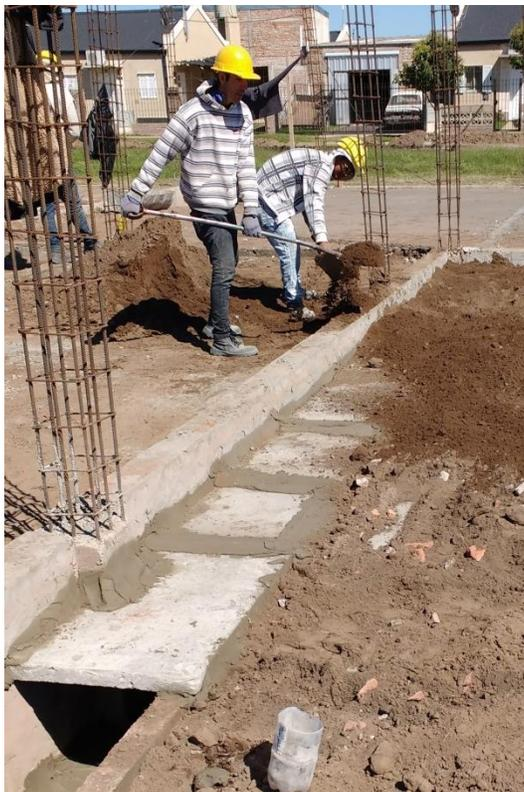
Figura 3.10.11 Cierre superior del conducto con losetas
