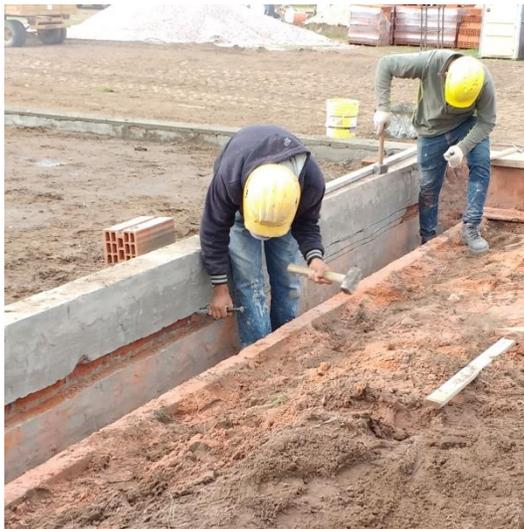
Figura 3.10.9 Hendidura para empotramiento de losetas
