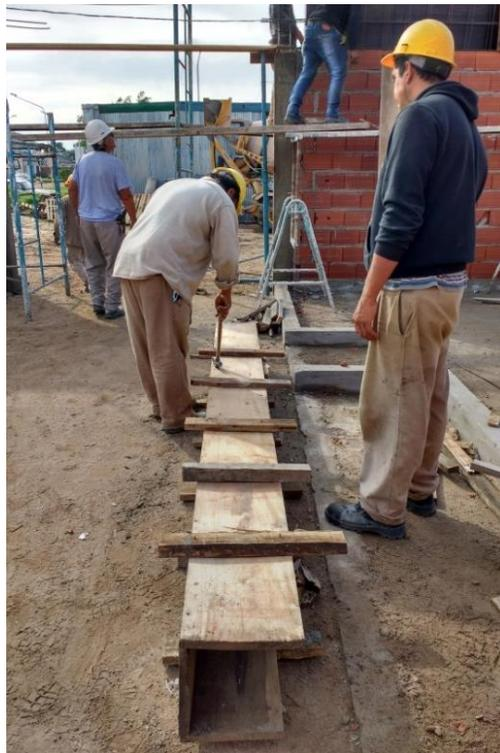
Figura 3.9.37 Armado de encofrado para columnas en esquina
