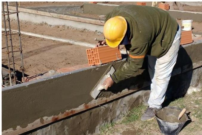
Figura 3.6.12 Estucado de cemento extendido y alisado con llana
