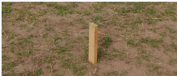
Figura 3.3.7 Estacas para indicación de nivel de referencia
