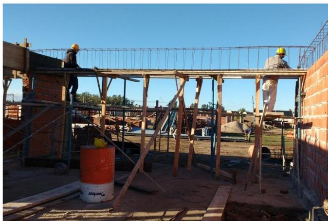
Figura 3.9.52 Colocación de viguetas
