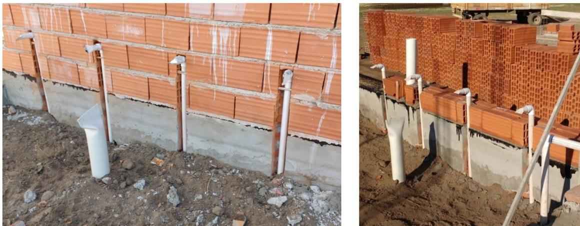
Figura 3.10.22 Cañerías colocadas en pared – red de distribución de agua
