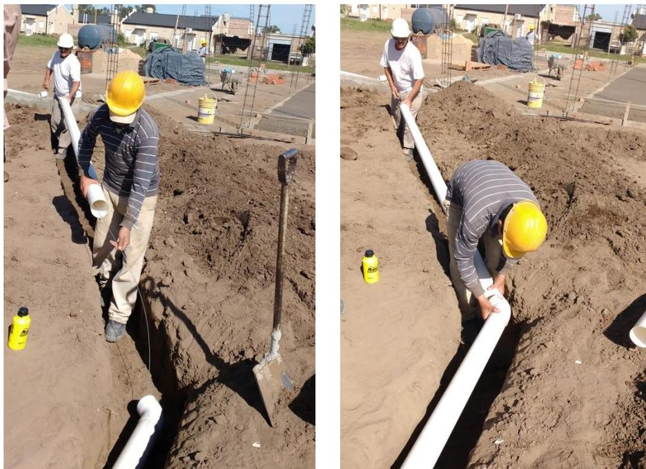
Figura 3.10.13 Unión de cañerías de PVC
