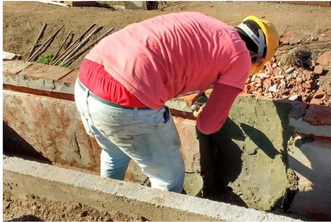
Figura 3.10.5 Azotado de mortero hidrófugo sobre conductos de retorno
