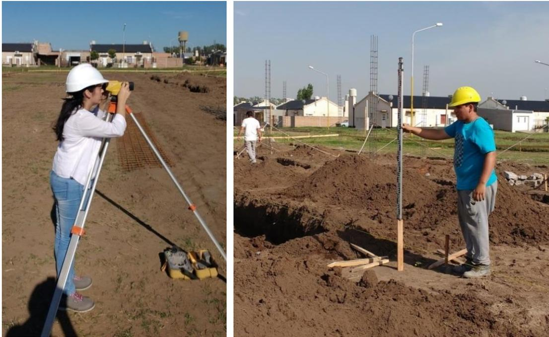
Figura 3.4.5 Nivel de referencia +0,30 para verificación de nivel de fondo de zapatas
