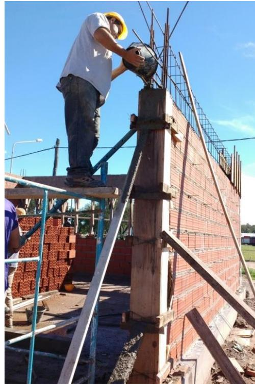
Figura 3.9.42 Hormigonado de columnas
