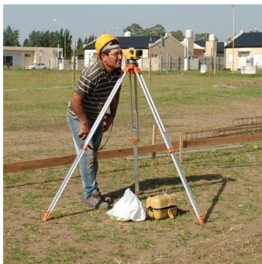
Figura 3.3.9 Verificación de Nivel superior de zapata
