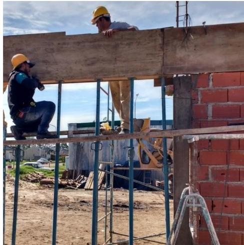
Figura 3.9.18 Fijación de paneles laterales de encofrado
