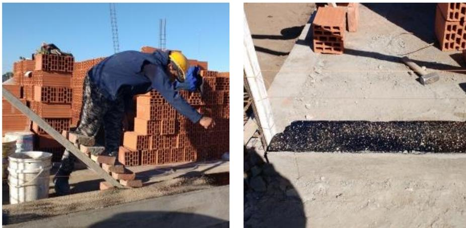
Figura 3.6.9 Arenado sobre pintura asfáltica.
