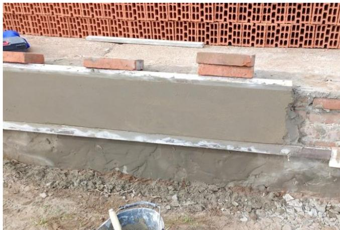
Figura 3.6.11 Azotado cementicio hidrófugo - capa aisladora vertical
