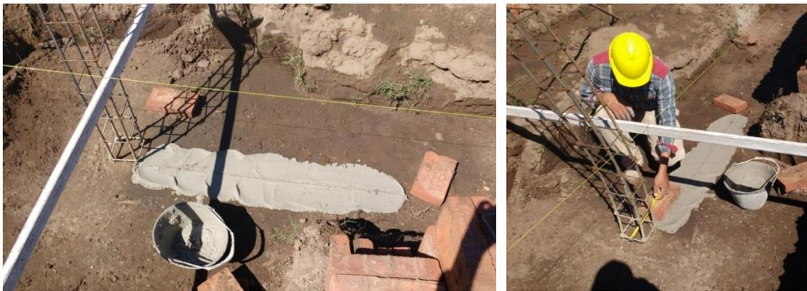
Figura 3.5.6 Posicionamiento de la primera hilada.
