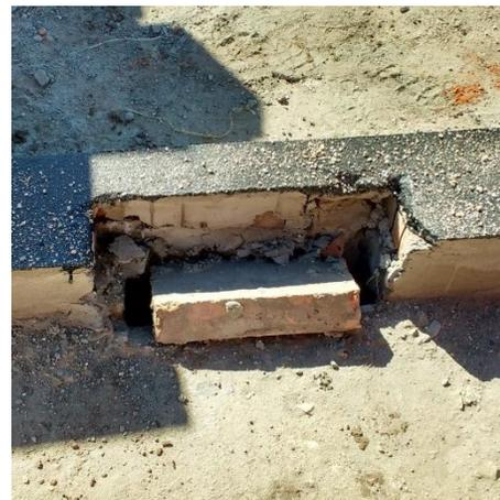
Figura 3.10.7 Subida del conducto de retorno por el muro
