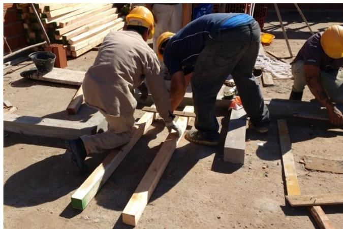
Figura 3.9.20 Armado de marcos rigidizadores de los paneles laterales
