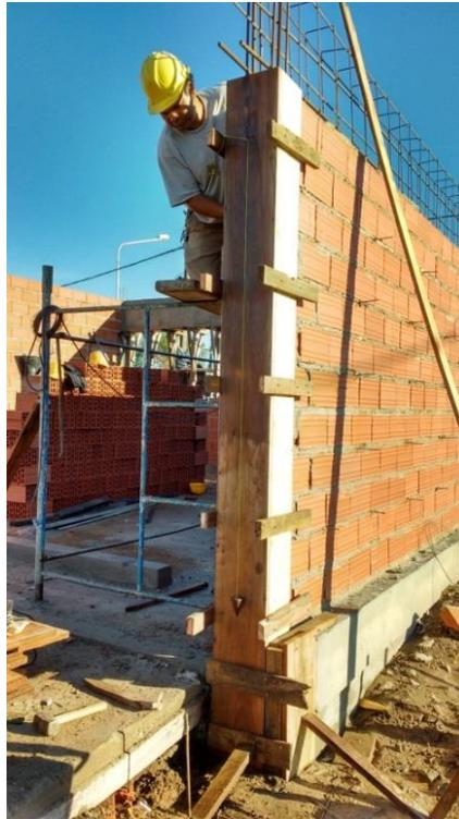
Figura 3.9.40 Verificación de verticalidad de encofrado con plomada
