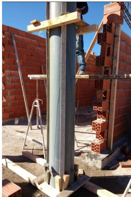
Figura 3.9.35 Aplomado de encofrados para columnas redondas
