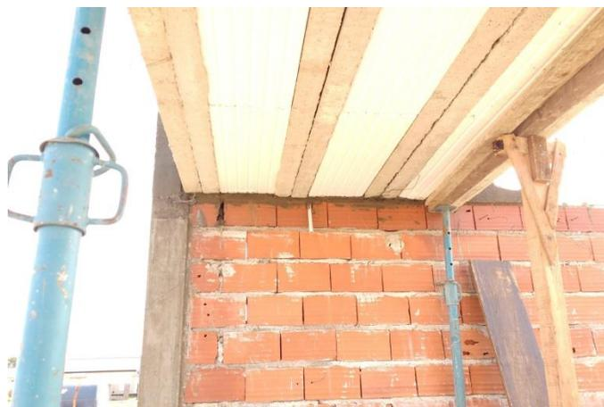
Figura 3.9.57 Colocación de bloques de poliestireno expandido
