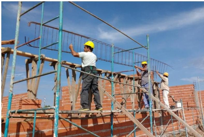
Figura 3.9.17 Colocación de armaduras de viga
