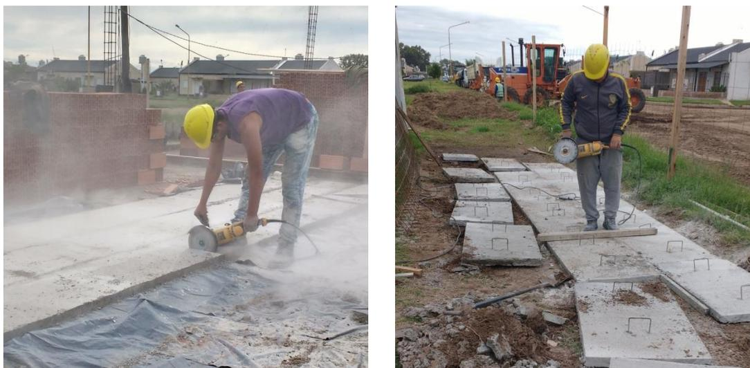
Figura 3.10.4 Corte de losetas con amoladora
