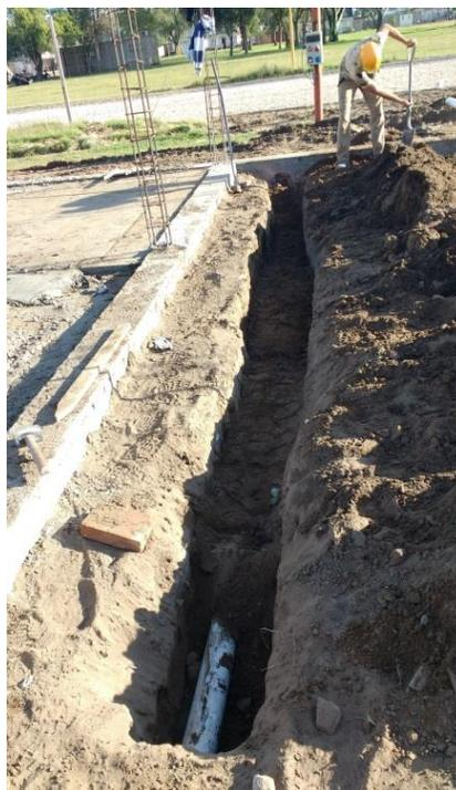
Figura 3.10.23 Caño de desagüe pluvial
