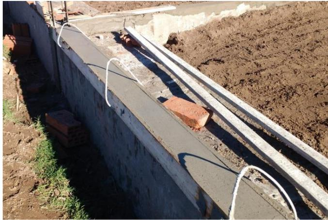
Figura 3.6.7 Capa aisladora horizontal terminada
