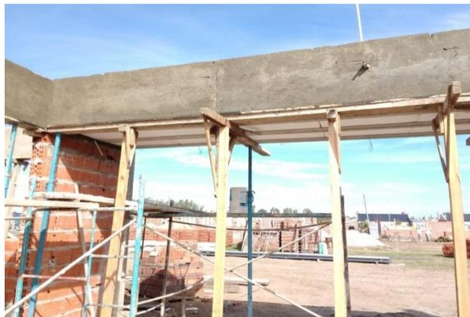
Figura 3.9.51 Viga hormigonada
