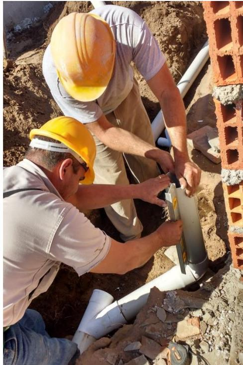
Figura 3.10.20 Verificación de verticalidad de cañerías con nivel de burbuja
