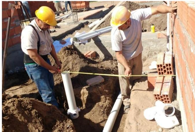
Figura 3.10.18 Ubicación y medición de piletas de piso
