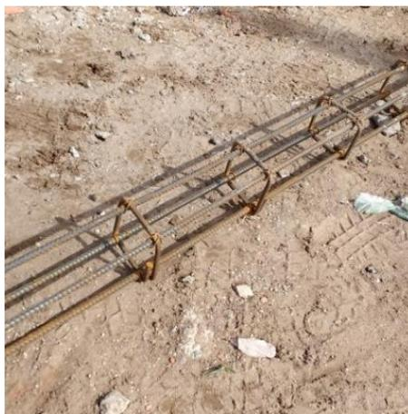
Figura 3.9.56 Armadura de nervios transversales
