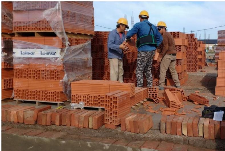
Figura 4.5.4 Movilización de mampuestos en cuadrillas.
