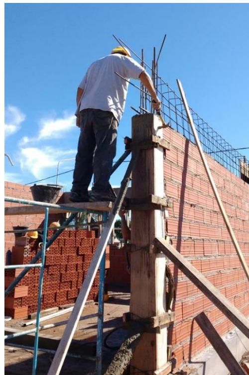
Figura 3.9.43 Vibrado de columnas y aplicación de golpes con masa
