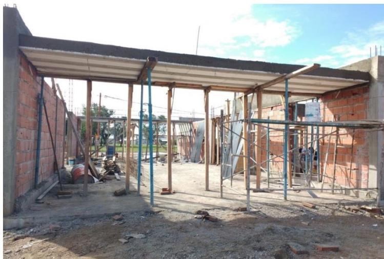
Figura 3.9.59 Losa del ingreso desde el patio hormigonada
