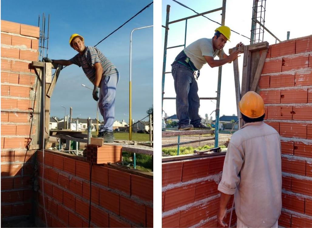
Figura 3.9.9 Posicionamiento de puntales extremos con nivel de burbuja
