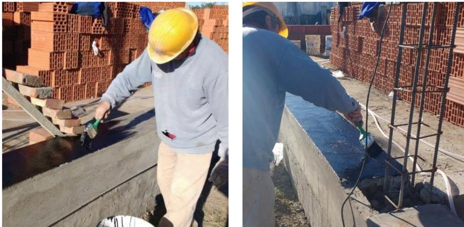
Figura 3.6.8 Aplicación de pintura asfáltica impermeabilizante de secado rápido
