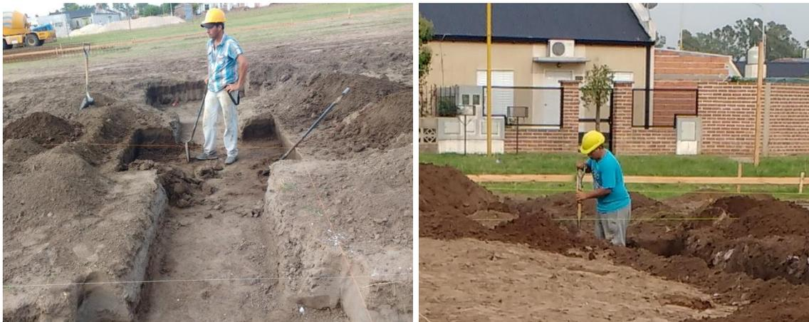
Figura 3.4.4 Excavación de zapatas aisladas.
