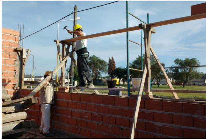
Figura 3.9.13 Fijación con clavos del tablón de fondo a los puntales de apoyo
