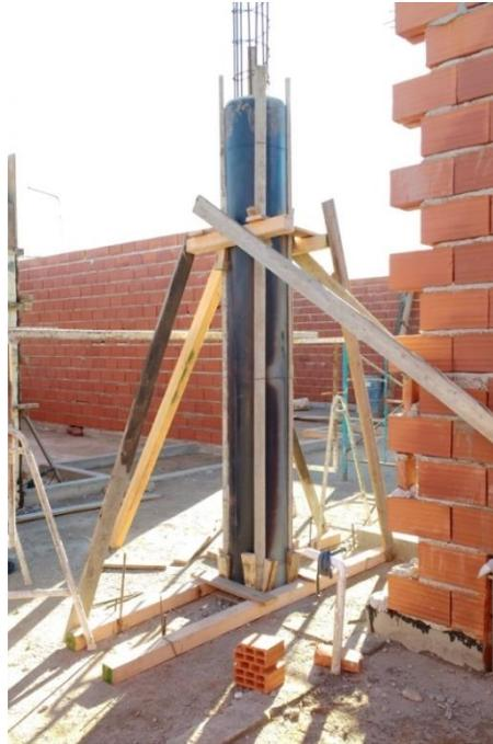
Figura 3.9.36 Apuntalamiento de encofrados para columnas redondas
