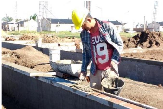
Figura 3.6.6 Distribución del mortero cementicio hidrófugo
