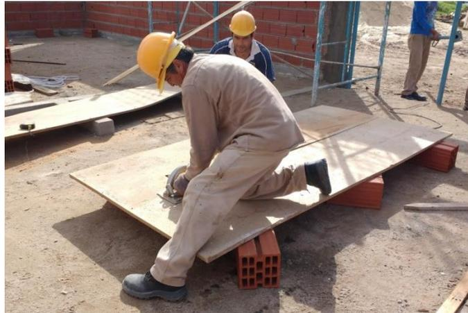
Figura 3.9.8 Corte de placas fenólicas para encofrados
