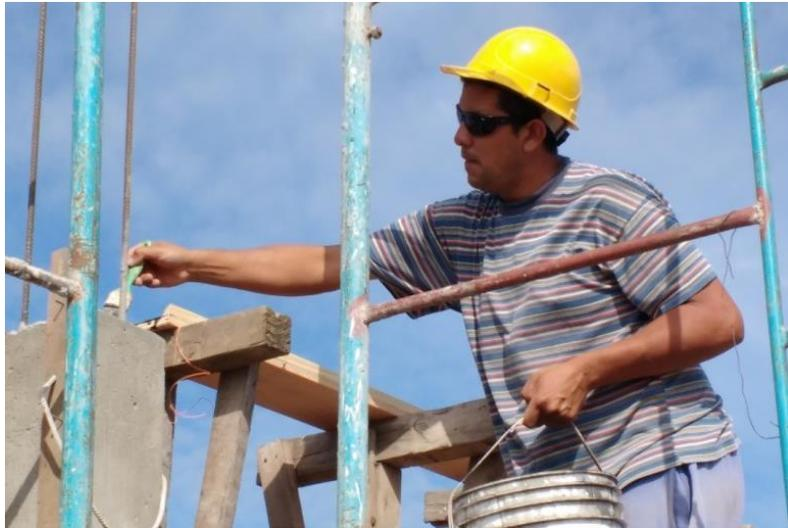
Figura 3.9.16 Aplicación de una mano de gasoil sobre tablón de fondo
