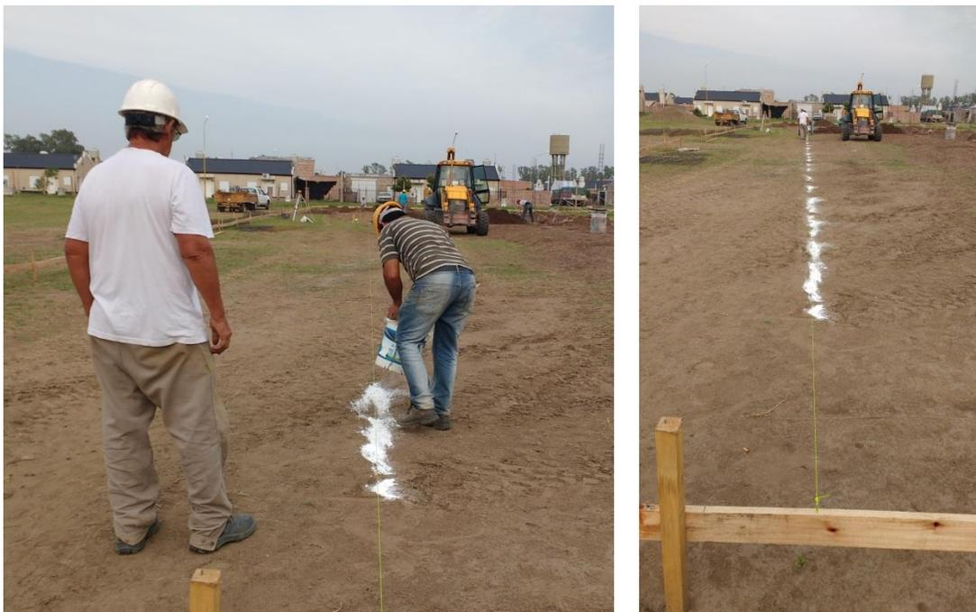
Figura 3.4.2 Replanteo de zapatas – marcado con cal
