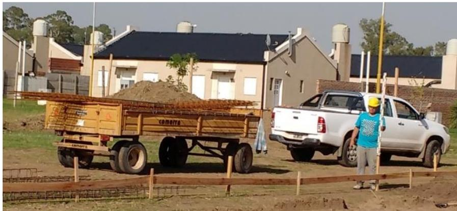
Figura 4.6.2 Traslado de armaduras en acoplado.
