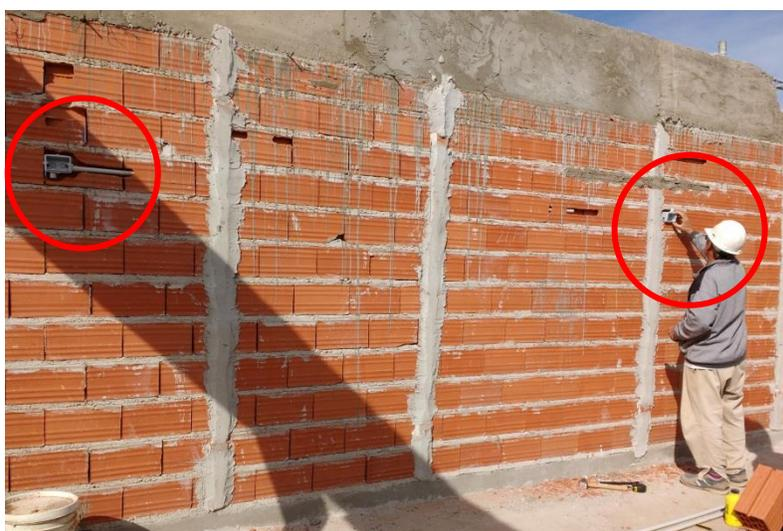
Figura 3.10.15 Instalación eléctrica embutida en mampostería
