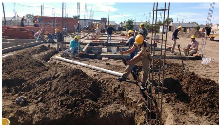
Figura 3.7.2 Caños de PVC para cableado subterráneo de la instalación eléctrica
