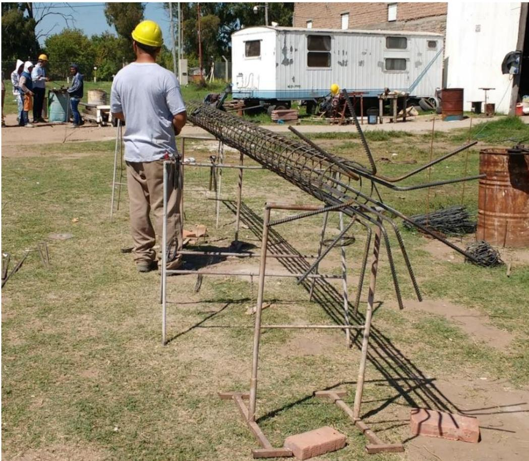
Figuras 3.2.14 Sector destinado al armado de armaduras de columnas.
