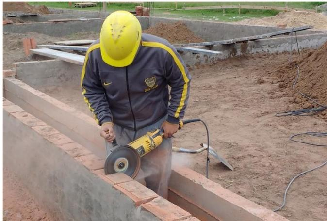
Figura 3.10.6 Cortes sobre el muro para tomas de aire
