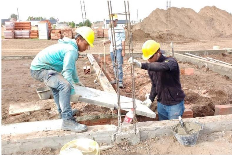
Figura 4.5.3 Manipulación de losetas de Hormigón para conductos de retorno.
