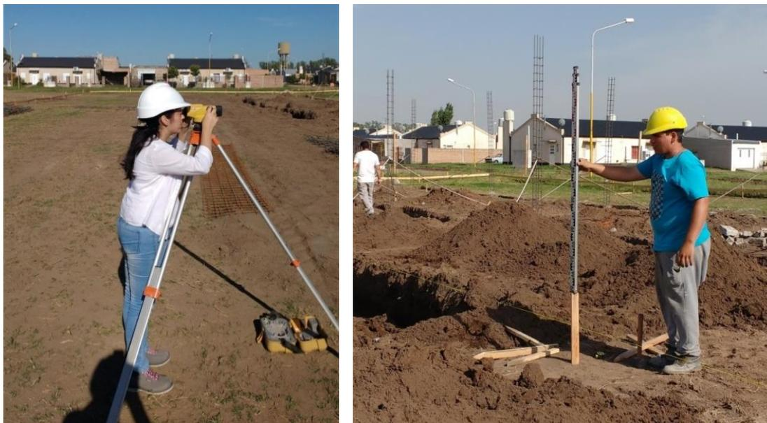
Figura 3.3.8 Nivel de referencia +0,30 para verificación de nivel de zapatas.
