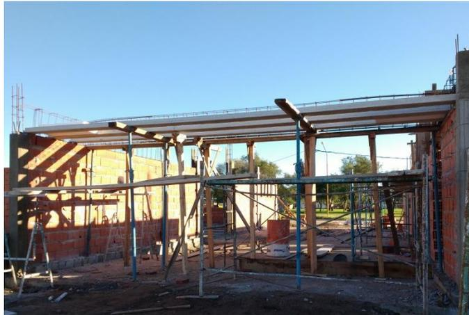
Figura 3.9.46 Andamios para armado de losas
