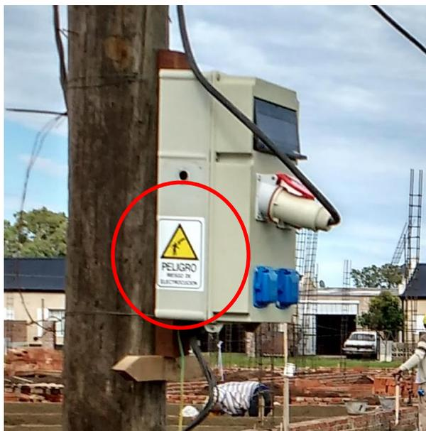
Figura 4.4.4 Señalización de riesgo eléctrico
