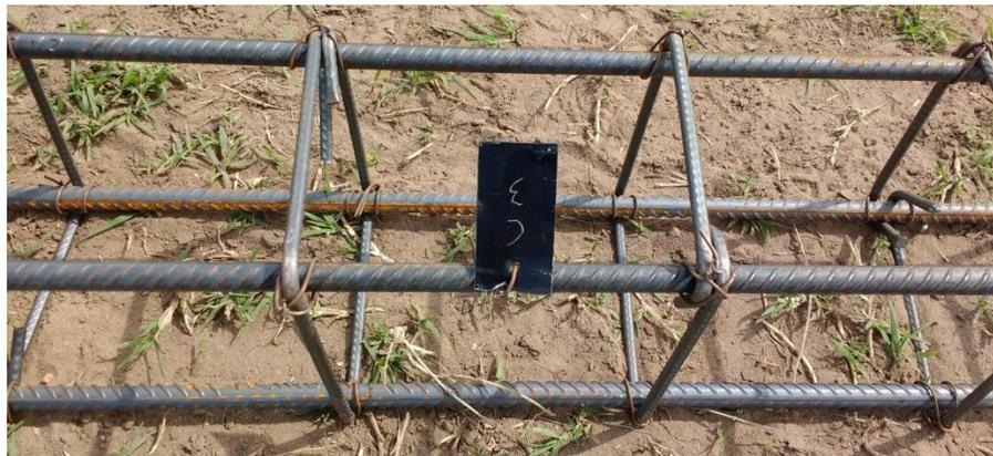
Figura 3.4.8 Placa de identificación de armadura de columna
