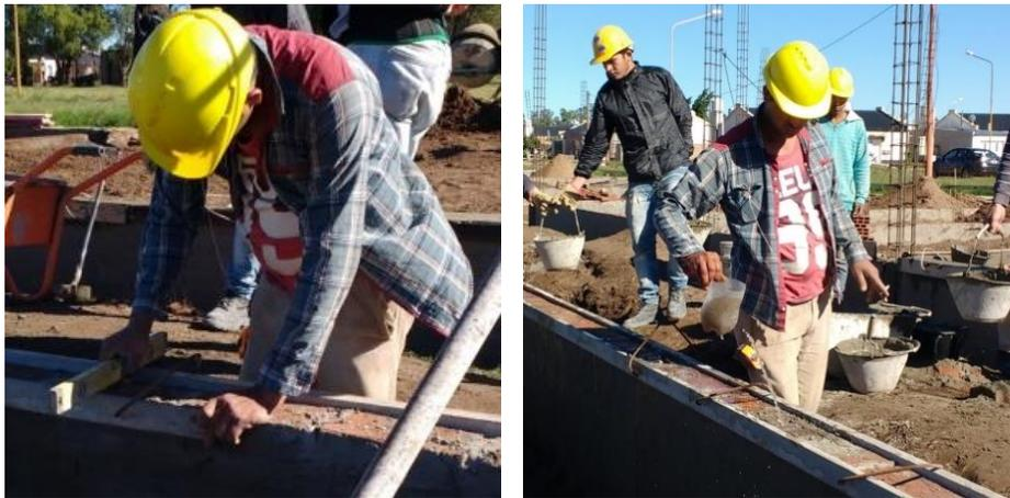
Figura 3.6.5 Nivelación de perfiles con nivel de burbuja y mojado de la superficie
