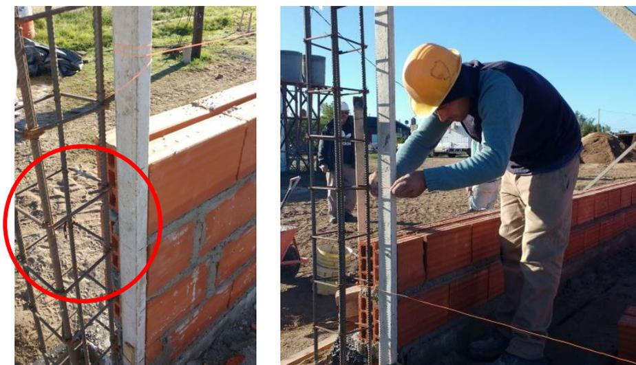
Figura 3.8.2 Marcado de hiladas sobre regla metálica y extensión de hilo de tanza
