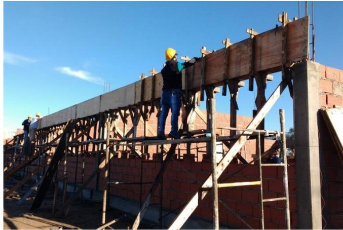
Figura 3.9.21 Colocación de marcos rigidizadores de los paneles laterales
