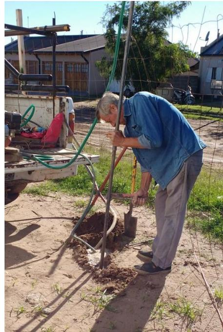
Figura 4.4.8 Ejecución de excavación para colocación de jabalina
