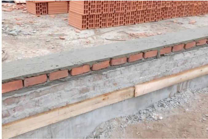
Figura 3.6.10 Fijación de tablas de maderas para ejecución de capa aisladora vertical
