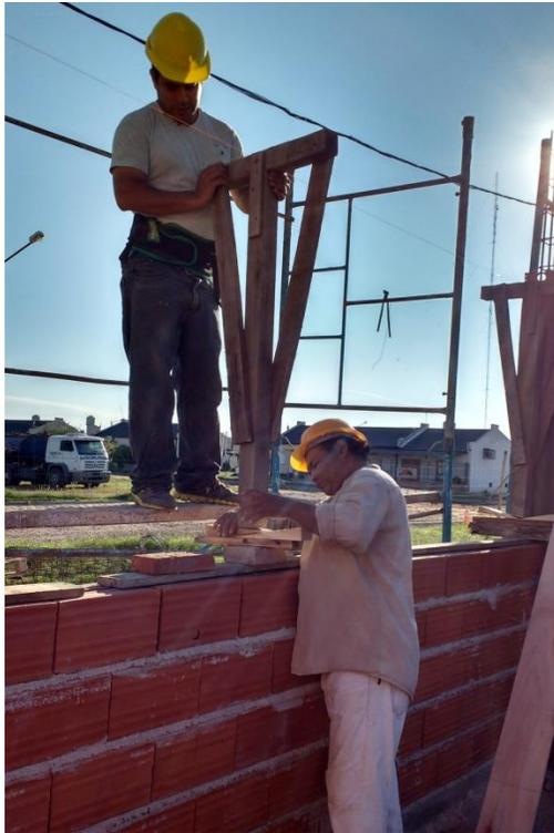
Figura 3.9.11 Ubicación de puntales intermedios y Regulación de altura con cuñas
