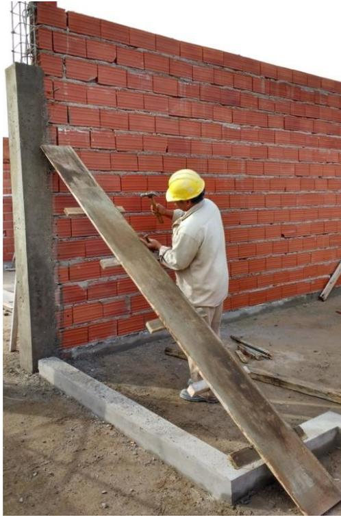
Figura 3.9.44 Desencofrado
