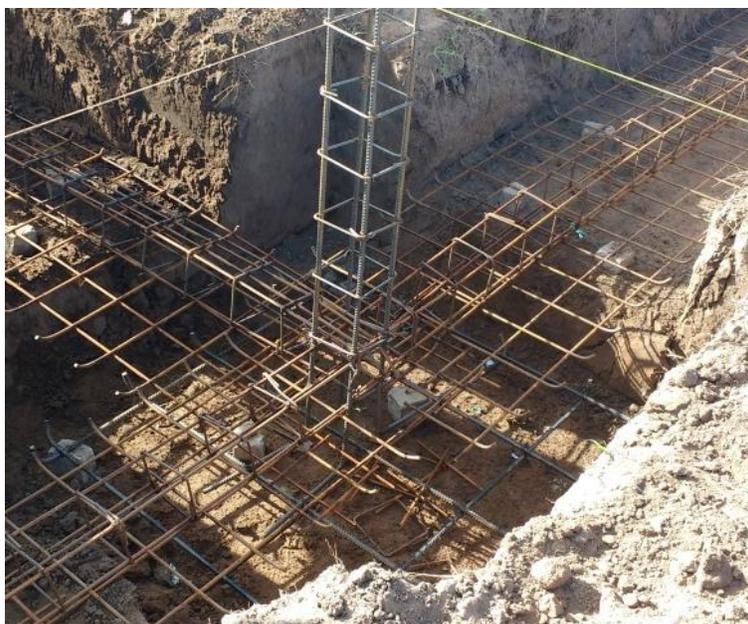
Figura 3.4.13 Encuentro de columnas y vigas de arriostramiento
