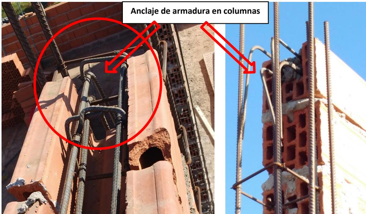
Figura 3.9.6 Detalle de anclaje de armadura
