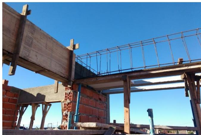
Figura 3.9.49 Tablones de fondo de encofrado de viga
