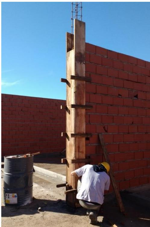
Figura 3.9.39 Colocación de bridas y amarre de encofrado
