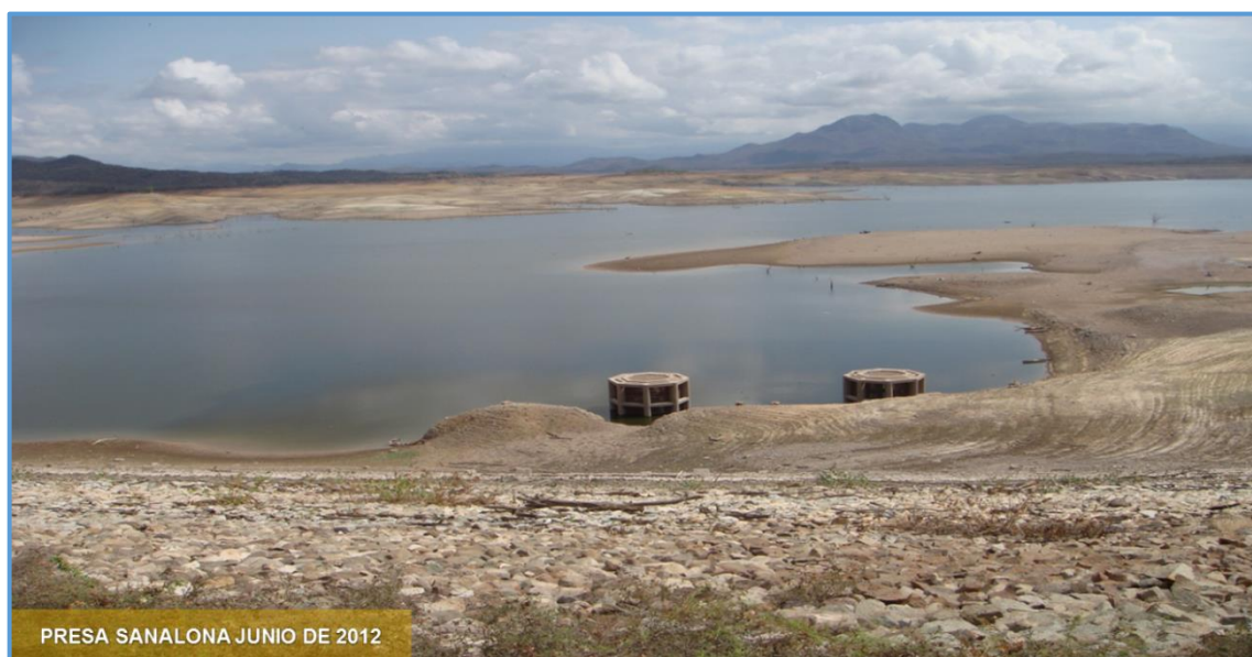
Foto A: Vista panorámica del vaso de almacenamiento de la presa Sanalona desde la cortina hacia aguas arriba, en el mes de junio de 2012, con un nivel de almacenamiento del 3%.
