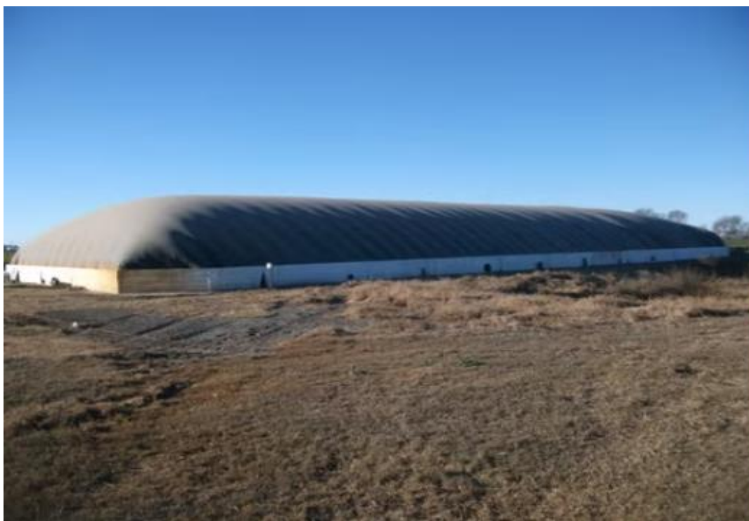
Figura 14: Primer biodigestor, establecimiento La Laica S.R.L.
