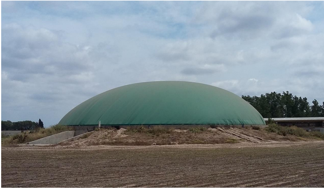
Figura 15: Segundo biodigestor, establecimiento La Laica S.R.L.
