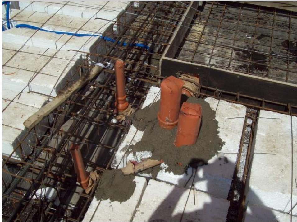
Instalación de Desagües en Cocina
