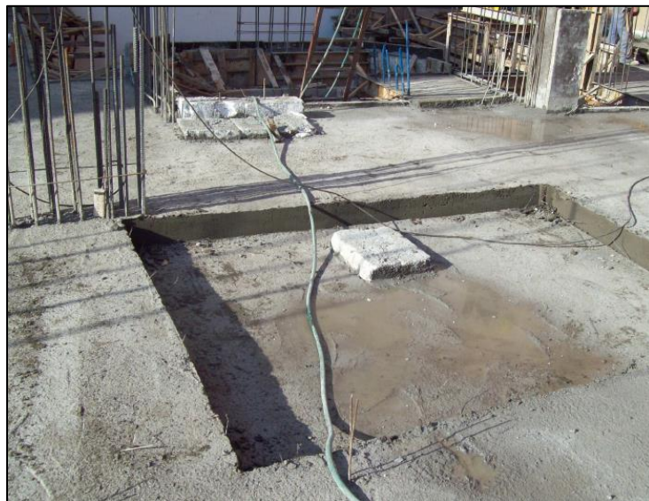
Bandeja Sanitaria Terminada
