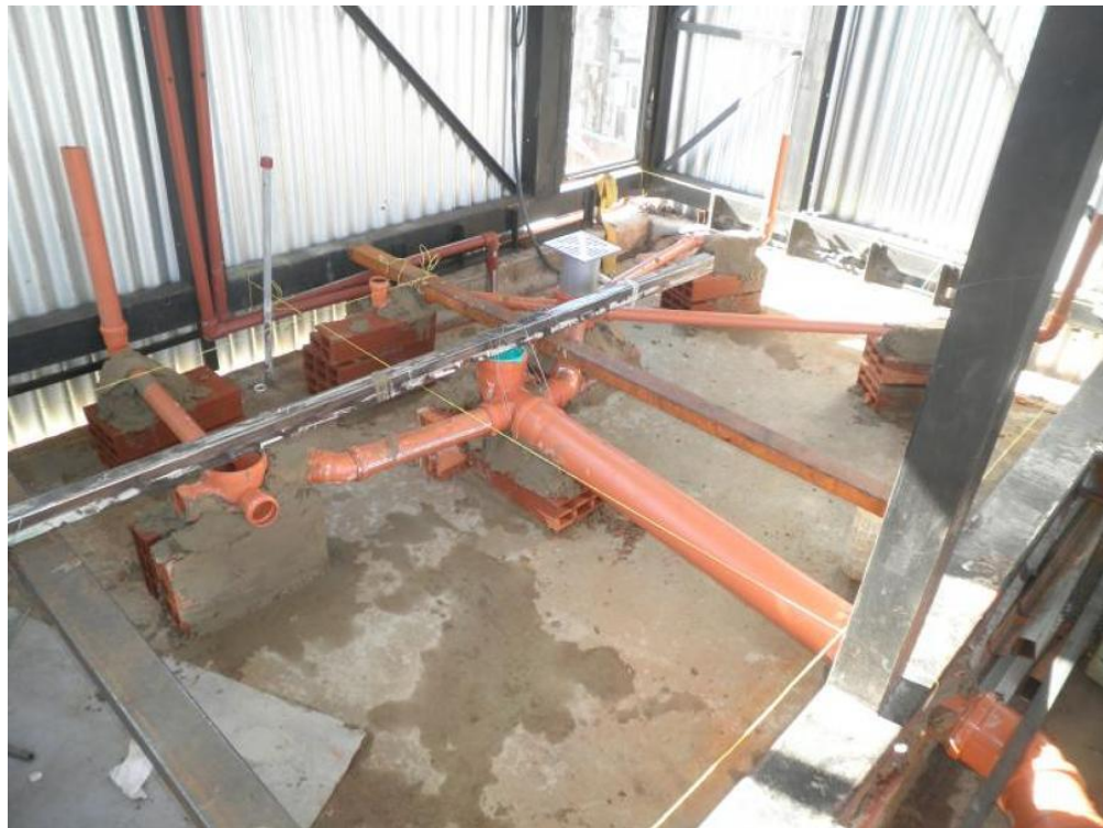
Instalación Cloacal en Baño
