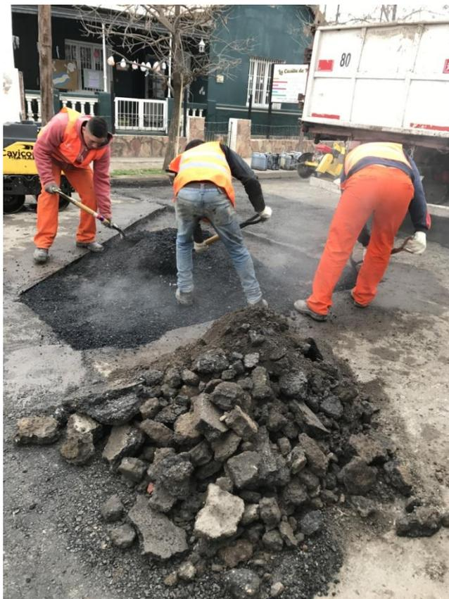
Figura 11. Descarga de mezcla asfáltica y esparcimiento. Fuente: propia.
