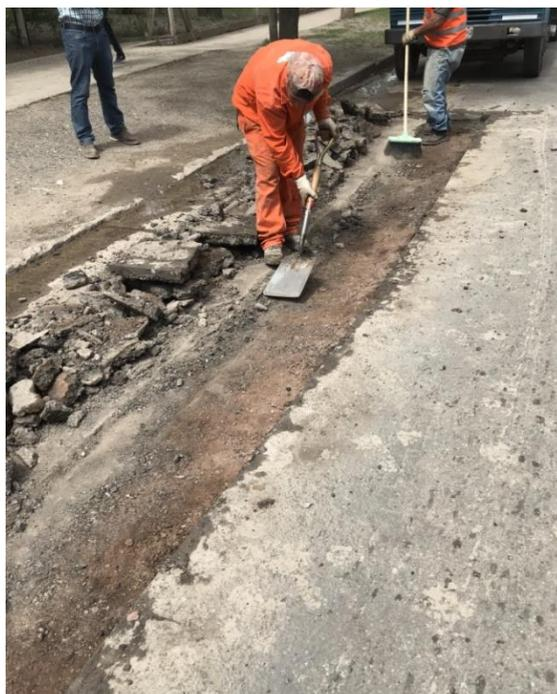
Figura 9. Retiro de material y limpieza. Fuente: propia.
