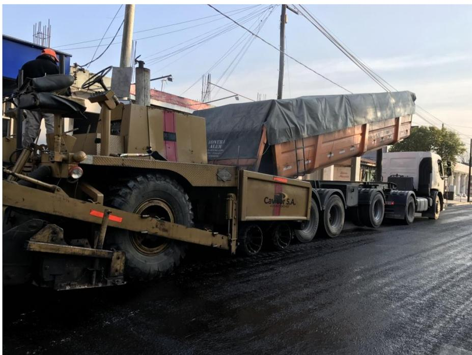
Figura 17. Descarga de batea en la terminadora. Fuente: propia.
