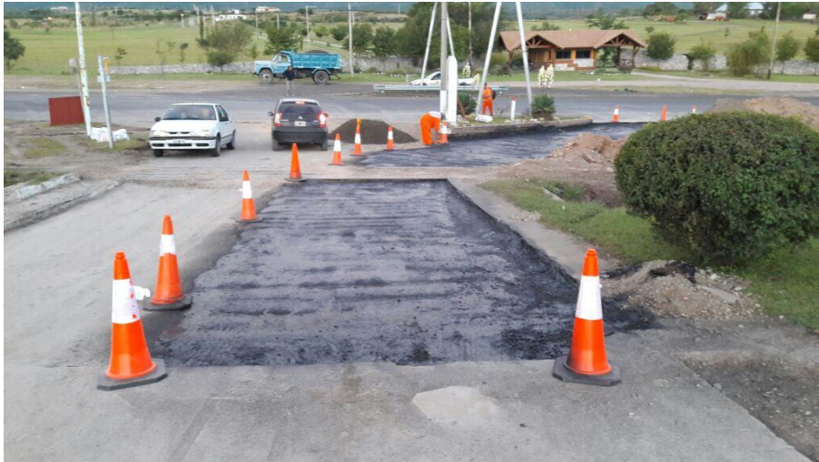
Imagen N°8: Riego de Imprimación en el polígono B y señalización diurna
