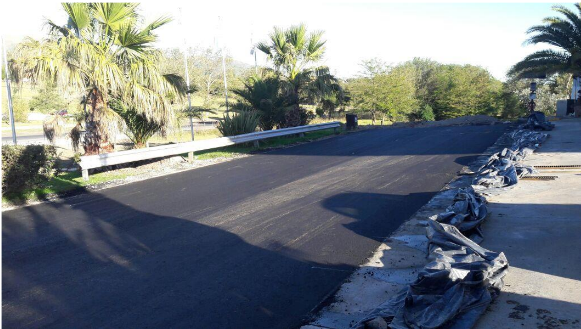
Imagen N°7: Polígono A finalizado
