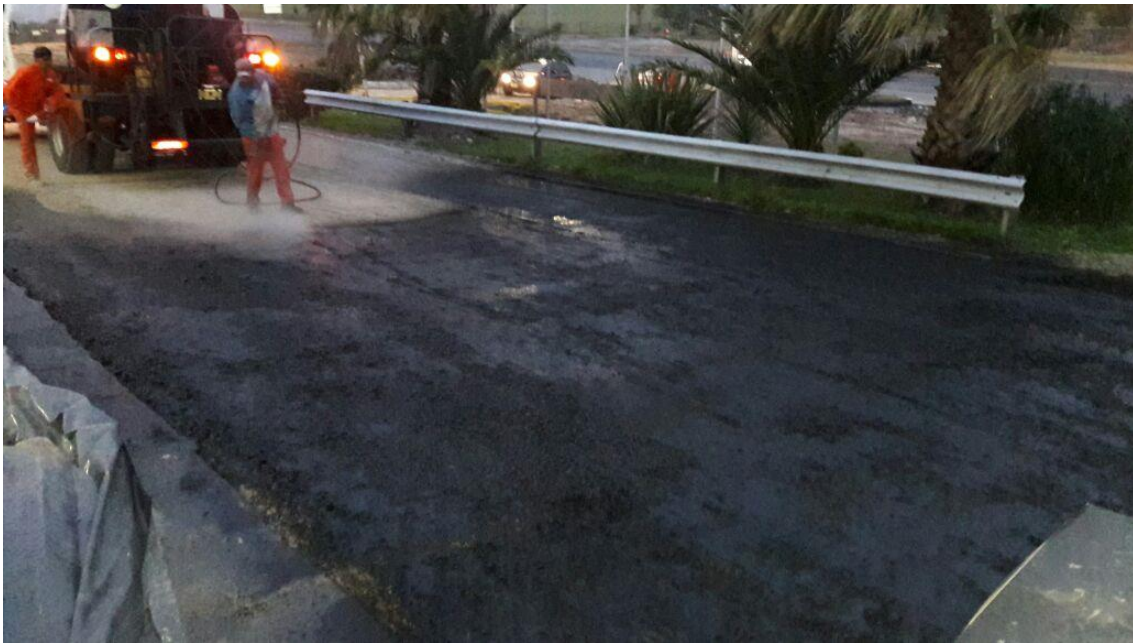
Imagen N°5: Colocación de riego de imprimación con lanza (2)
