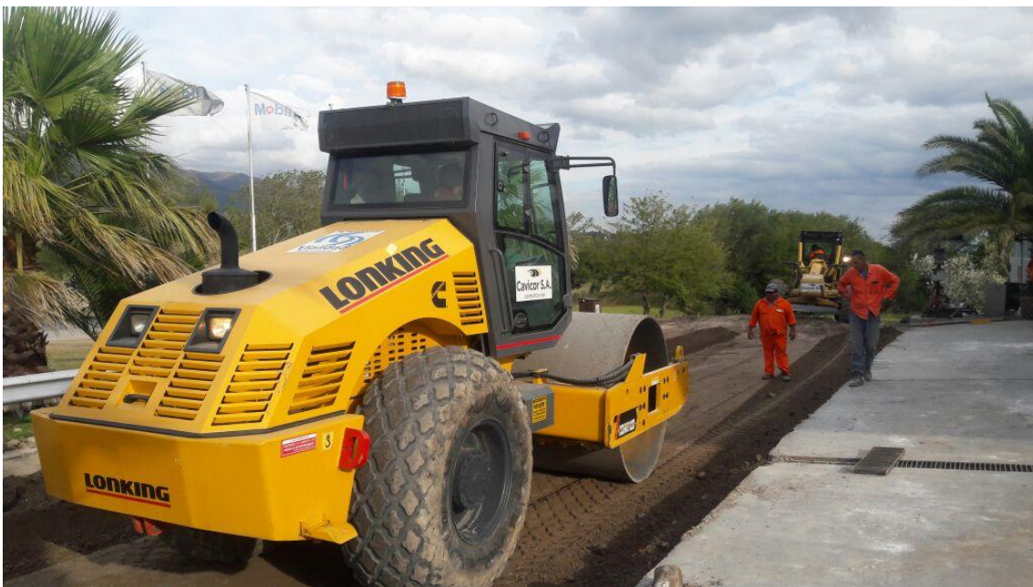
Imagen N°4: Compactación de base granular
