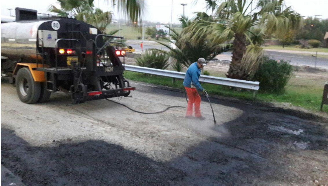
Imagen N°4: Colocación de riego de imprimación con lanza
