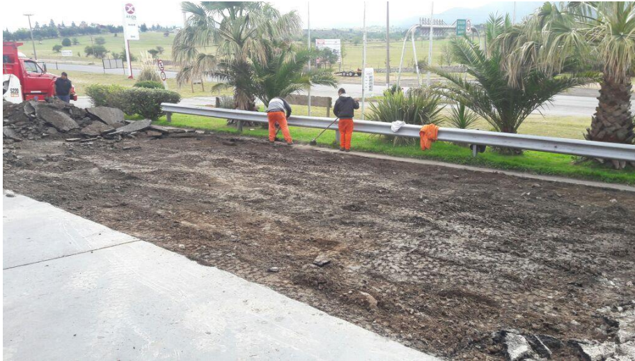
Imagen N°12: Limpieza en todas las etapas de la obra.
