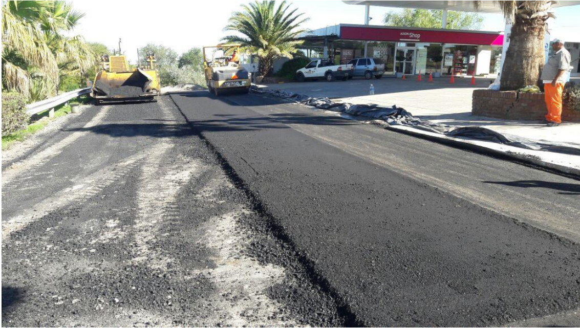
Imagen N°6: Colocación de carpeta de rodamiento.
