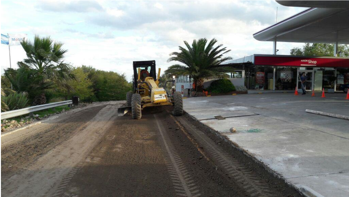
Imagen N° 3: Nivelación de la base granular
