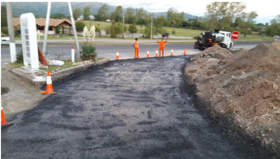
Imagen N°9: Riego de Imprimación en el polígono B (2)
