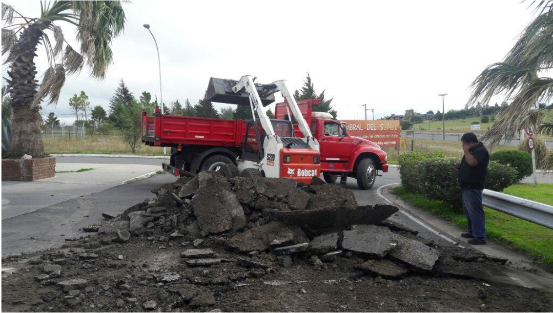
Imagen N° 1: Demolición y extracción de pavimento flexible
