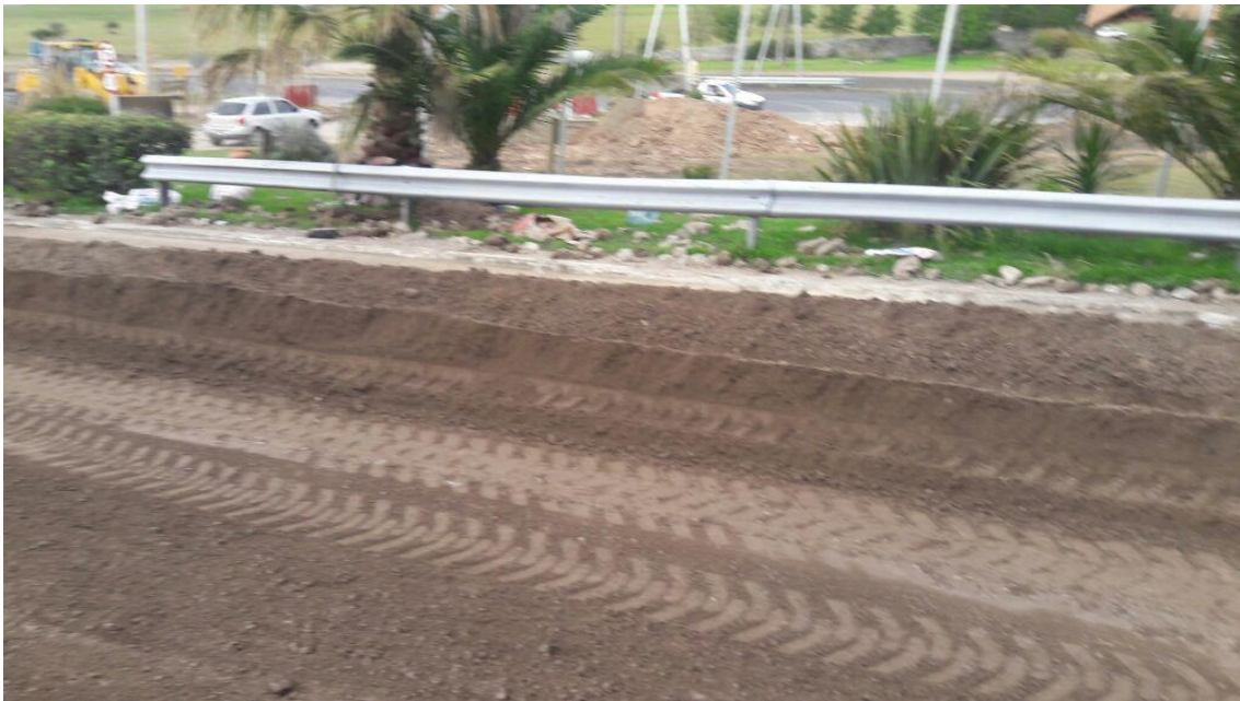
Imagen N°2: Mezclado de capa granular con motoniveladora
