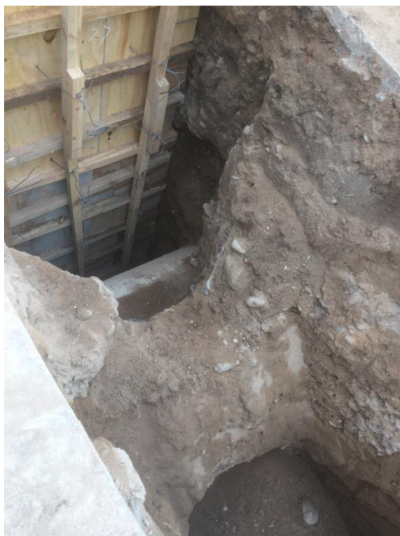
Figura N°3.3.1. Interferencia en calle Duarte Quirós. Pluvial diámetro 2000mm.
