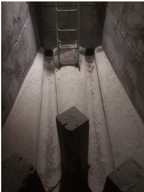
Figura N°4.6. Sifón Invertido en calle Duarte Quirós.
