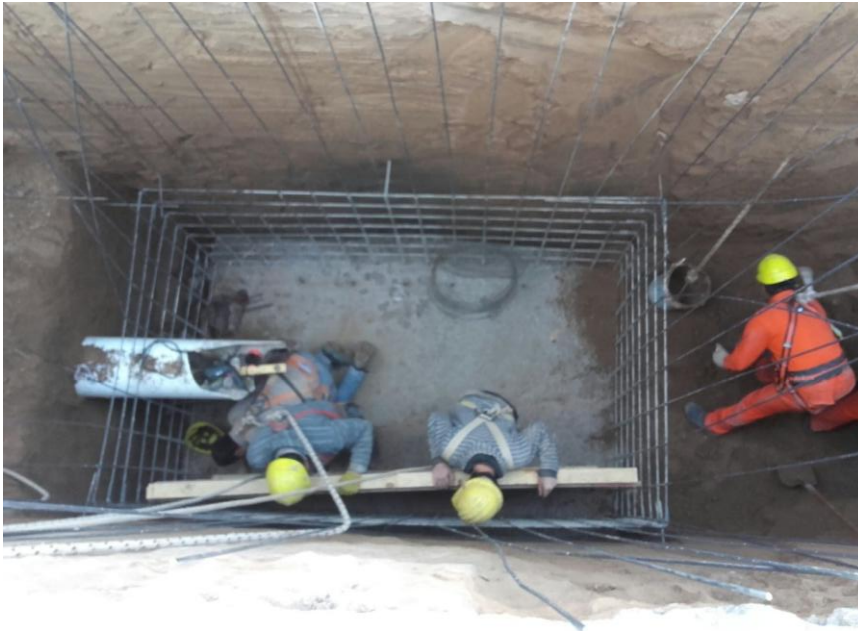
Figura N°4.3. Construcción de cámara (BR18)
