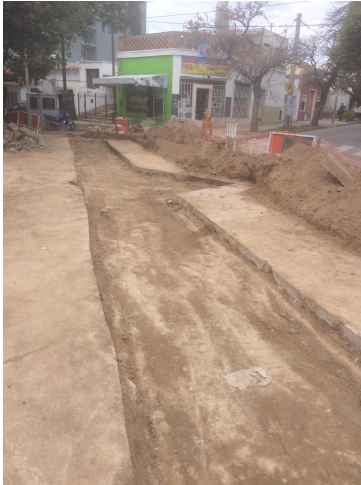
Figura 3.2.2. Ejecución de cruce de calzada en intersección Duarte Quirós y J.E.Echeverria.
