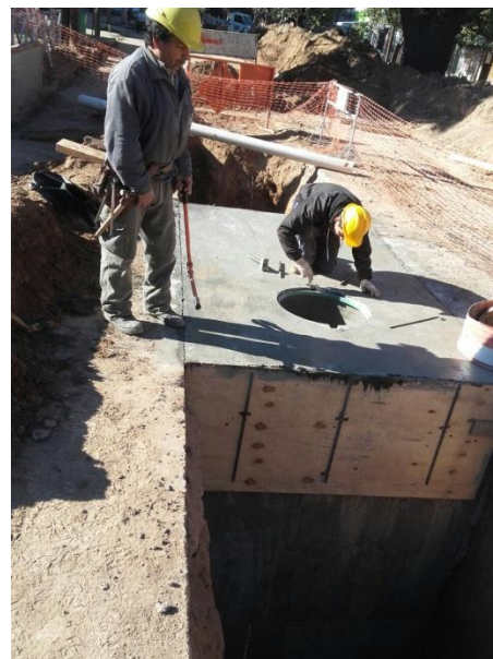
Figura N°4.5. Losa de cámara (BR18)
