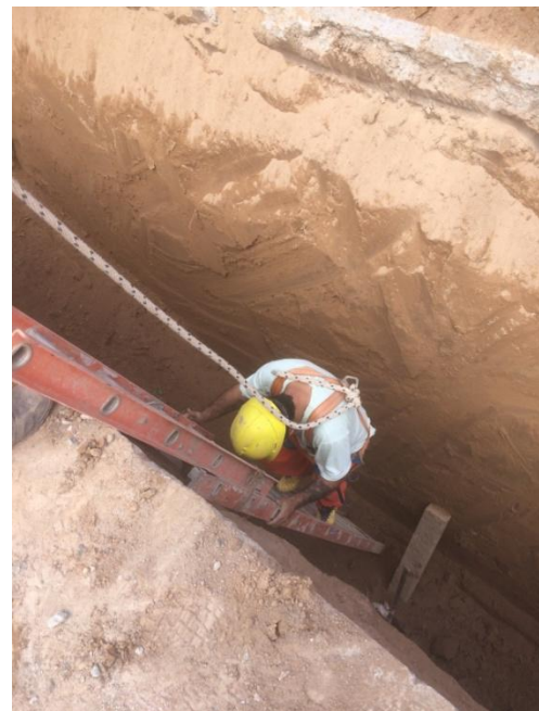
Figura N°4.2. Obrero con EPP.
