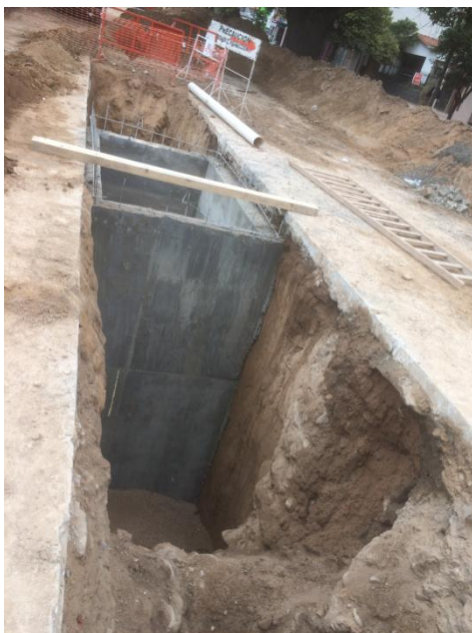
Figura N°4.4. Cámara de Hormigón Armado (BR18)
