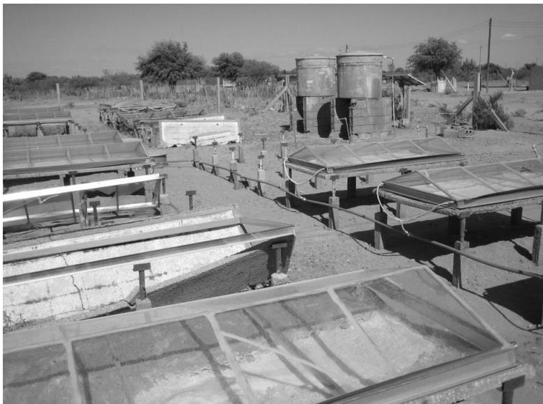
Figura 13.3: Desalinizadores en desuso, El Quemado, Dpto. Capayán (Catamarca). Ejemplo de fracaso de proyectos tecnológicos. © U. Karlin.
