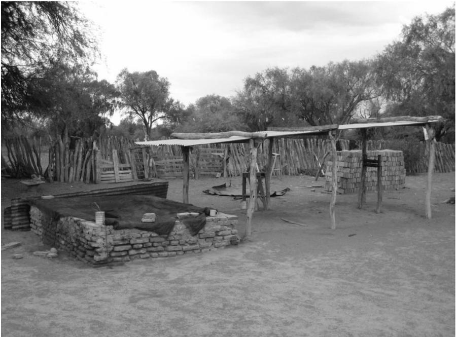
*Figura 5.13: Sistema de captación de agua de lluvia en La Suerte (Dpto. La Paz, Catamarca) © M. Karlin.*
