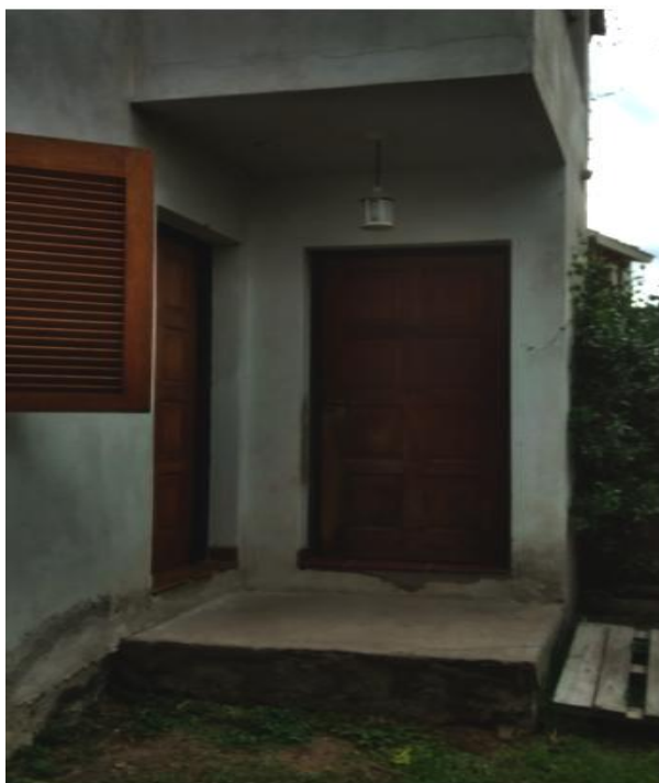
Figura 4.7: Puertas de ingreso a planta baja y a planta alta.
