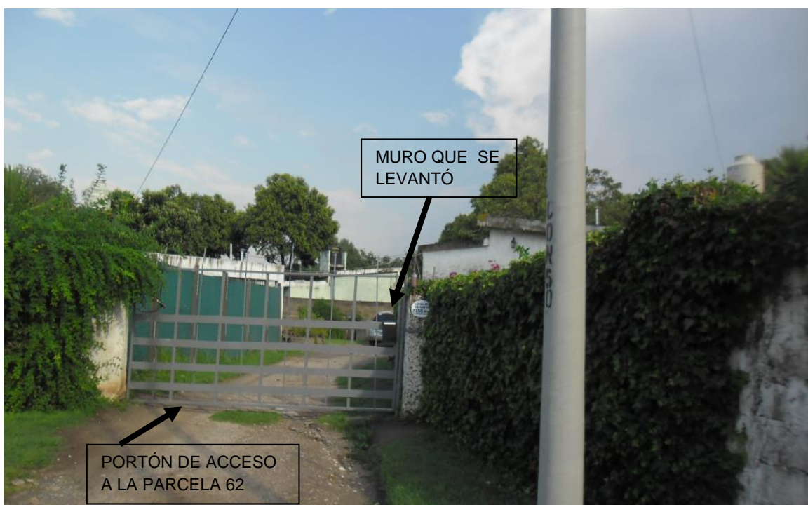
Figura 5.8: Portón de acceso que separa la parcela 61 (pasillo) de la parcela 62. Al fondo se puede observar el muro que separa la parcela 62 de la 56.
