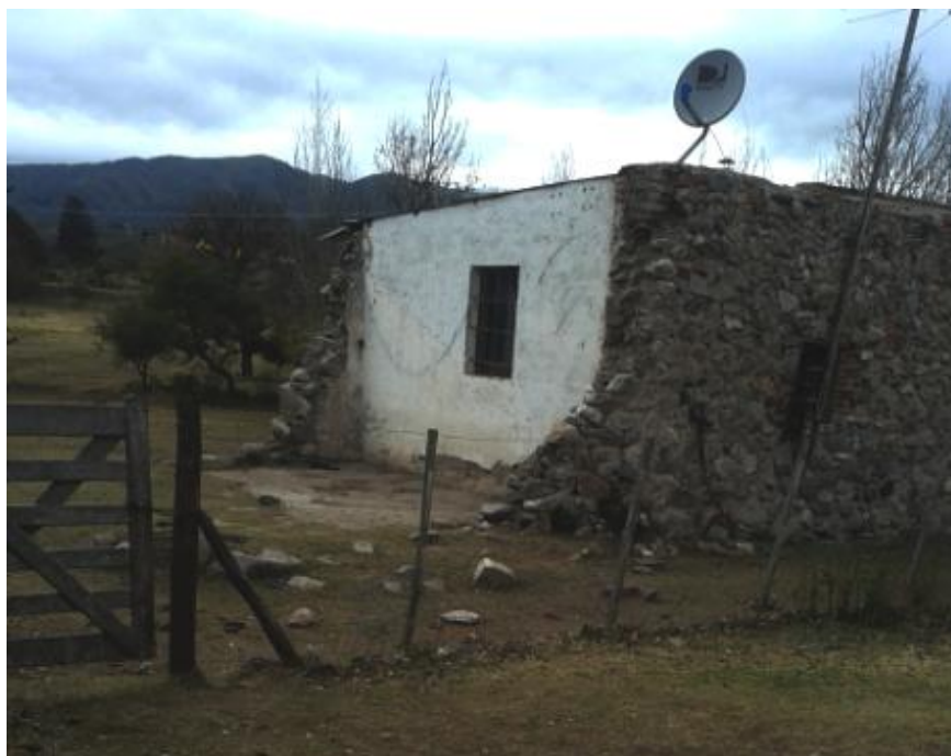
Figura 6.7: Casa dentro de la parcela 12 donde se aprecia la parte demolida.
