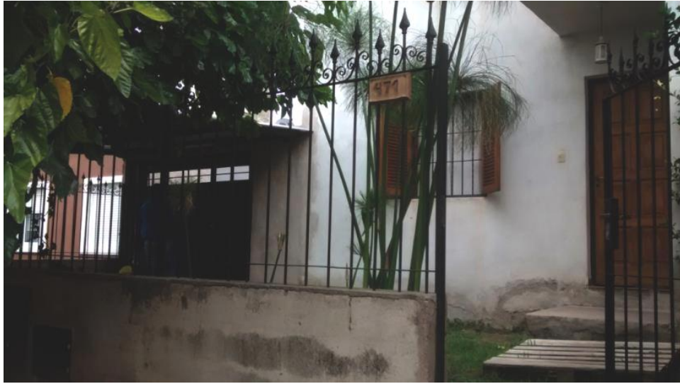
Figura 4.3 Fachada de la vivienda, donde se observa la planta baja.
