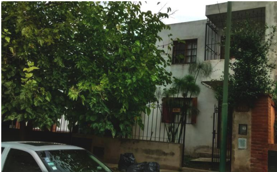
Figura 4.4 Fachada de la vivienda, donde se observa la planta alta y la planta baja.
