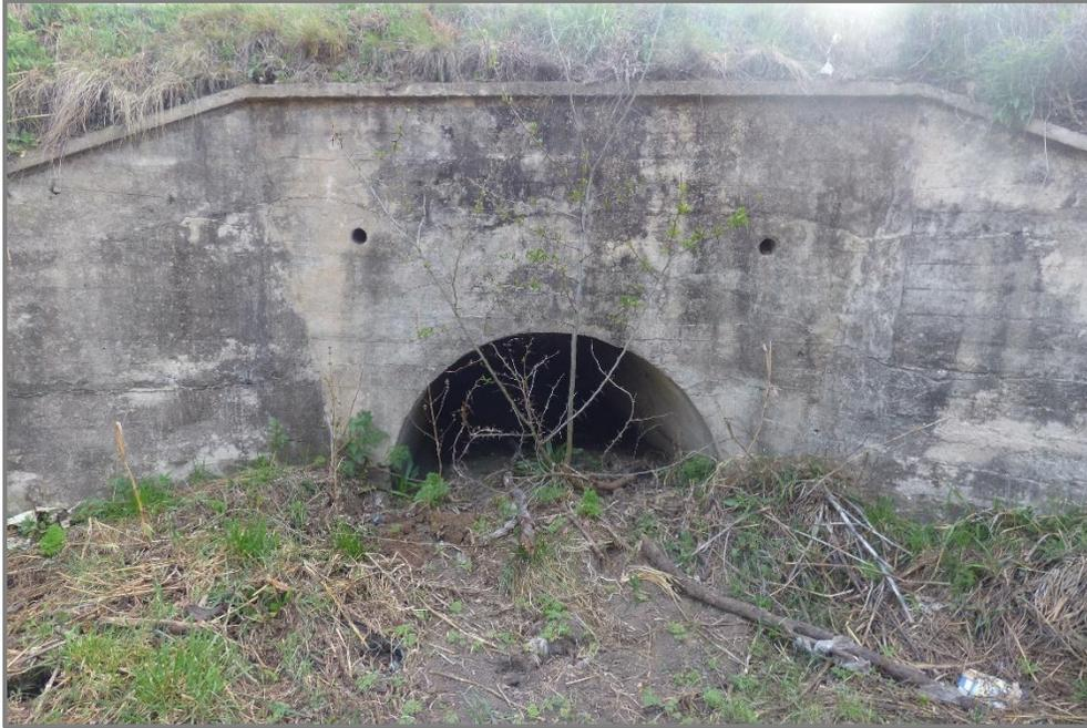
Figura 2.1. Alcantarilla de Cruce RPN°5. Sección Semicircular Radio=1m.
