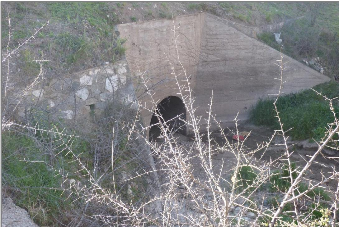
Figura 2.6. Alcantarilla de Cruce RPN°5. Sección Semicircular. Bajo Pronunciado.
