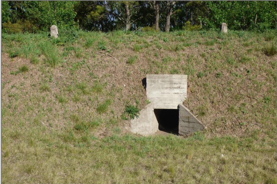
Figura 2.11. Alcantarilla de Cruce RPN°5. Sección Cajón 0,80m x 0,80m
