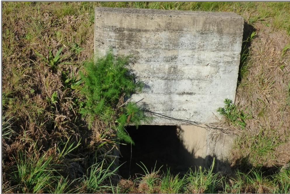
Figura 2.2. Alcantarilla de Cruce RPN°5. Sección Circular Diámetro=0,8m
