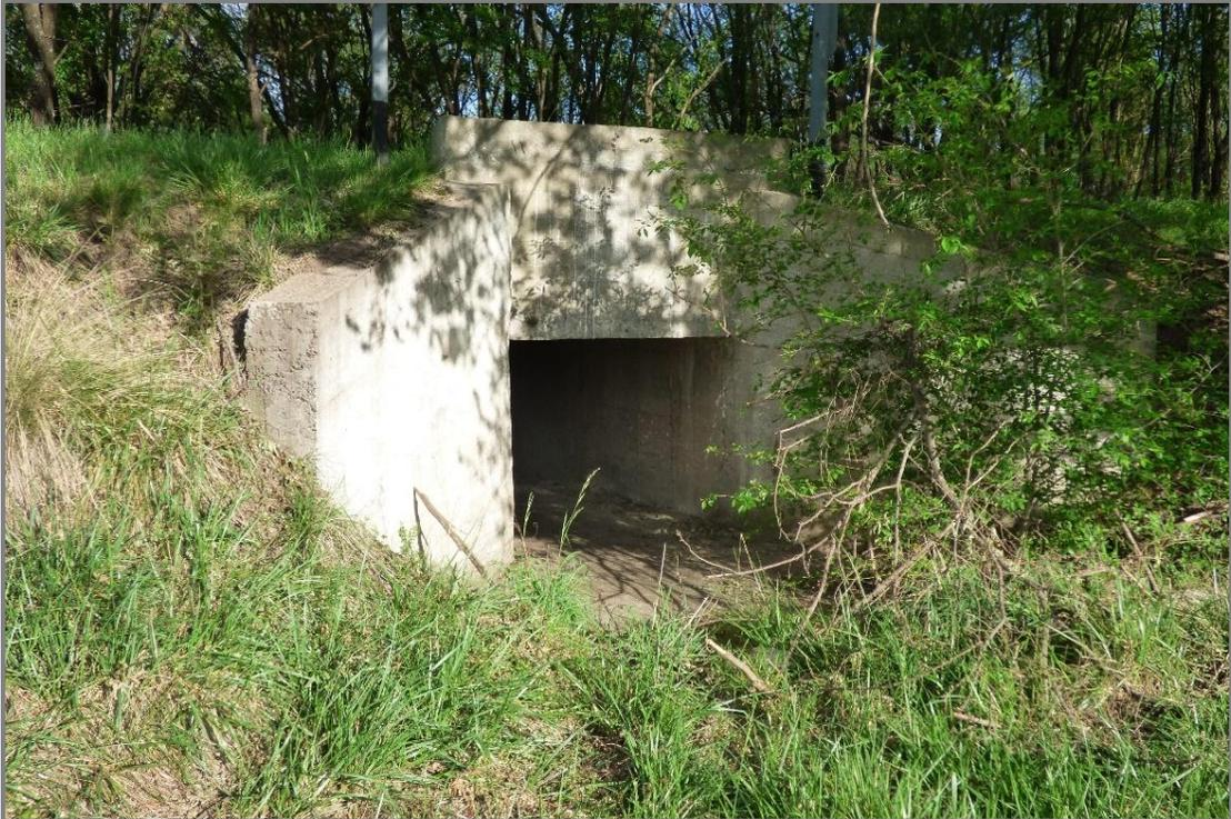
Figura 2.3. Alcantarilla de Cruce RPN°5. Sección Cajón 1,55m x 1,20m
