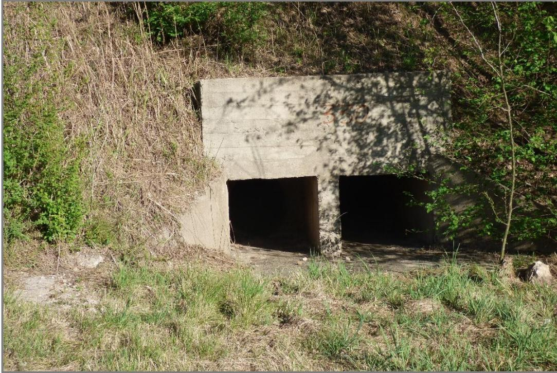
Figura 2.9. Alcantarillas de Cruce RPN°5. Dos de sección circular. Diámetro=0,80m
