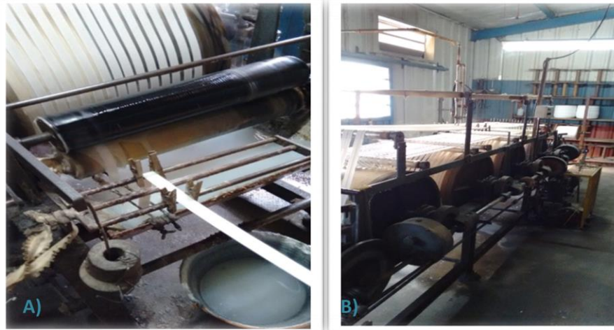
Imagen 3.20: A) Entrada dispositivo de planchado B) Imagen lateral dispositivo de planchado. Fuente: Imagen propia tomada con autorización de dirección.
