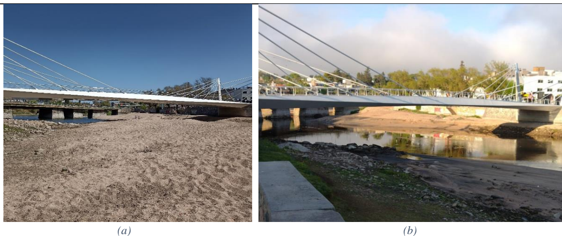
Figura 76.- Imágenes del punto fijo 4 (a) antes del evento (24/09/2021) y (b) después del evento de crecida (14/10/2021)
