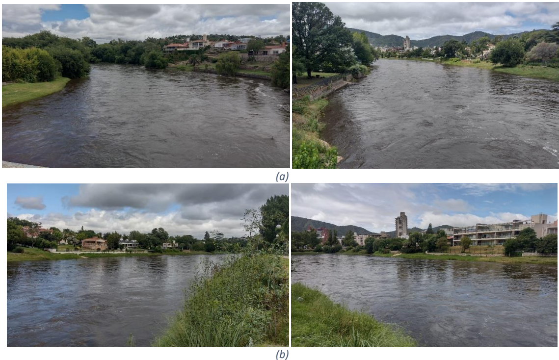
Figura 104.- Imágenes capturadas durante el evento de crecida del día 23/01/2022 13:20 hs, desde el punto fijo 1 (a) hacia aguas arriba (b) hacia aguas abajo y punto fijo 2 (c) hacia aguas arriba y (d) hacia aguas abajo.
