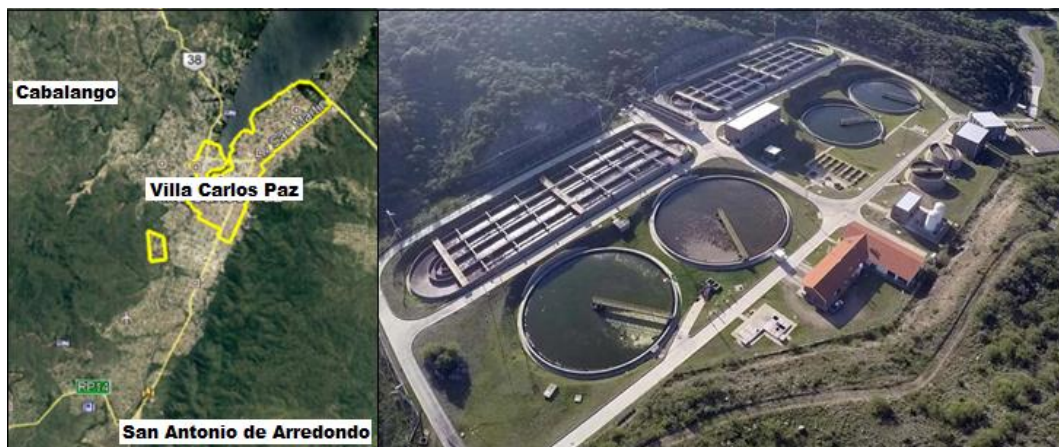
Figura 6. A la izquierda, cobertura de la región norte de la Cuenca del río San Antonio –año 2019–. A la derecha, la planta depuradora de la Variante Costa Azul. Fuente: COOPI
