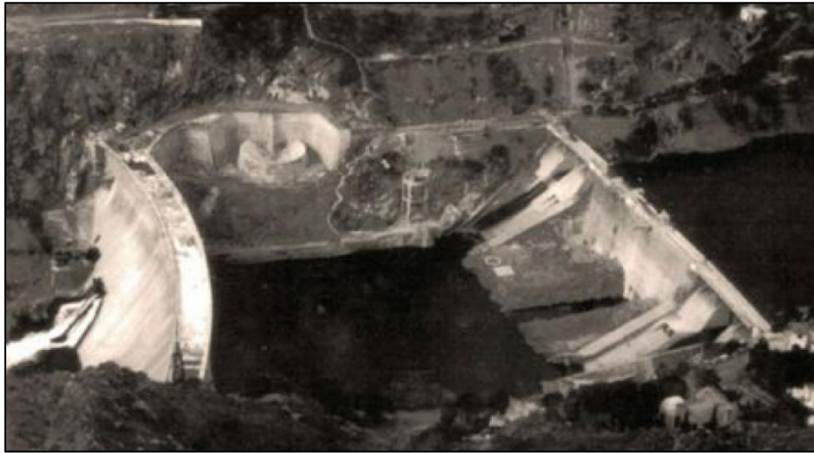
Figura 2. Visualización del cierre original, de cal hidráulica local, y del cierre actual, de cemento portland. Fuente: Archivo Eldor Bertorello.
