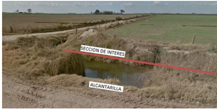
Figura 74. Vista desde el Google Street View de la salida de la alcantarilla y la sección de interés a relevar
