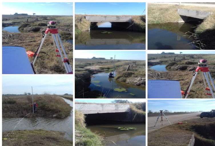
Figura 73. Vistas de la alcantarilla en cuestión e instrumental utilizado
