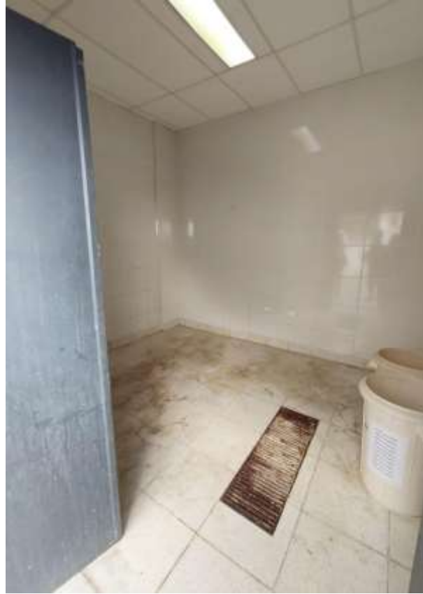
Imagen 10: Paredes azulejadas de depósito final.
