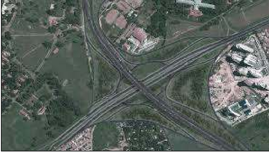
Figura 20 Imagen render Obra Distribuidor Tropezón
