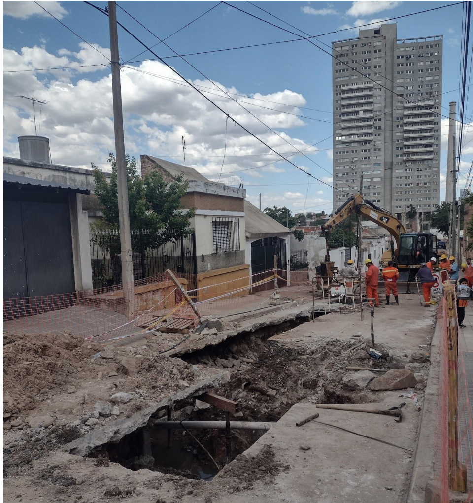
Imagen 7: En primer plano, obras realizadas a partir del desborde cloacal del 12 de octubre de 2021. De fondo, las torres construidas por Euromayor en el predio de la Cervecería Córdoba. Fuente: Autoras, 2021.
