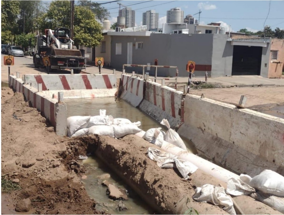
Imagen 3: Líquidos cloacales contenidos por “vallas” de hormigón en la calle Justo Páez Molina. Fuente: Autoras
