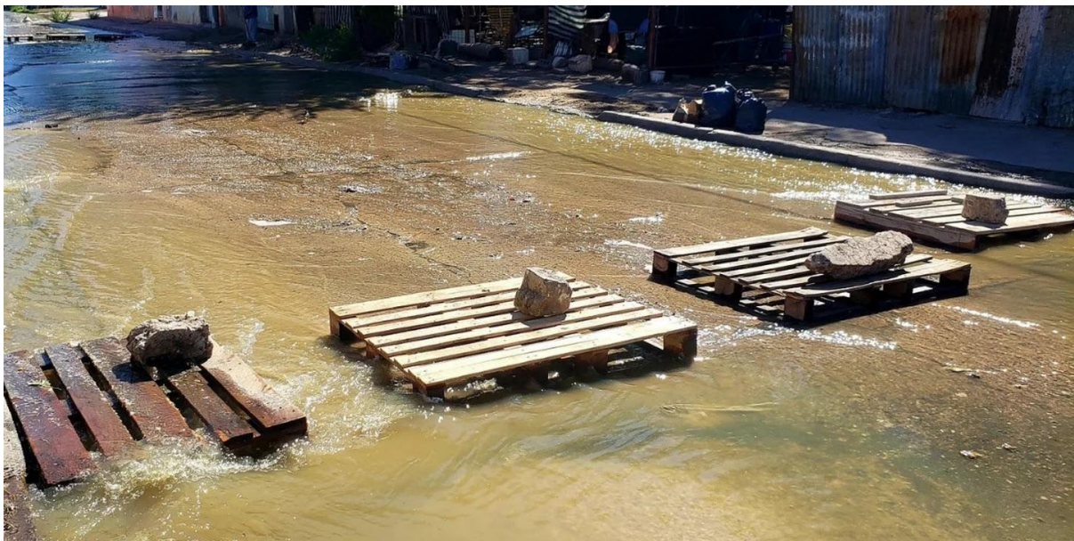
Imagen 5: Puente de palets armado por vecinos en la calle Ángel Roffo. Aguas cloacales corriendo de cordón a cordón. Fuente: Cadena 3
