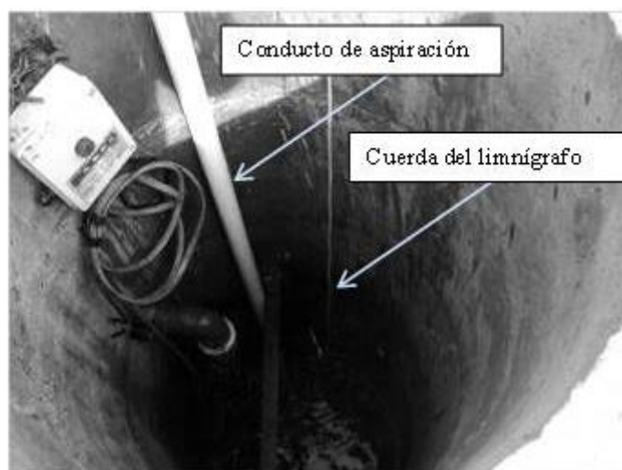
Figura 3.- Montaje de conductos y sensores en el interior del pozo
