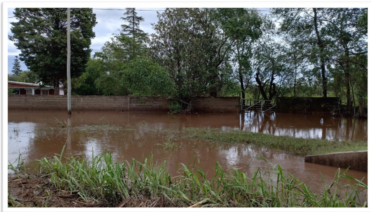
Fotografía 5. Cuneta y casa inundada sobre RP N° 5.
