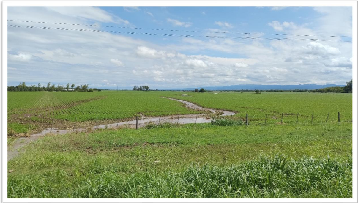
Fotografía 19. Daños por erosión en surcos en lote aguas abajo, misma ubicación que Fotografía 17.
