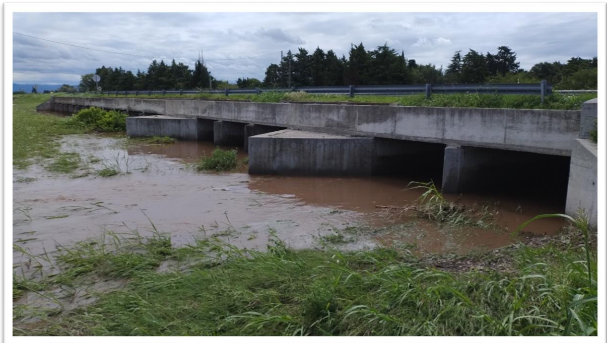
Fotografía 26. Batería de alcantarillas sobre ruta C-45, aguas abajo.
