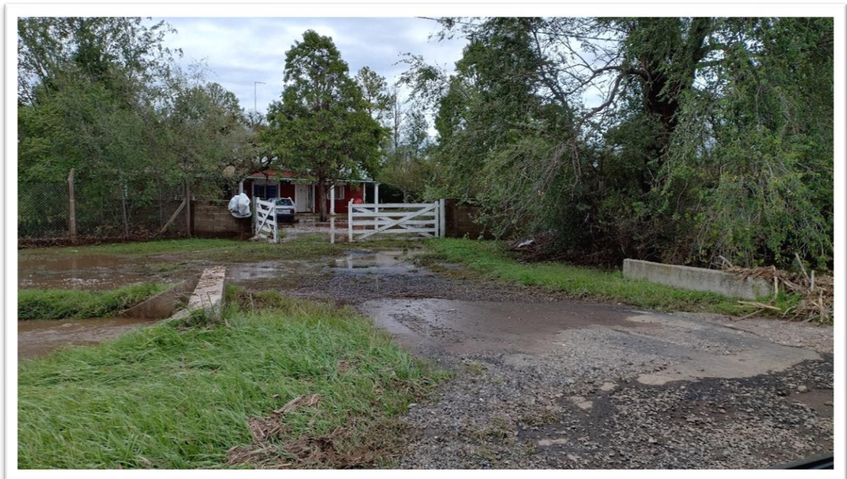
Fotografía 12. Casa inundada sobre RP N° 5 llegando a Villa del Prado. Todavía salía agua del parque de la casa.
