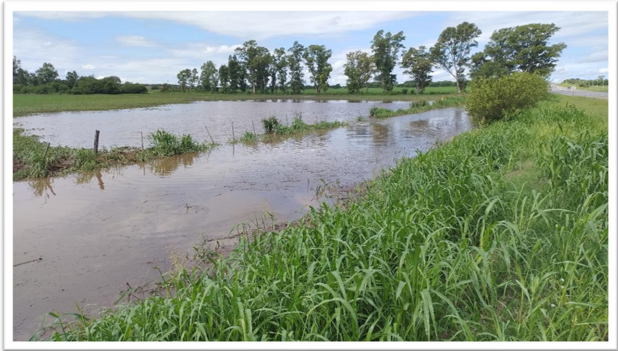
Fotografía 21. Cuneta y lote agrícola anegado sobre ruta C-45.
