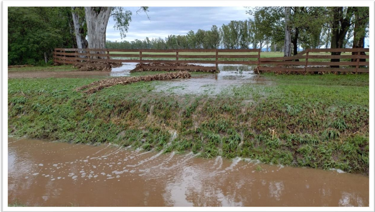
Fotografía 9. Esguerrimiento saliendo de campo sobre la RP N° 5, donde se observa el color oscuro del agua, arrastre de rastrojo y daños en el cerco.
