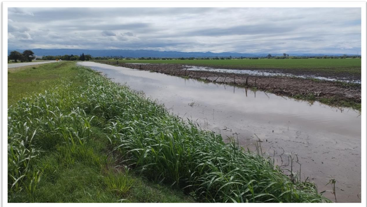
Fotografía 20. Cuneta y lote agrícola anegado sobre ruta C-45, donde se pueden observar daños en los cultivos y alambrados.
