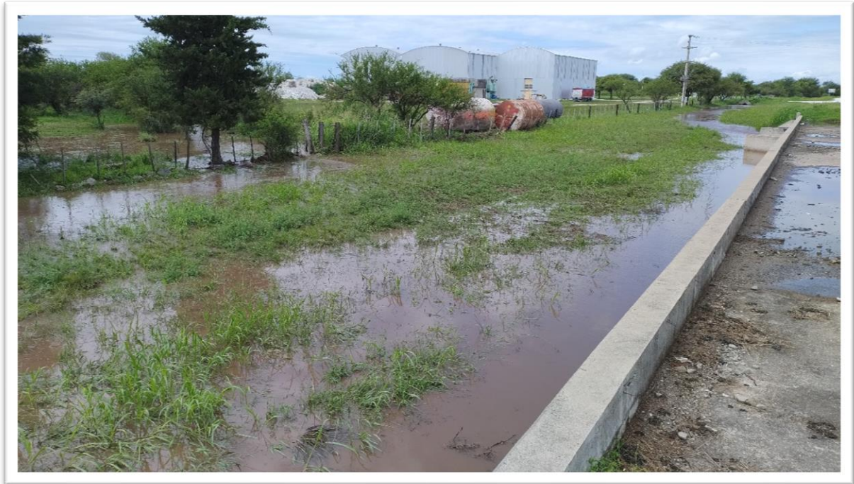
Fotografía 17. Esguerrimiento saliendo de un predio industrial sobre ruta C-45, con dirección al alcantarillado.
