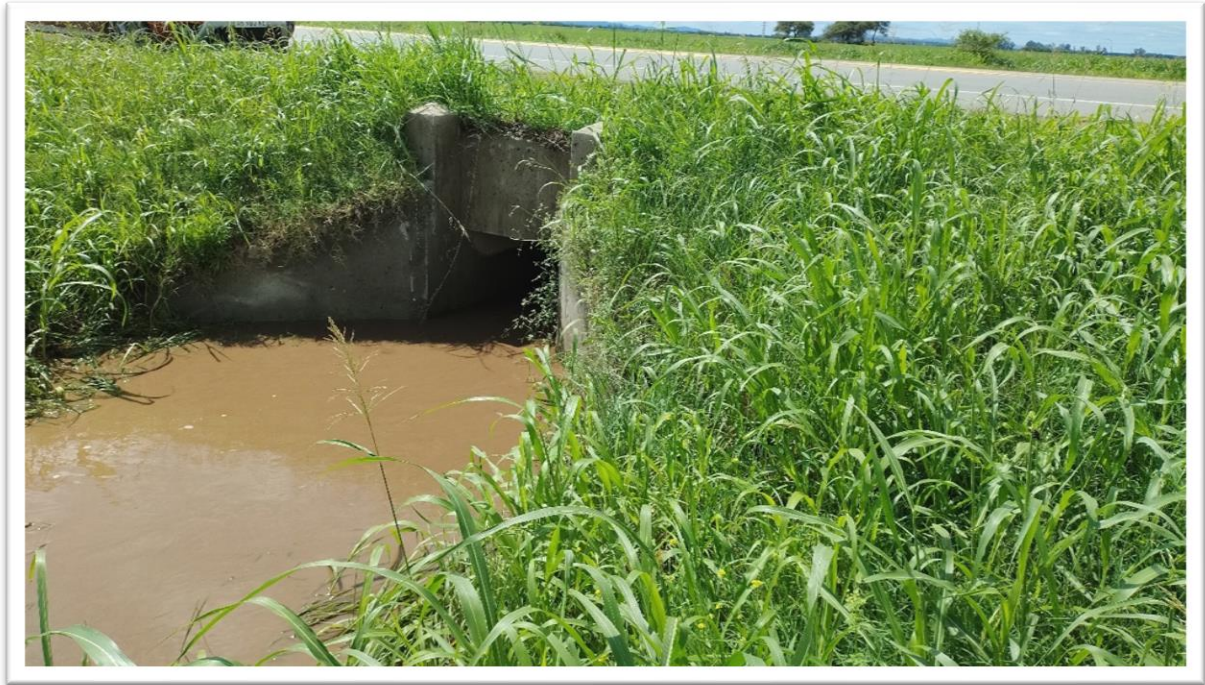
Fotografía 27. Alcantarilla sobre ruta C-45.
