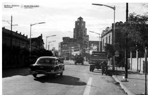
Al fondo, fachada de la Escuela Yrigoyen, en las esquinas de las actuales Castro Barros y Brandsen (barrio San Martín). Fuente: Inv. 2662. Archivo Histórico Municipal
