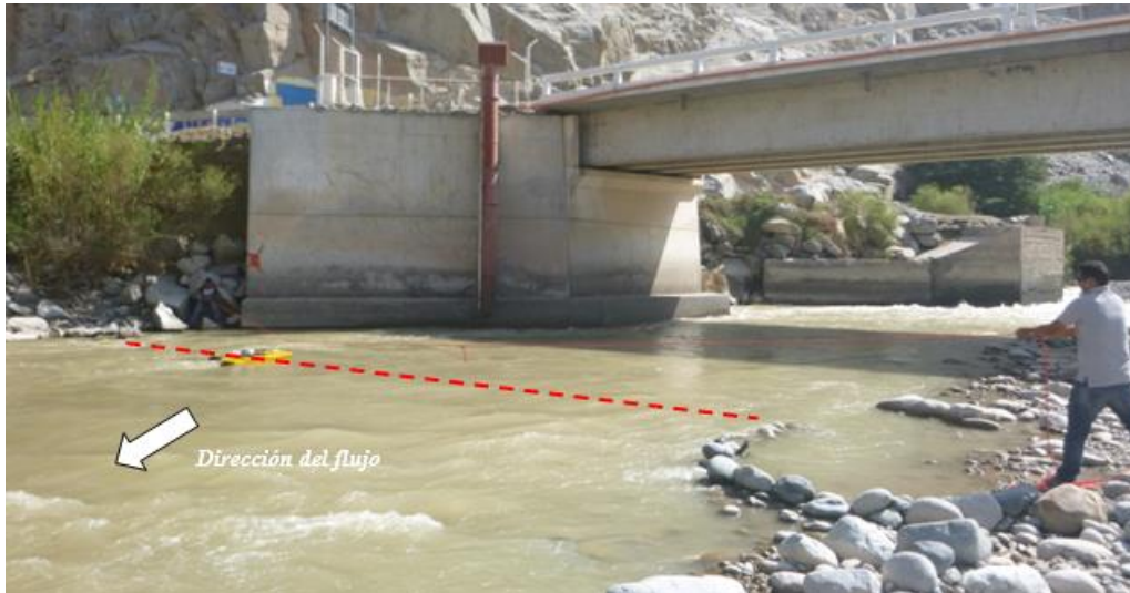
Figura 9. Condición hidrológica en sección Puente La Quinga – 23/04/2015
