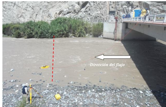
Figura 5. Aforo de caudal en sección Puente la Quinga – 29/01/2015
