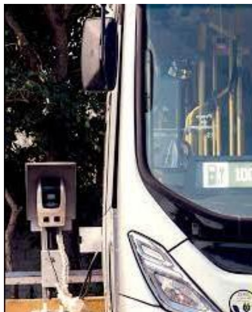
Figura 5 - Cargador conectado a un autobús eléctrico
