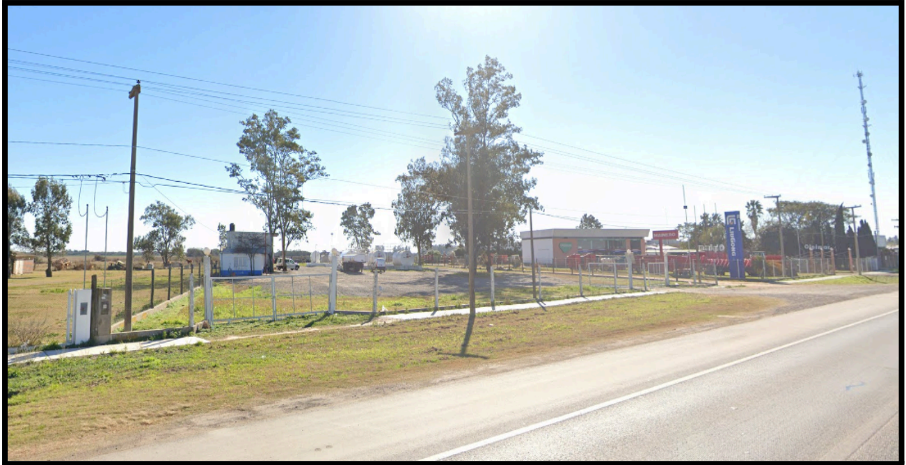
Figura N° 18 – “Imagen frontal de la Instalación N°2”
