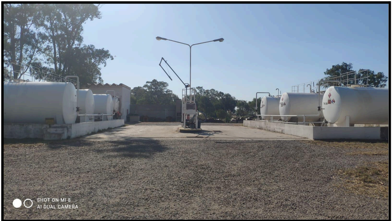
Figura N° 24 – “Sector de descarga y almacenamiento de combustibles”
