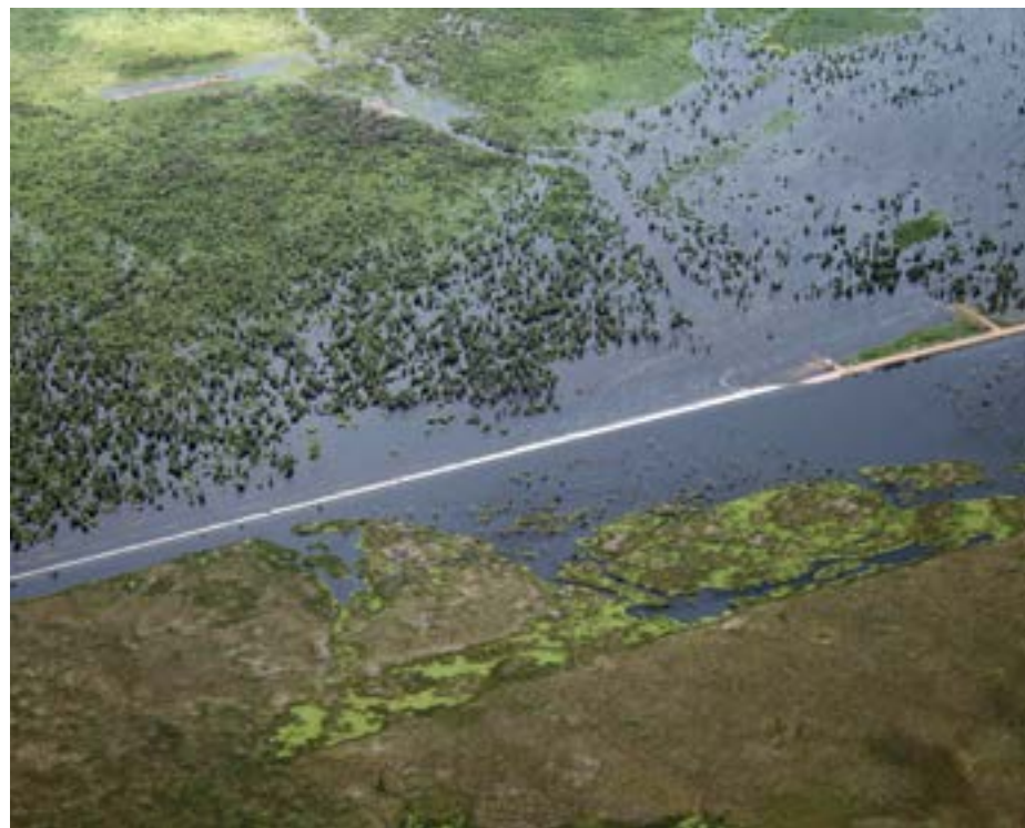
VISTA AÉREA DEL VERTEDERO SOBRE LA RUTA PROVINCIAL 28, PROVINCIA DE FORMOSA.
