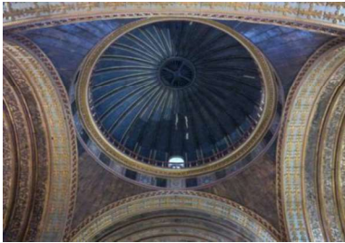
Imagen 17: fotografía actual de la cúpula de la iglesia. Se observa la pérdida total de las pinturas después del incendio de 1961.
