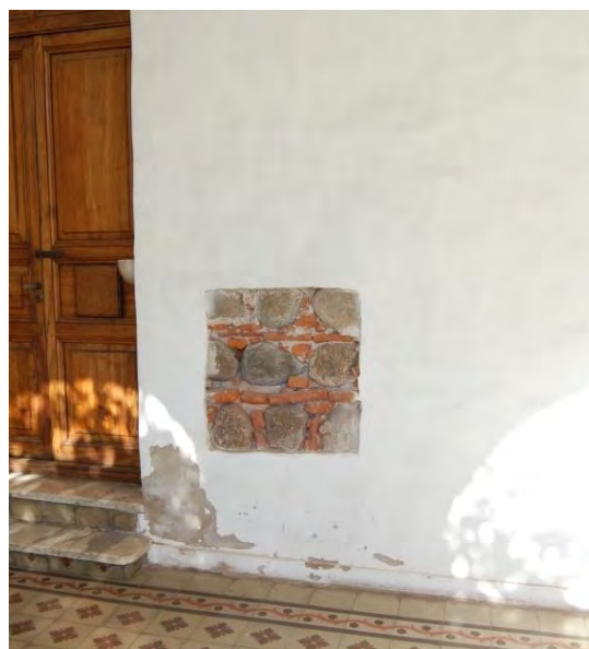
Imagen 16: fotografía actual de una ventana arqueológica realizada en 1978/9. Se puede observar la fábrica del muro de la capilla.
