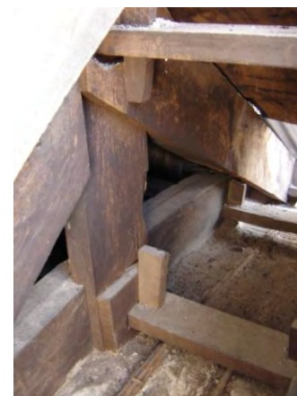
Imagen 16: fotografía actual, detalle de la estructura de madera de la cubierta.
