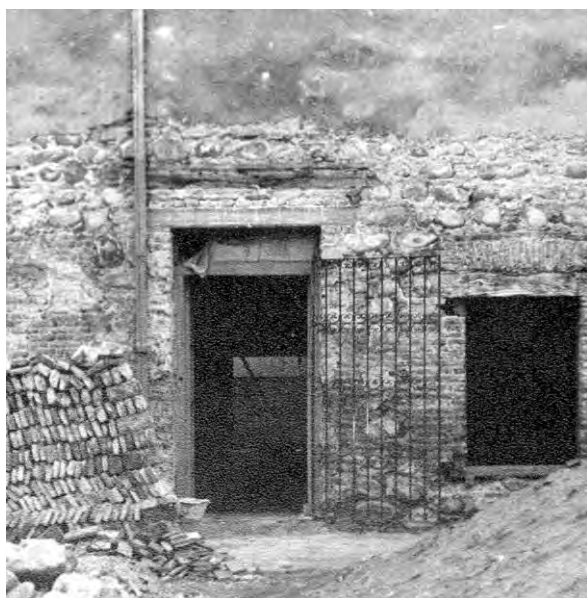
Imagen 15: fotografía de la intervención realizada en 1978/9 (Instituto Marina Waisman – UCC). Se puede observar la fábrica de muros y aberturas.
