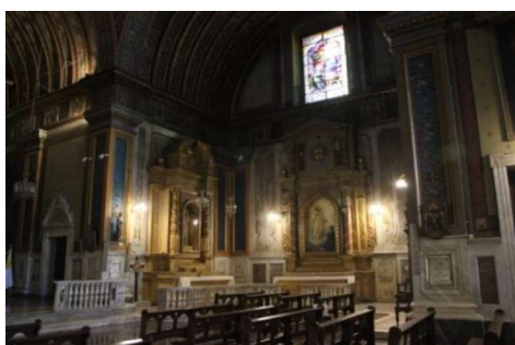
Imagen 27: fotografía actual del crucero del lado de la Epístola.
