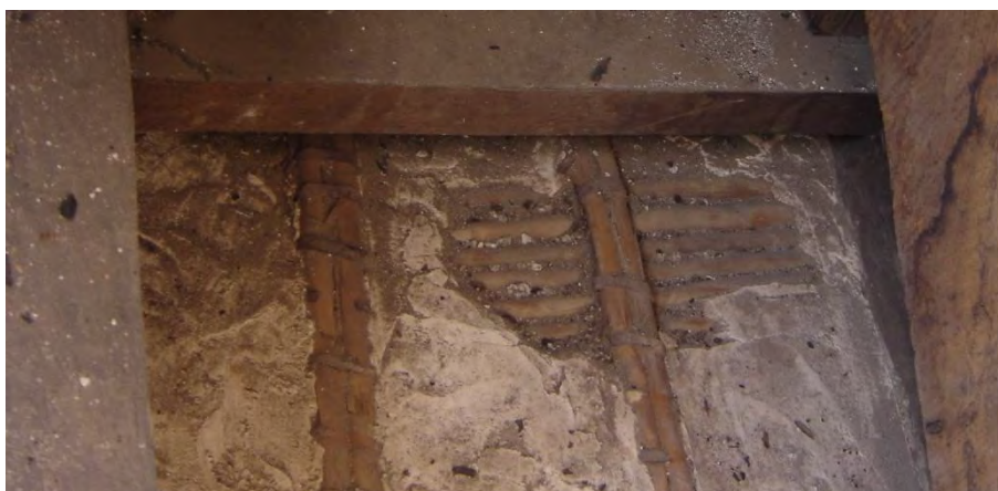
Imagen 18: disposición y sujeción de las cañas en el techo de la capilla del Noviciado
