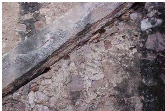
Imagen 10: fotografía actual del muro del transepto (Oeste). Detalle de las capas de tejas.
