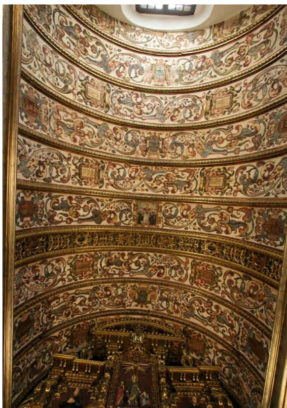
Imagen 9: fotografía de la bóveda completa.
