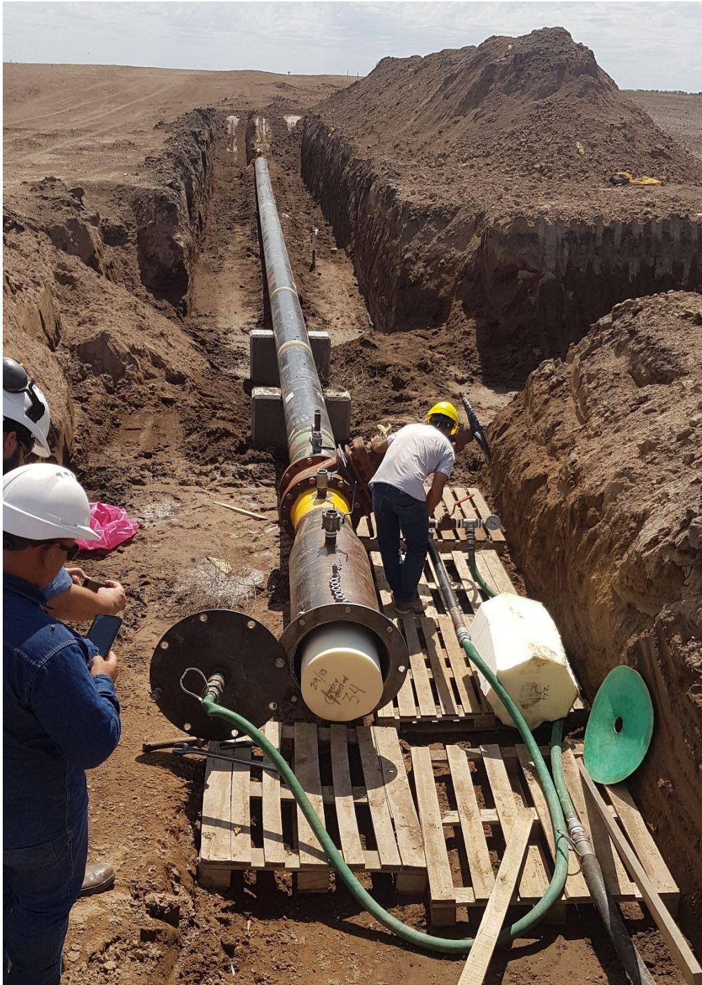
Colocación del elemento de limpieza firmado por la inspección del cliente.
