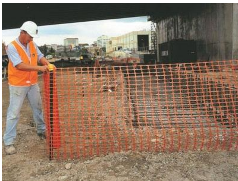
Ejecución del vallado de la zona de obra.
