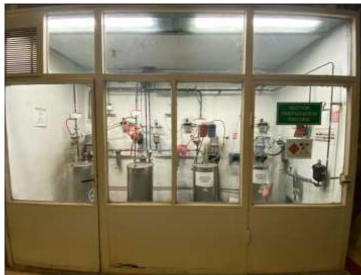
Figura 4.31: "Sector de preparación de pintura"
