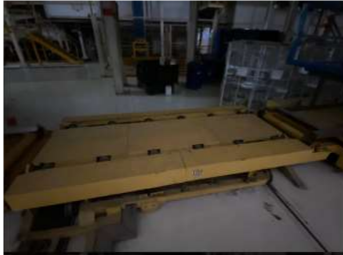
Figura 4.55: “Dispositivo de traspaso de cintas transportadoras”
