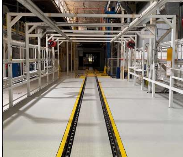
Figura 4.42: “Área de Inspección”
