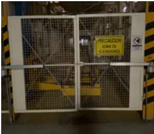
Figura 4.49: “Portón de ingreso a Área de preparado”
