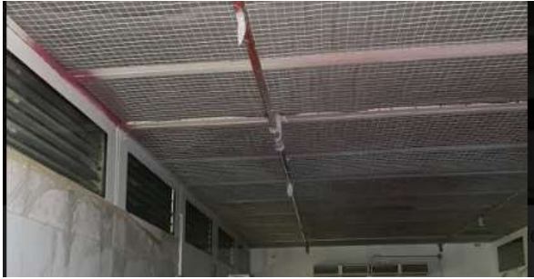
Figura 4.28: "Techos con filtros"
