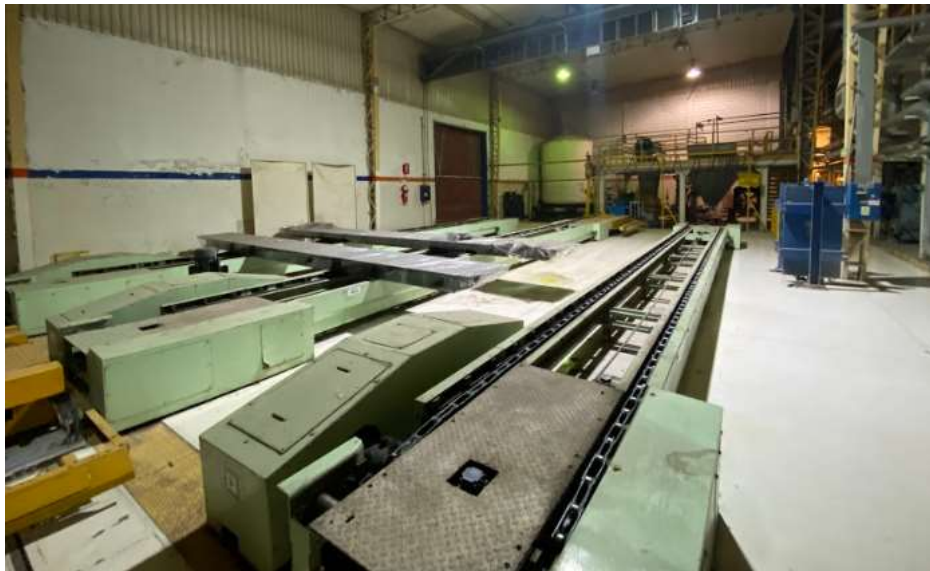
Figura 4.3: “Almacén de Cabinas”
