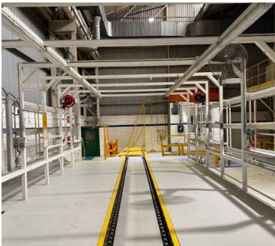
Figura 4.13: “Celda de Inspección”
